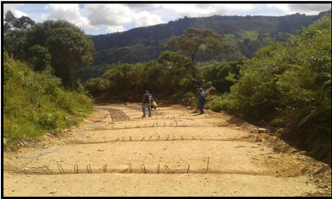
Figura 28: Colocación acero de refuerzo tramo 3. Fuente: Propia.
