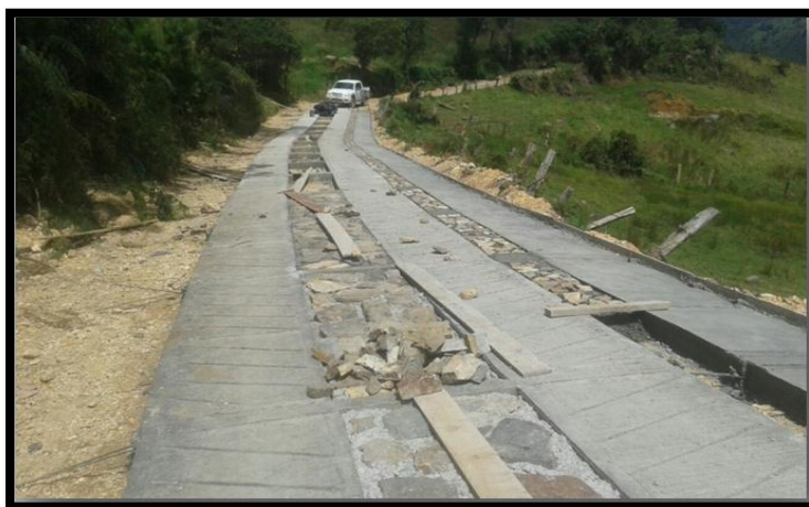
Figura 31: Fundición de cunetas y concreto ciclópeo. Fuente: Propia
