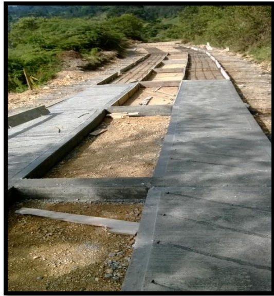
Figura 33 y Figura 34: Acero de refuerzo y fundición cinta tramo 2. Fuente: Propia.
