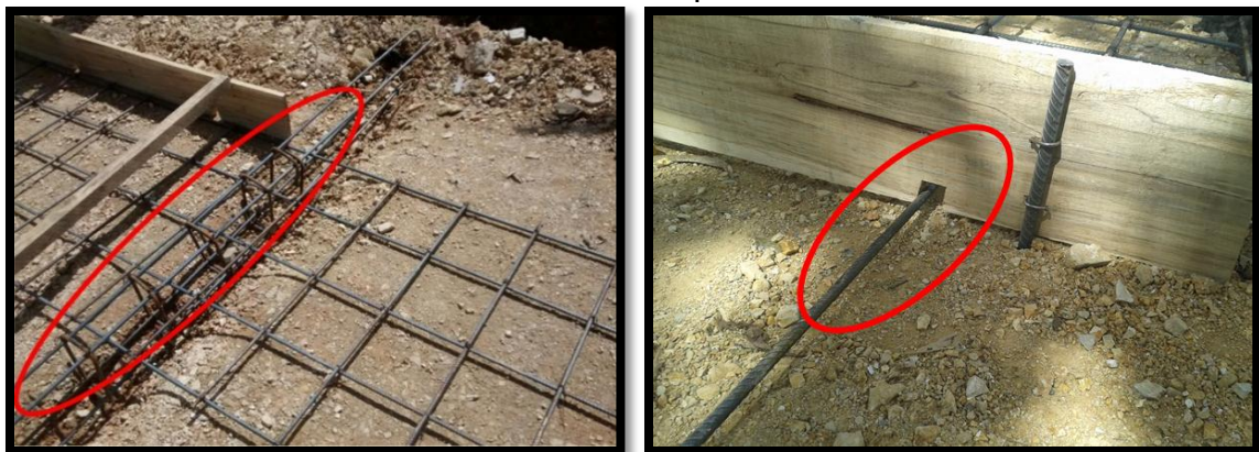
Figura 51: Corrección en parrillas para las cintas. Fuente: Propia.
