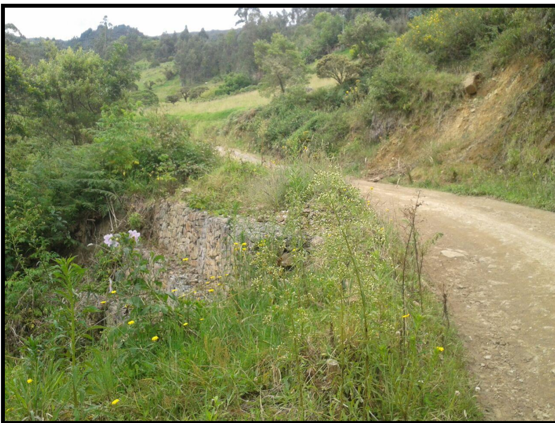
Figura 37: Muro en gavión K4 + 100 m. Fuente: Propia.
