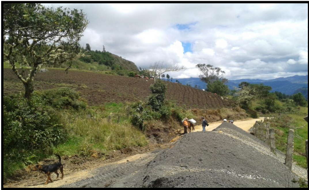
Figura 17: Acopio de los agregados. Fuente: Propia.
