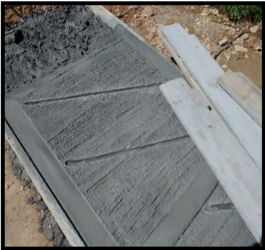
Figura 35 y Figura 36: Fundida cinta en concreto y concreto ciclópeo tramo 1. Fuente: Propia.
