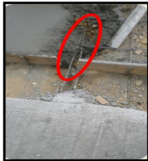
Figura 38 y Figura 39: acero de refuerzo no cumple con la geometría de la viga.
