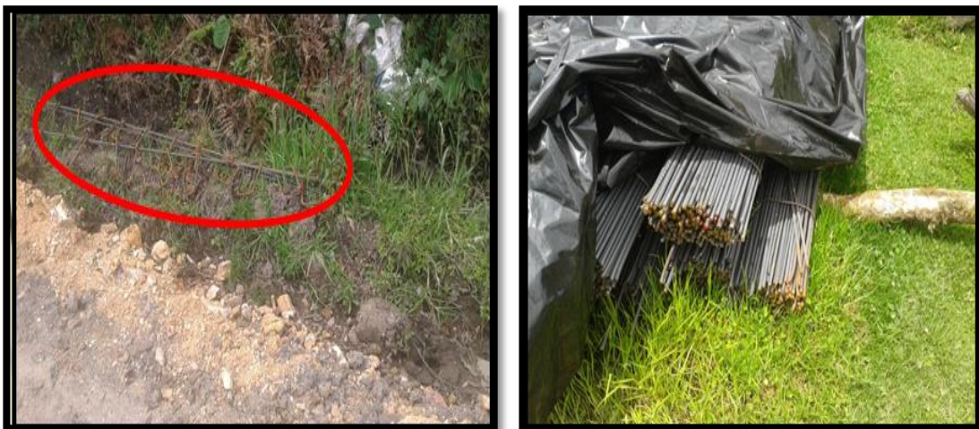
Figura 46 y Figura 47: Acopio acero de refuerzo.
