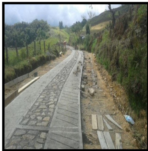
Figura 35 y Figura 36: Fundida cinta en concreto y concreto ciclópeo tramo 1. Fuente: Propia.
