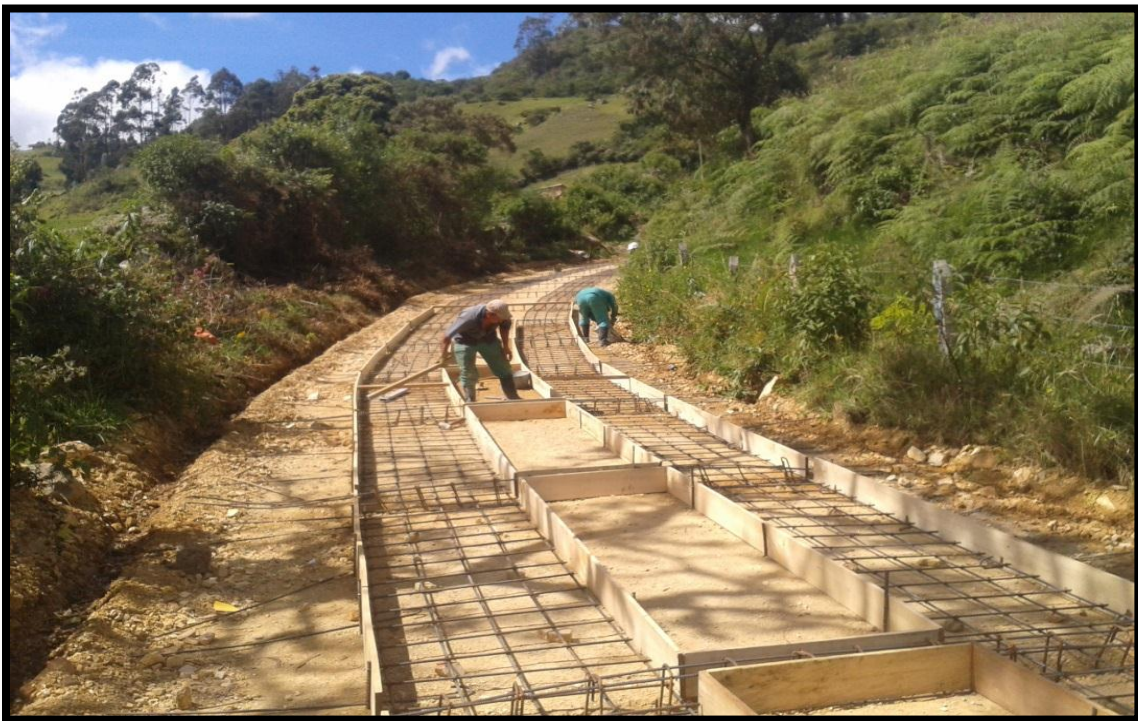
Figura 32: Instalación de formaleta tramo 2.
