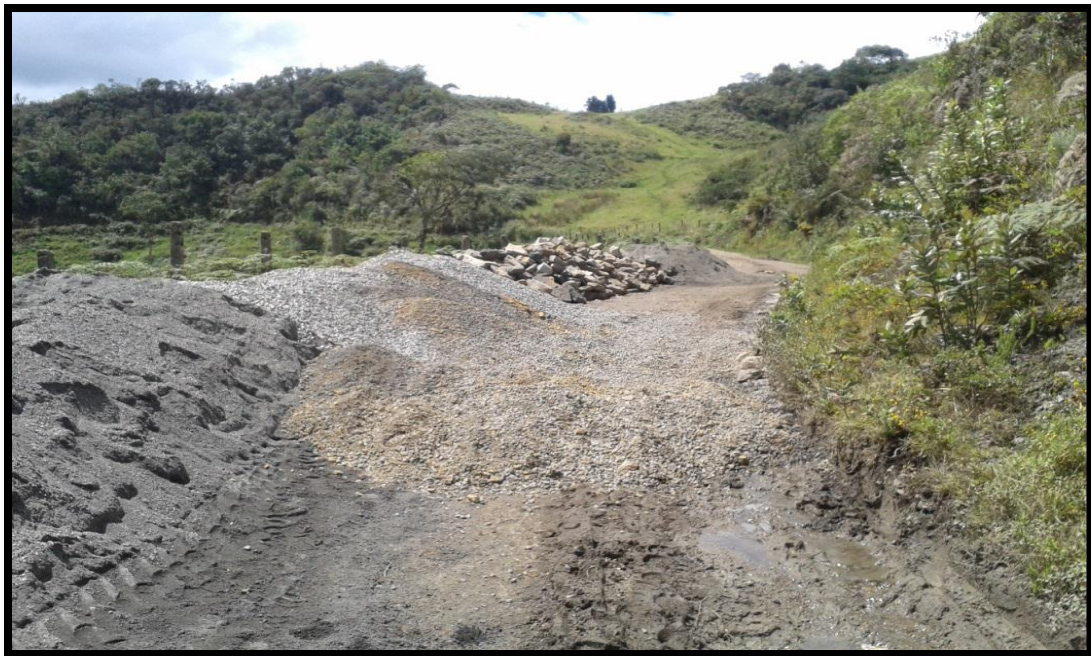
Figura 18: Acopio de los agregados. Fuente: Propia.
