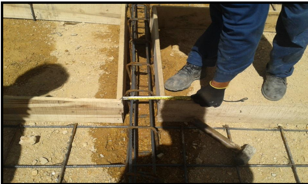
Figura 29: Instalación formaleta tramo 3. Fuente: Propia.
