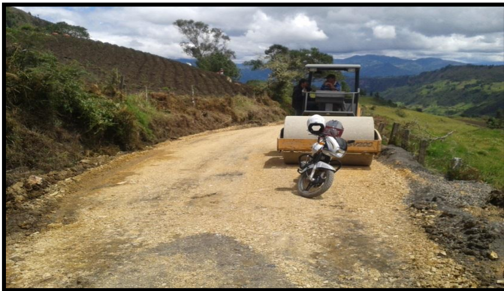
Figura 22: Trabajo vibro-compactador. Fuente: Propia.
