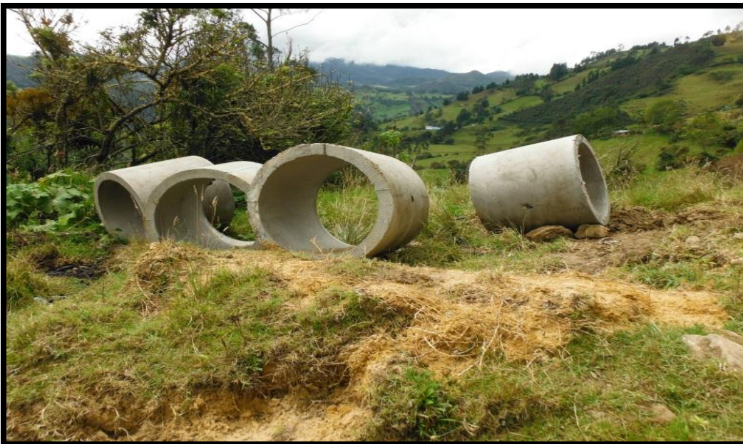
Figura 16: Acopio tubos de concreto reforzado. Fuente: Propia.
