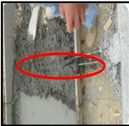
Figura 38 y Figura 39: acero de refuerzo no cumple con la geometría de la viga.
