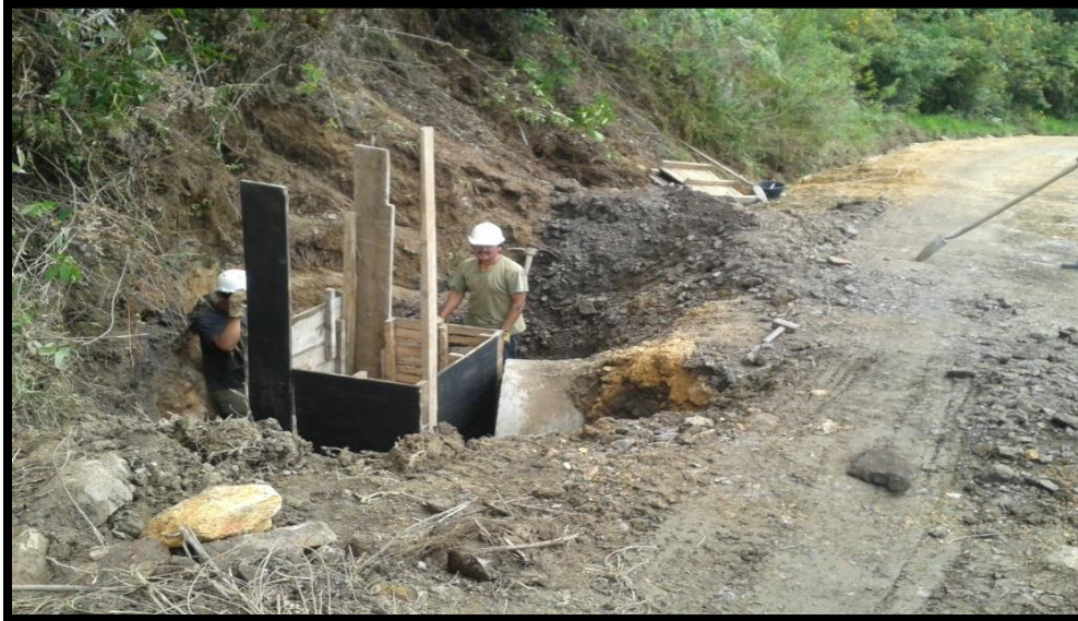
Figura 25: Alcantarilla No. 1. Fuente: Propia.
