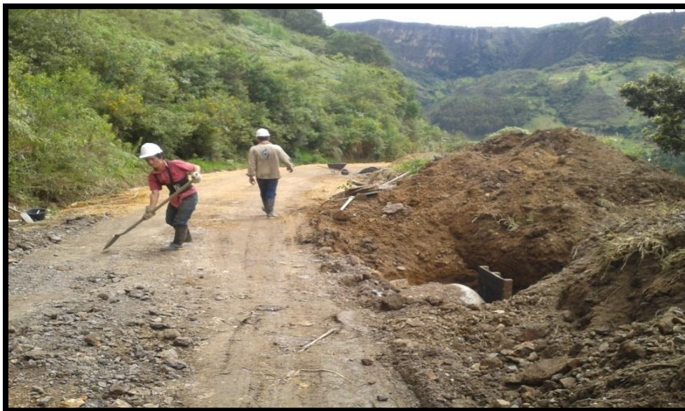
Figura 26: Alcantarilla No. 2. Fuente: Propia.
