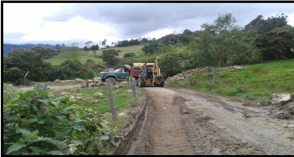
Figura 21: Trabajo retroexcavadora. Fuente: Propia.
