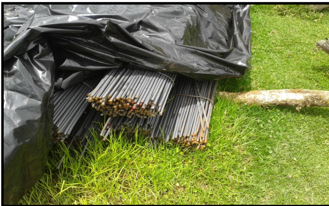
Figura 20: Acopio de acero de refuerzo. Fuente: Propia.
