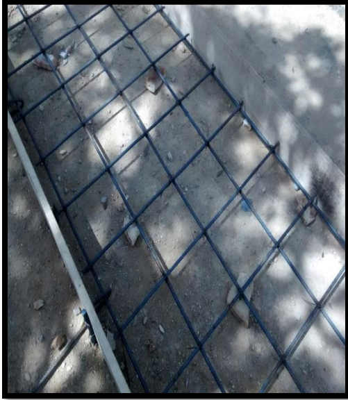
Figura 33 y Figura 34: Acero de refuerzo y fundición cinta tramo 2. Fuente: Propia.
