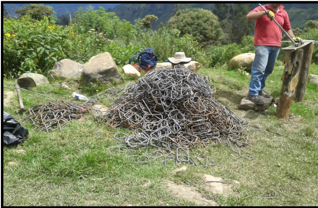
Figura 19: Acopio de los estribos para viga riostra. Fuente: Propia.
