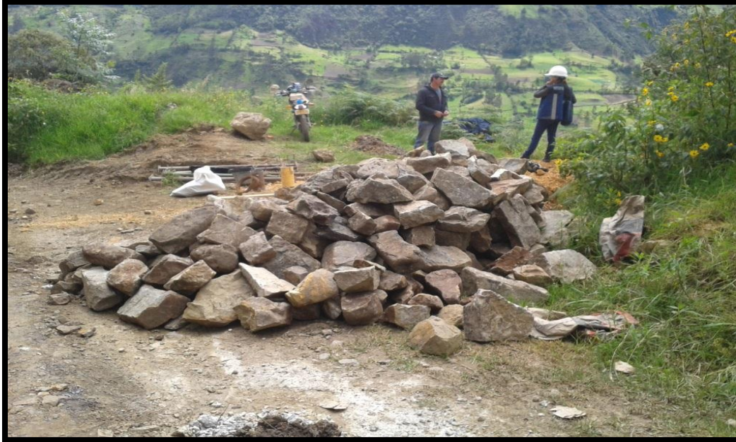
Figura 15. Acopio de roca. Fuente: Propia.
