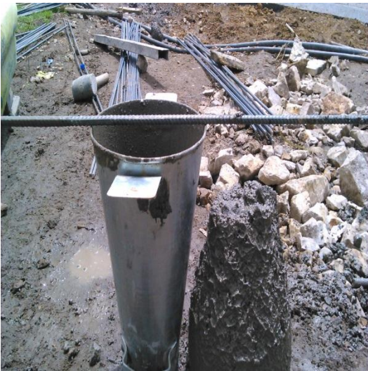
Sector Cumba: Se realiza prueba del cono.
