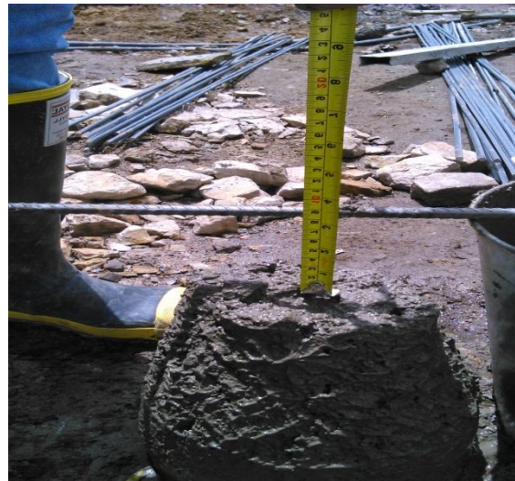
Sector Cumba k3+400-k3+680: Actividades Se realiza prueba del cono arrojando 8,5 cm, cumpliendo con el
