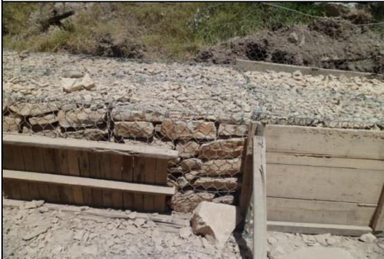
Armado de los muros de gavión con sus correspondientes medidas
