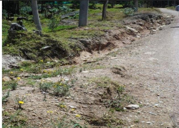
Se presenta socavación en la parte lateral debido al agua de escorrentía
