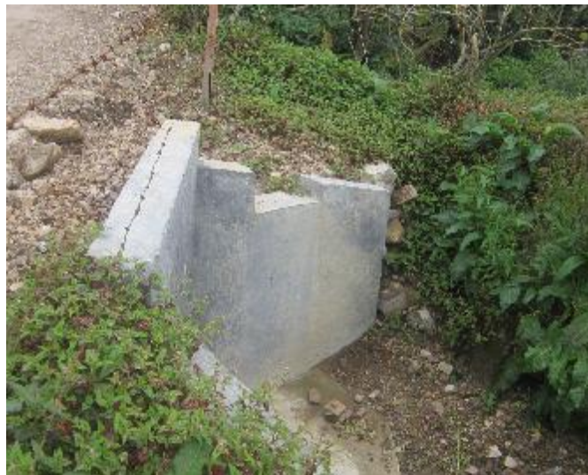
Figura 42. Alcantarillas terminadas en el sector Soledad de la vereda Santa Helena
