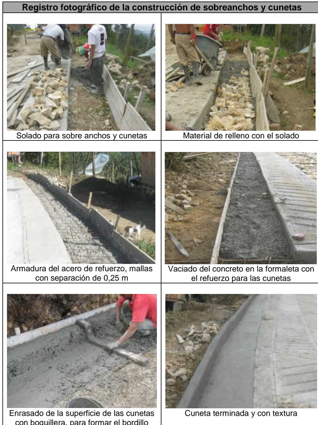
Figura 32. Construcción de los sobreebanos y cunetas
