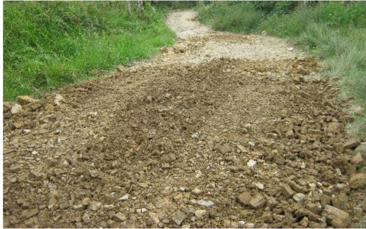
Figura 44. Distribución de material granular
