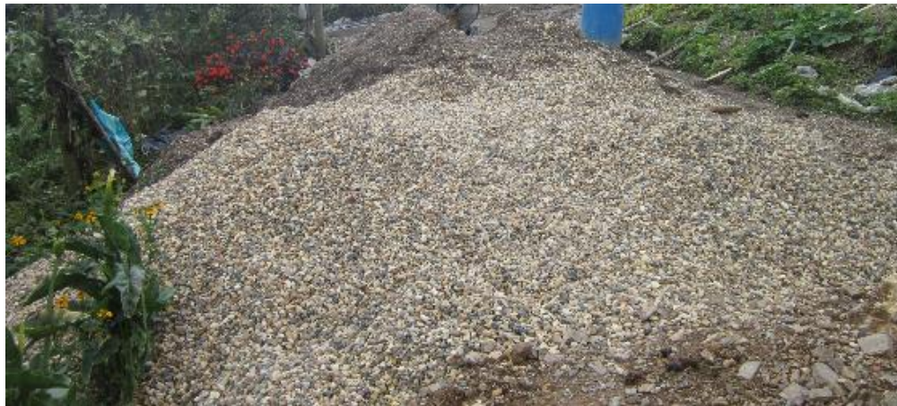
Figura 69. Agregados utilizados para la fabricación del concreto para la obra de mantenimiento y mejoramiento de la vía Santa Helena-sector Soledad
