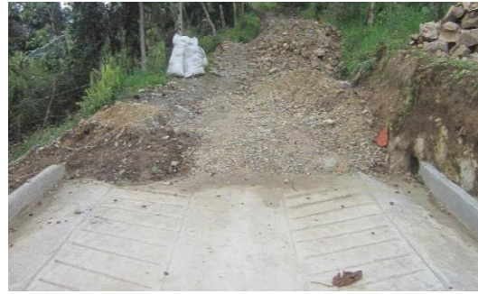
Placa huella del tramo 1, terminada en vía sin continuidad
