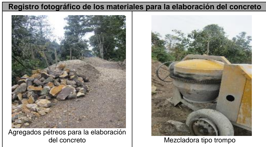
Figura 27. Materiales y equipo para la elaboración del concreto en obra
