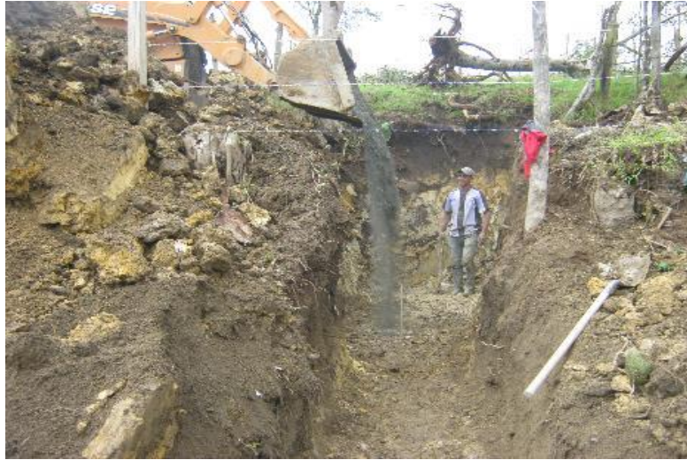
Figura 35. Solado para las alcantarillas
