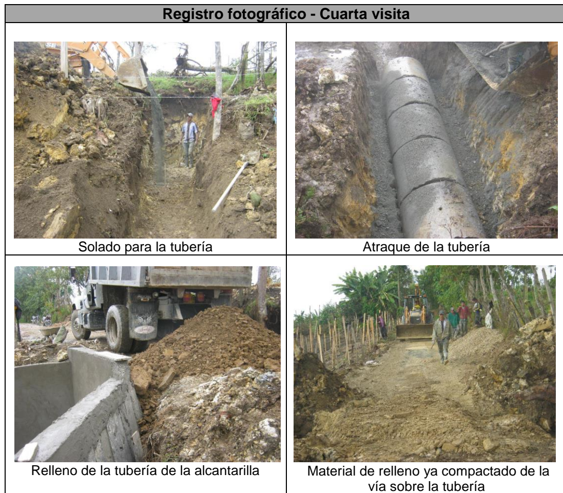
Figura 18. Fotografías de la cuarta visita, construcción de alcantarilla.
