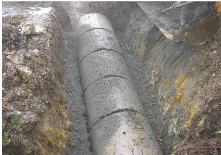
Figura 36. Izado de tubería y unión de tubos
