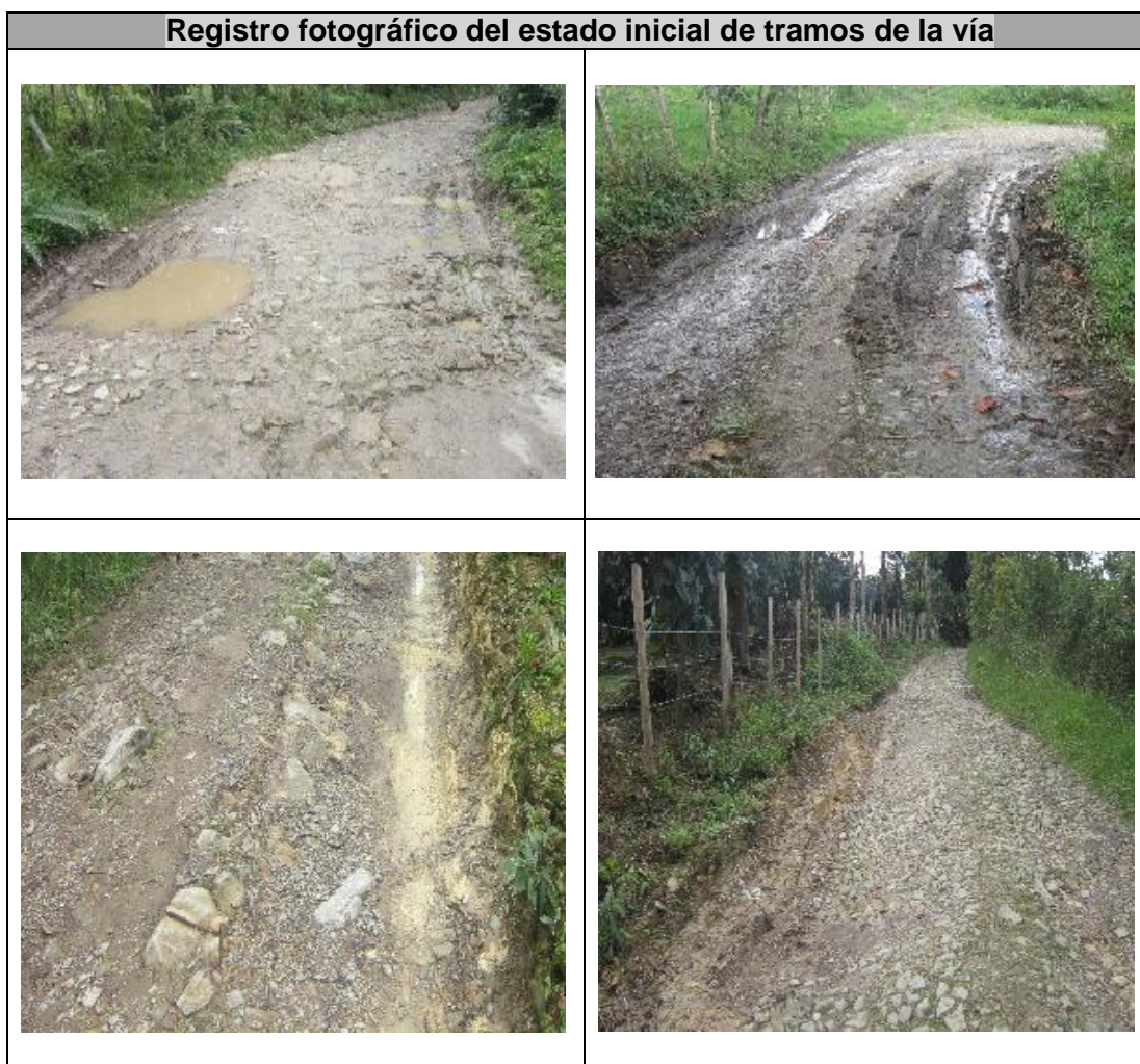
Figura 43. Condición inicial de la carretera
