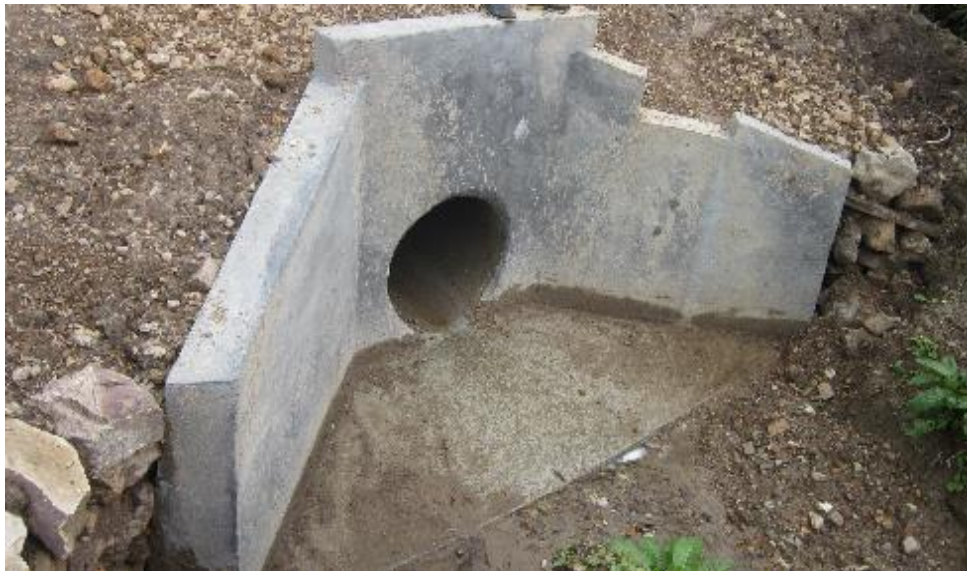
Figura 41. Estructura de salida de alcantarilla después de realizar su limpieza
