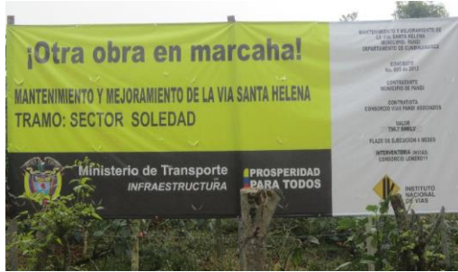
Valla informativa sobre la obra que está siendo ejecutada
