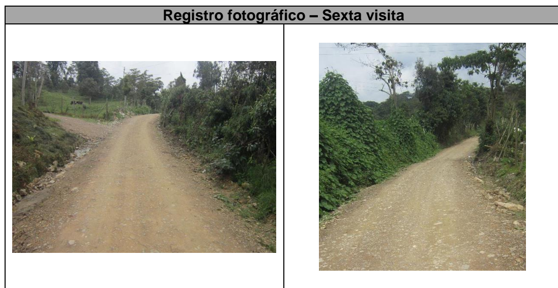
Figura 21. Fotografías de tramos de vía terminada con el afirmado en el sector Soledad, a la fecha de la sexta visita
