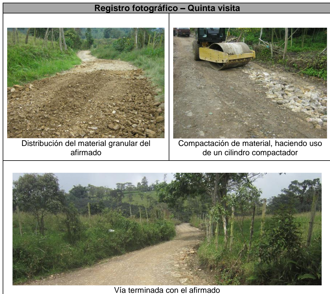
Figura 20. Fotografías de la quinta visita, proceso constructivo del afirmado
