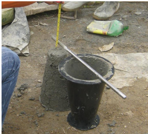
Figura 70. Asentamiento de la mezcla de concreto para la obra de mantenimiento y mejoramiento de la vía Santa Helena-sector Soledad
