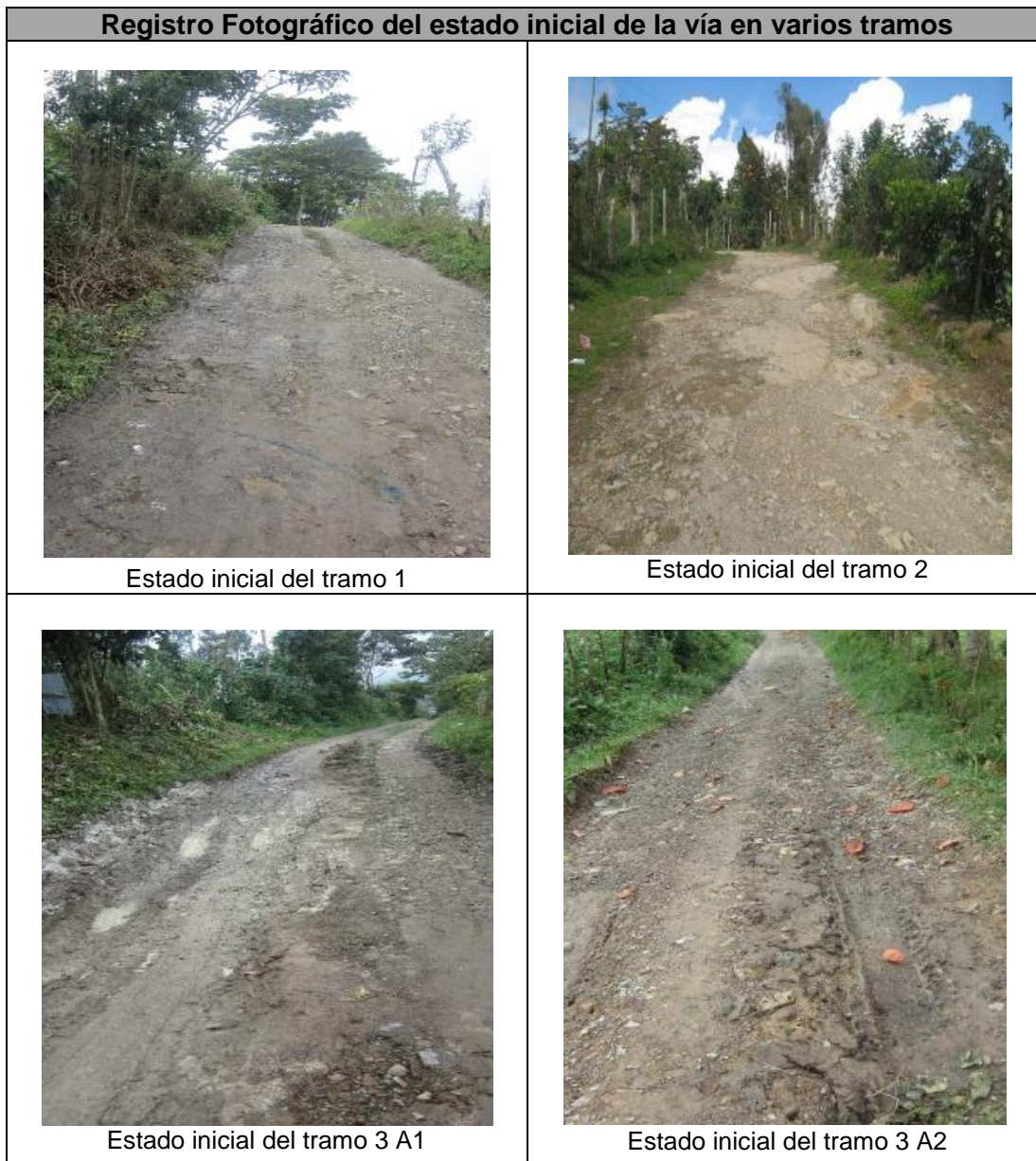
Figura 23. Estado inicial de la vía en varios tramos de ésta
