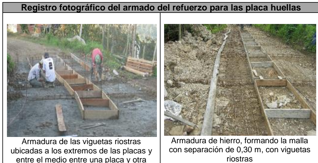
Figura 26. Armado del refuerzo de las placas huellas
