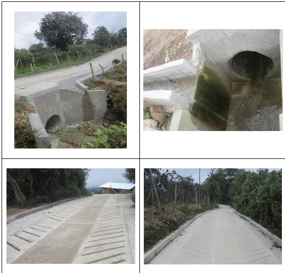
Figura 22. Fotografías de obras terminadas en la vereda Santa Helena, séptima visita
