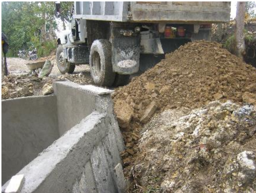
Figura 39. Relleno de zanjas
