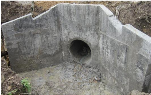
Alcantarilla 1 terminada, sin acabados
