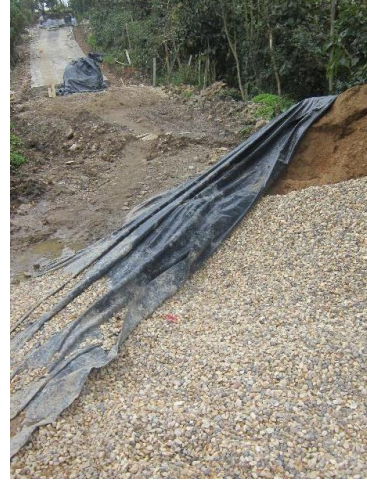
Disposición de materiales granulares al borde de la vía
