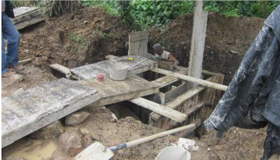
Figura 40. Encofrado de poceta
