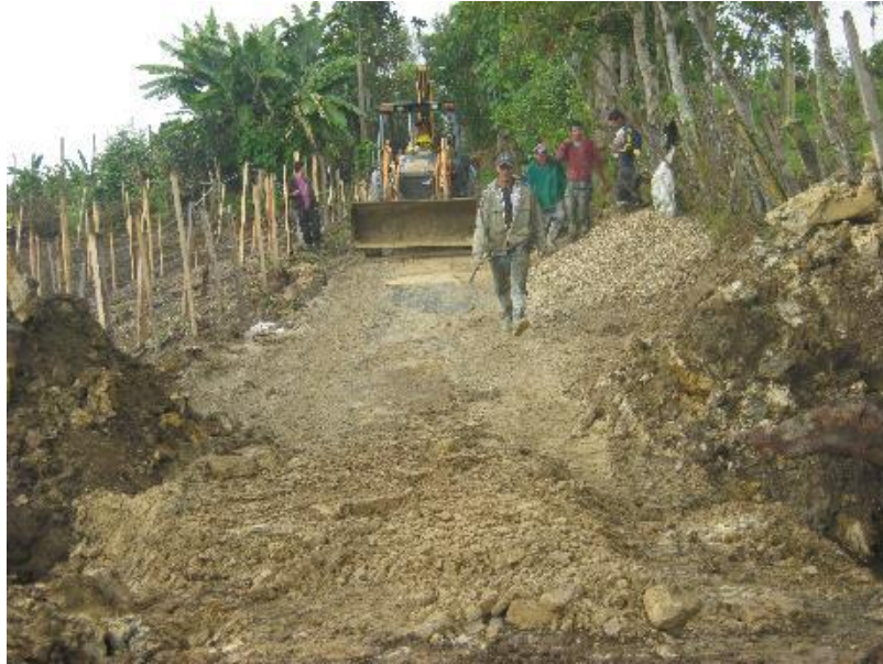
Figura 34. Movimiento de tierra para instalación de tubería
