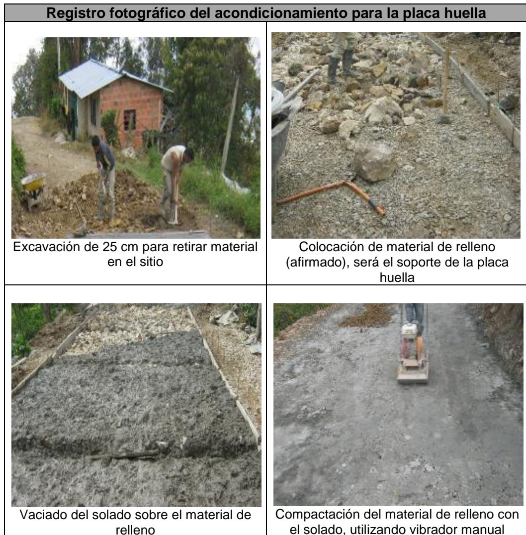
Figura 24. Procedimiento de acondicionamiento para la placa huella.
