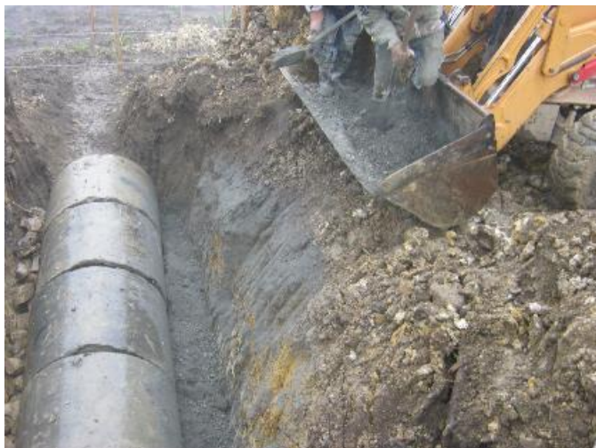
Figura 37. Bases y atraque para tubería
