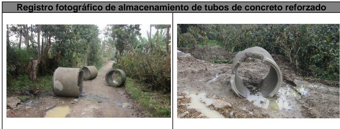
Figura 87. Almacenamiento de tubos de concreto reforzado en el sector Soledad
