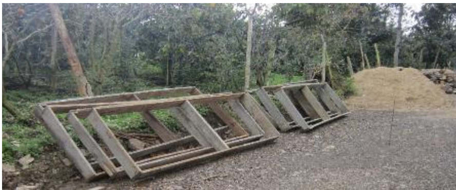
Formaletas en madera, dispuestas al borde de vía en el lugar de la construcción de las placa huellas
