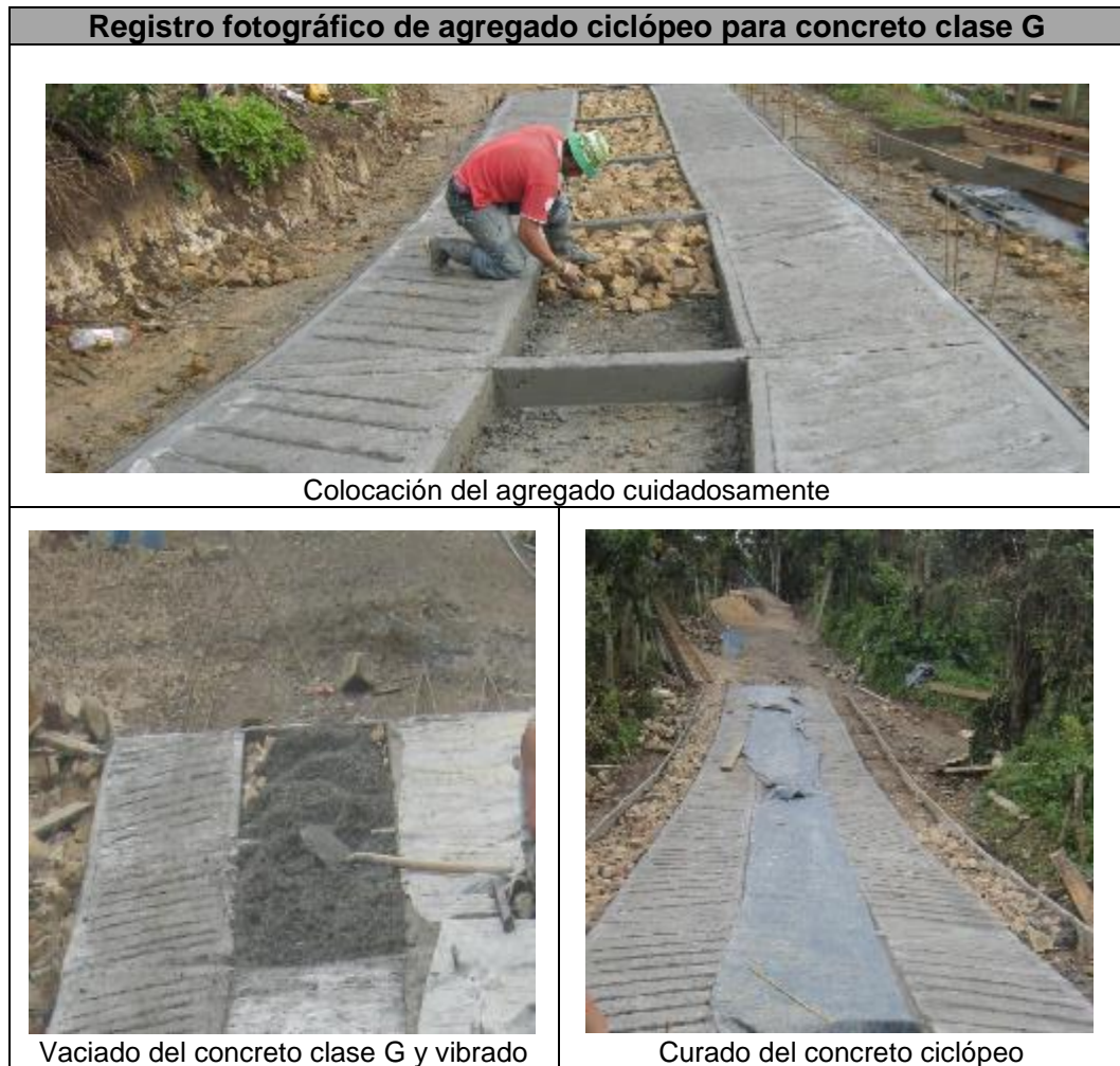
Figura 33. Colocación del agregado ciclópeo
