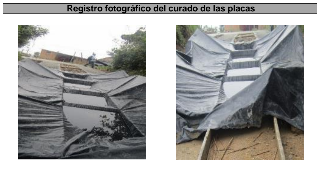
Figura 31. Curado de las placa huellas por medio de humedecimiento y protección con plásticos para retener la humedad
