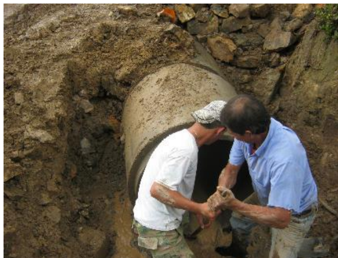
Figura 38. Limpieza de tuberías
