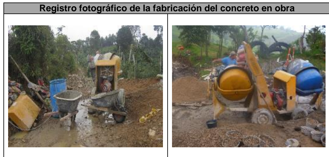
Figura 28. Fabricación de concreto en obra
