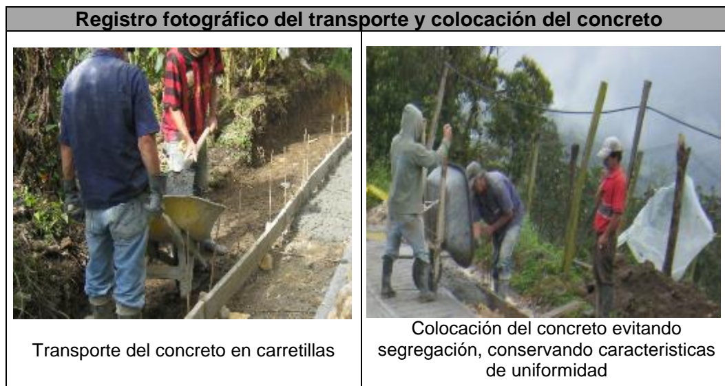
Figura 29. Transporte y colocación del concreto en las placas huella
