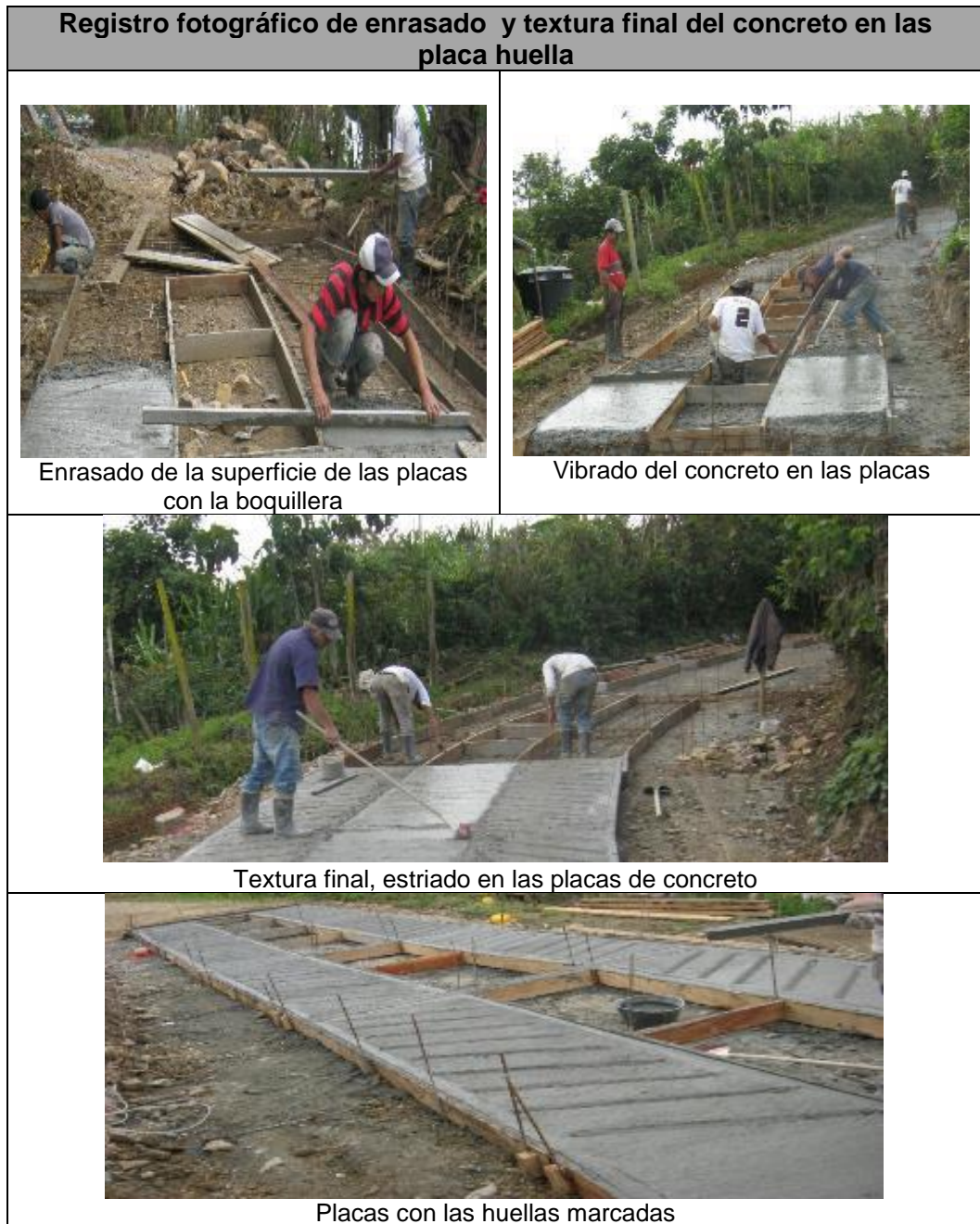
Figura 30. Enrasado de la superficie de las placas y textura final del concreto
