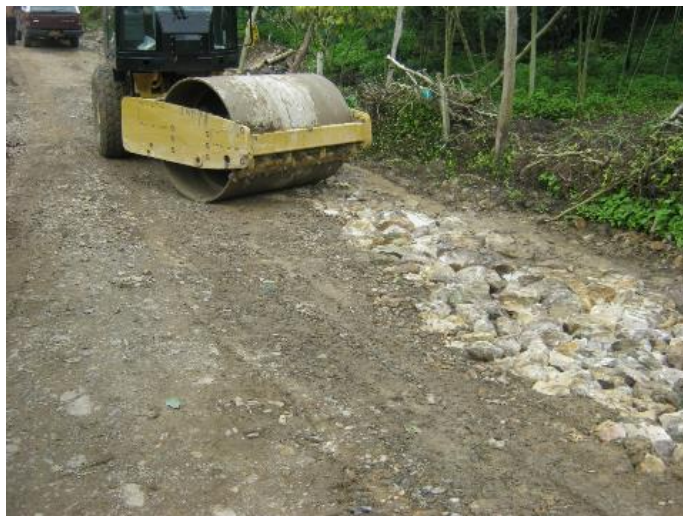
Figura 45. Compactación del material granular
