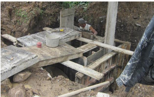
Proceso constructivo de alcantarilla 2, (formaletas del encole)
