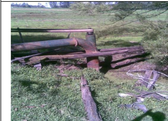
FOTO 173. Bomba que pasa las aguas residuales de las fincas al canal que llega al Río Bogotá - Zipaquirá
