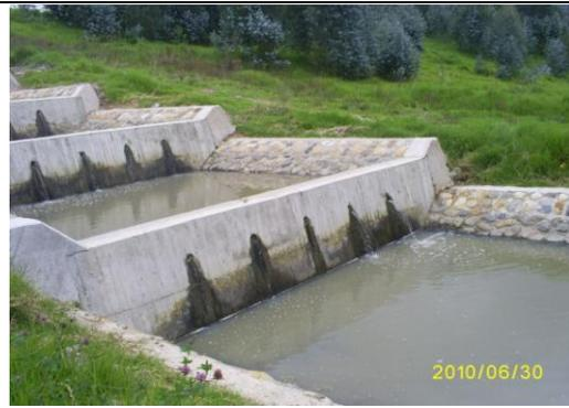
FOTO 84. Estructura de descarga al río Bogotá – Campus UMNG Cajicá
