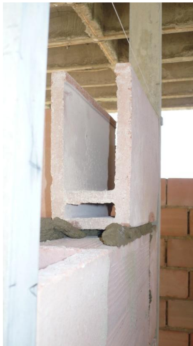
Figura 4.6. Bloque para viguetas, ladrillera Santafé.
