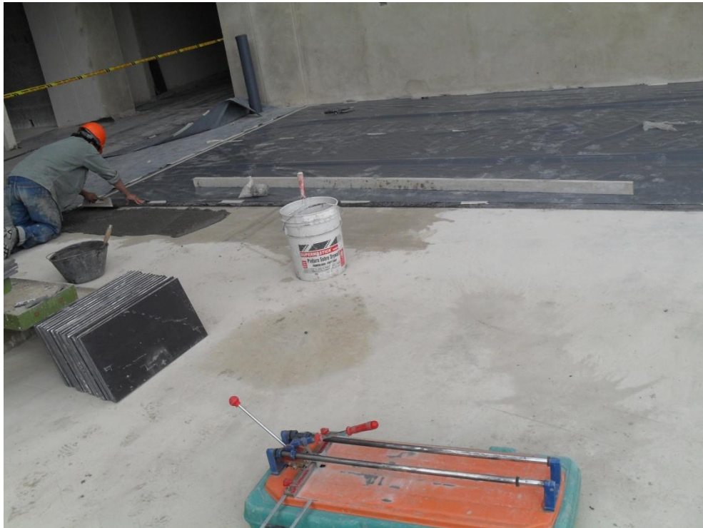
Figura 4.8. Pegacor en el piso.
