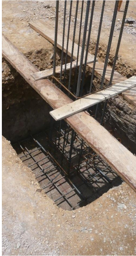
Figura 4.11. Colocación del refuerzo.
