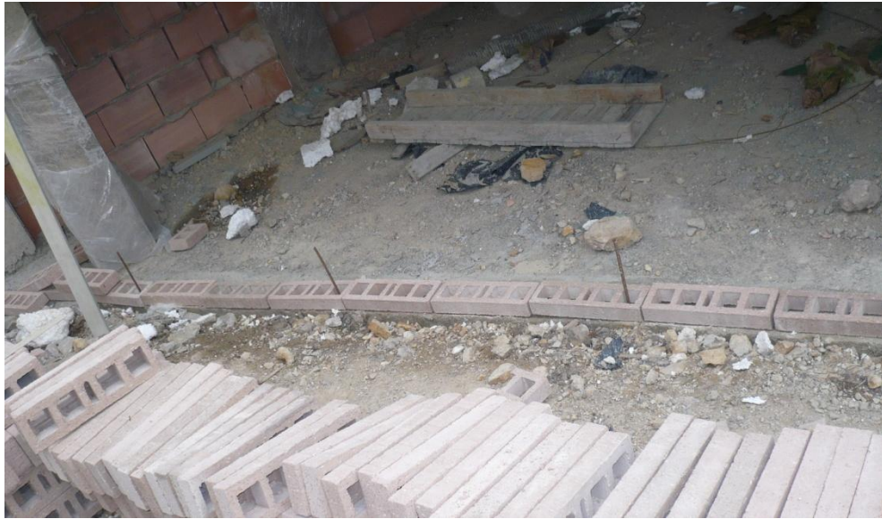
Figura 4.3. Marcación de ejes y predisposición de primeros bloques o ladrillos.
