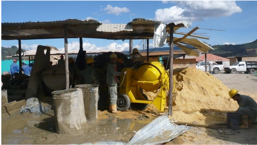
Figura 4.1. Centro de acopio de material y mezcla
