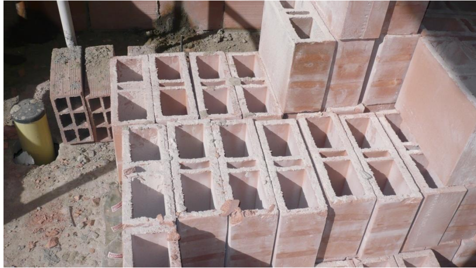
Figura 4.5. Bloque estructural con perforaciones verticales, ladrillera Santafé.
