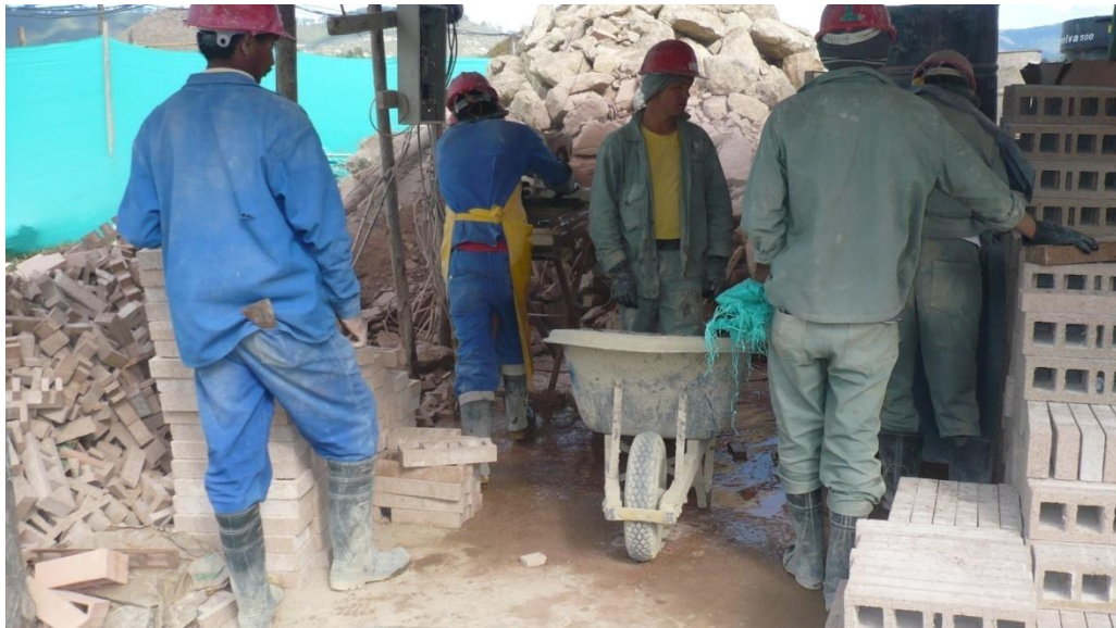
Figura 4.2. Centro de acopio y de corte de bloques y ladrillos.
