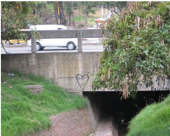
Fotografía 2. Río Arzobispo, puente sobre carrera 7ª.
