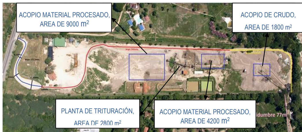
Figura 3 Área de trituración y los patios de acopio de material.
