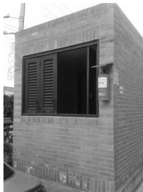
Figura 5 Vista Externa del lugar de almacenamiento de residuos sólidos Fuente: Autora
