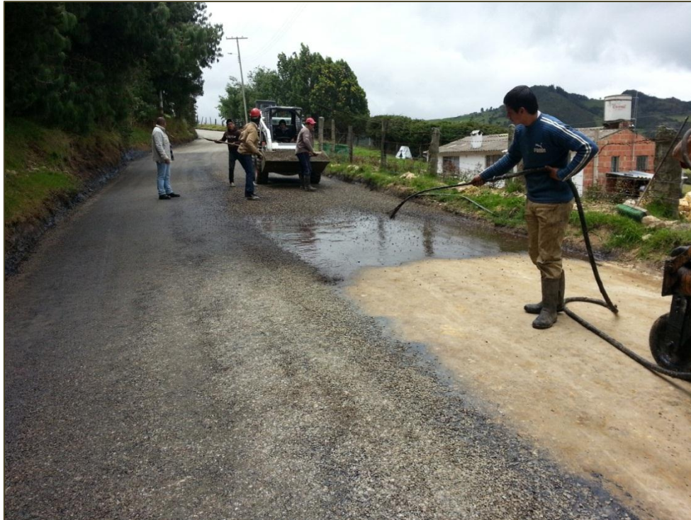
Figura. 12 Aplicación Primera capa del polímero PB-65 con el agregado de tamaño 3/8". K0+054 al K0+300.
