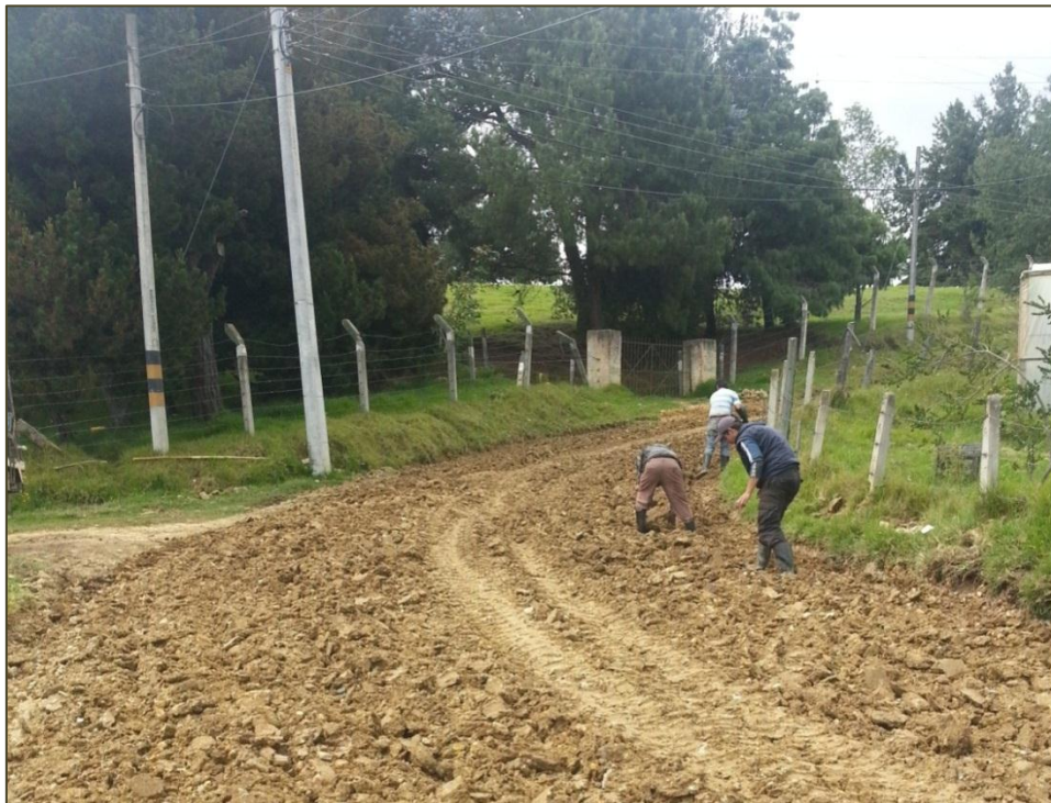
Figura. 5 Extracción manual de sobre tamaños. K0+054 al K0+300.
