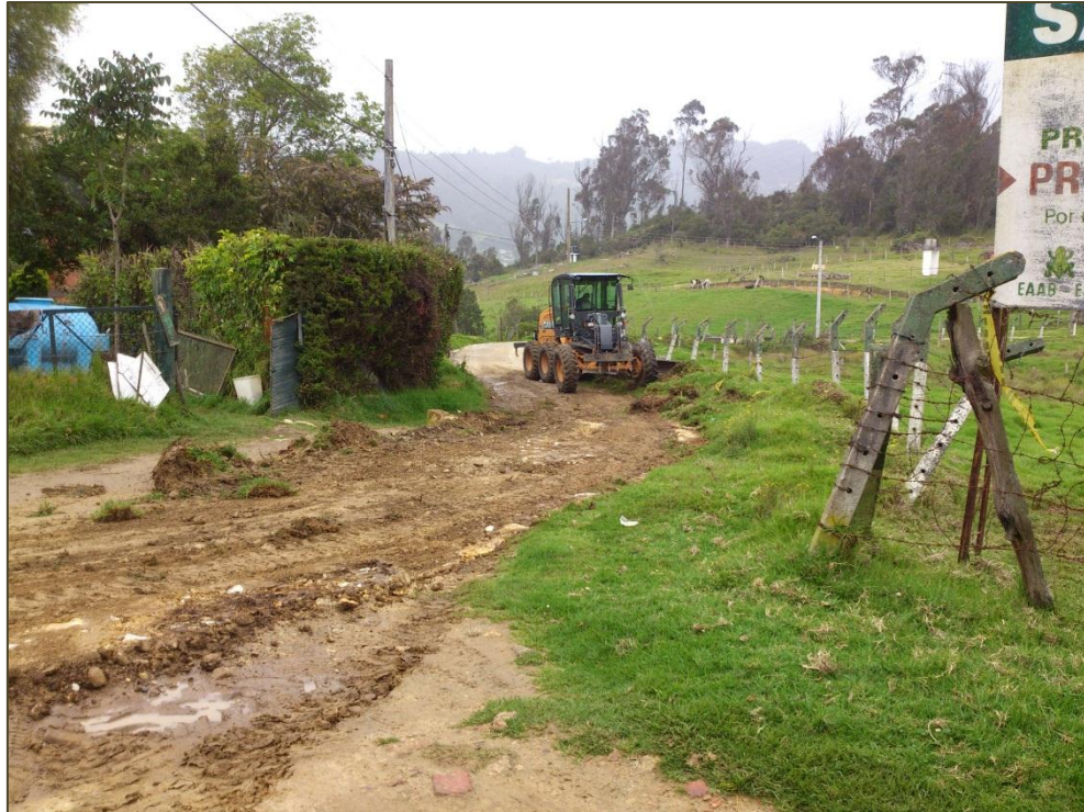
Figura. 3 Limpieza y perfilado de la Vía. K0+054 al K0+300.
