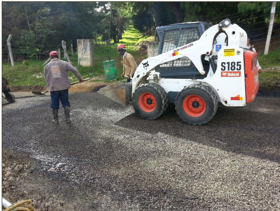
Figura. 14 Aplicación Segunda capa del polímero PB-65 con el agregado de tamaño 3/8". K0+054 al K0+300.
