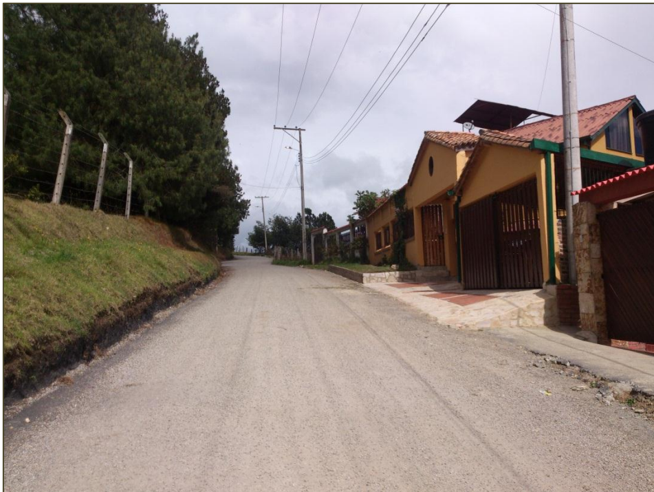
Figura. 18 Vía terminada con el sistema Probase Road System, longitud aprox. 246.0m, ancho aprox. 5.0m. K0+054 al K0+300.
