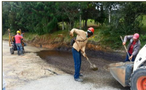
Riego de Agregado.
