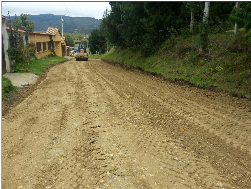
Figura. 8 Compactación del suelo. K0+054 al K0+300.
