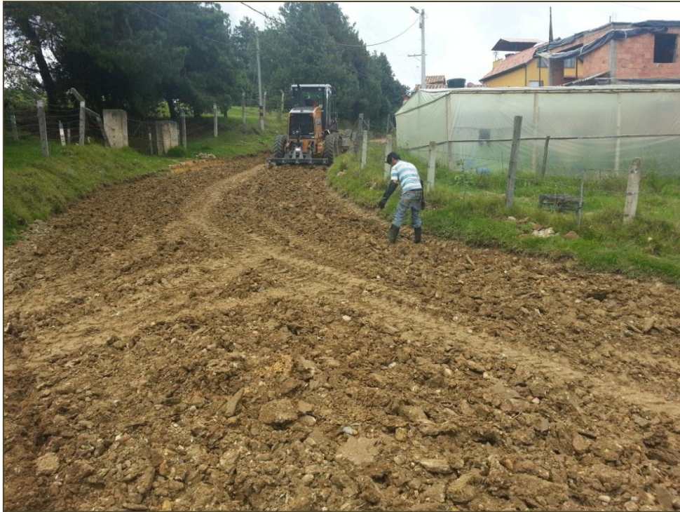
Figura. 4 Escarificado de la vía. K0+054 al K0+300.
