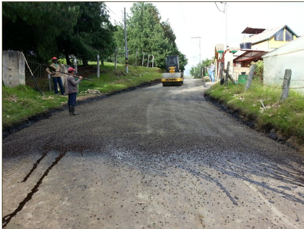
Figura. 13 Compactación Primera capa del polímero PB-65 con el agregado de tamaño 3/8". K0+054 al K0+300.
