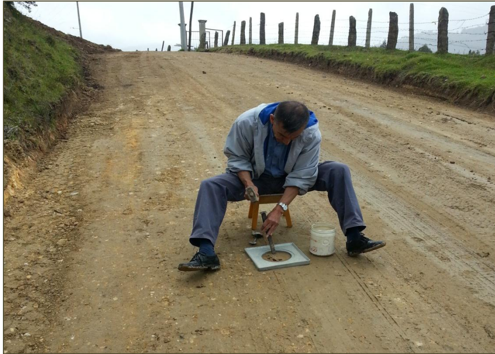
Figura. 10 Toma de densidades suelo estabilizado k0+128 / 99.6%.
