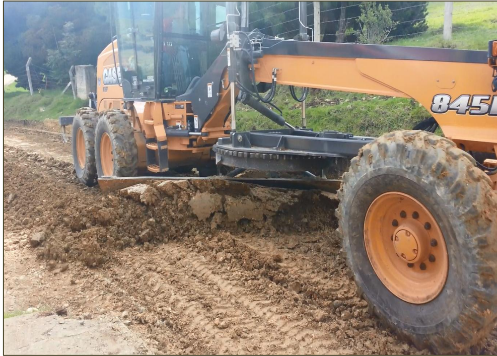
Figura. 7 Mezcla polímero TX-85 con el suelo. K0+054 al K0+300.
