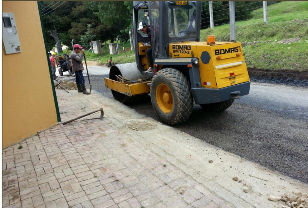
Figura. 15 Compactación Segunda capa del polímero PB-65 con el agregado de tamaño 3/8". K0+054 al K0+300.
