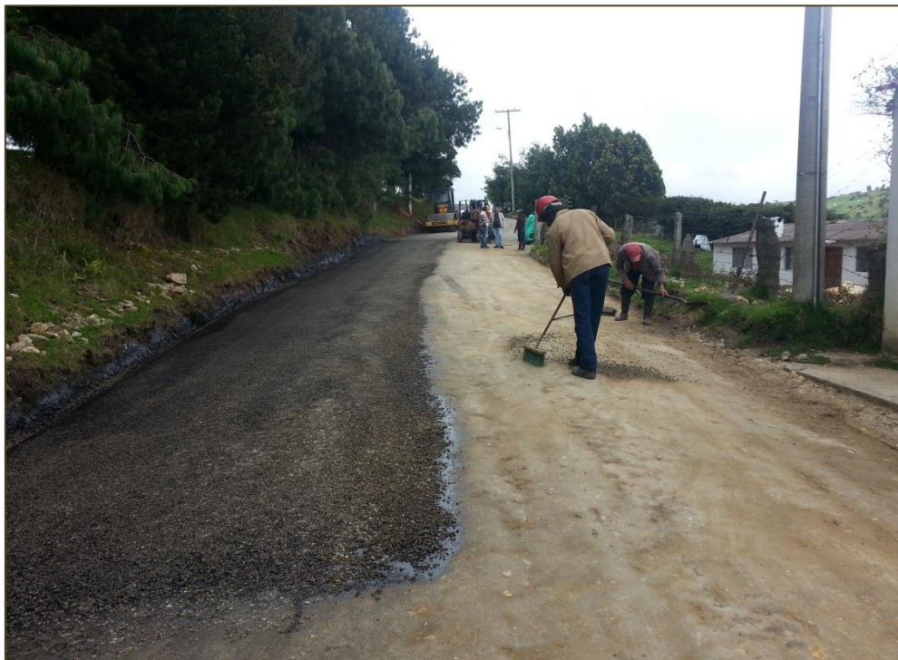
Figura. 11 Aplicación Primera capa del polímero PB-65 con el agregado de tamaño 3/8". K0+054 al K0+300.
