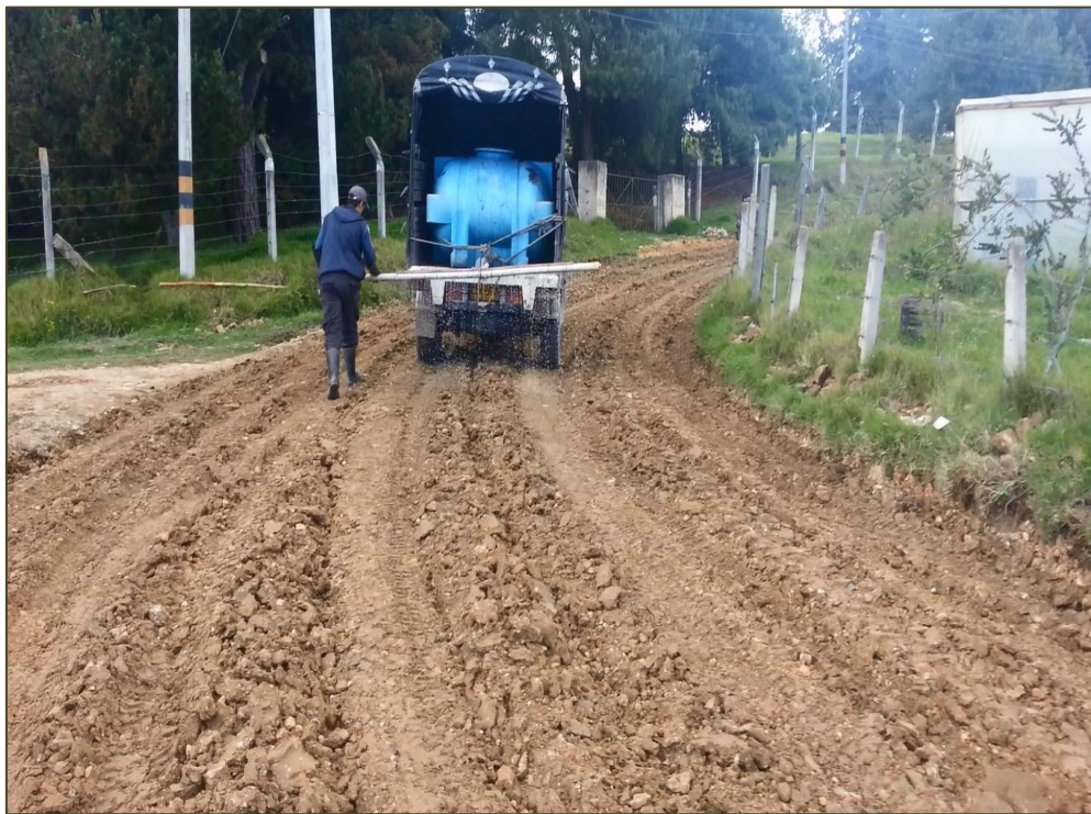
Figura. 6 Aplicación del polímero TX-85. K0+054 al K0+300.
