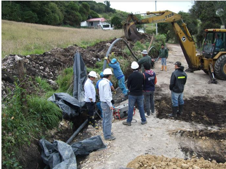
Figura 11 Instalación de la nueva tubería de acueducto en 3''
