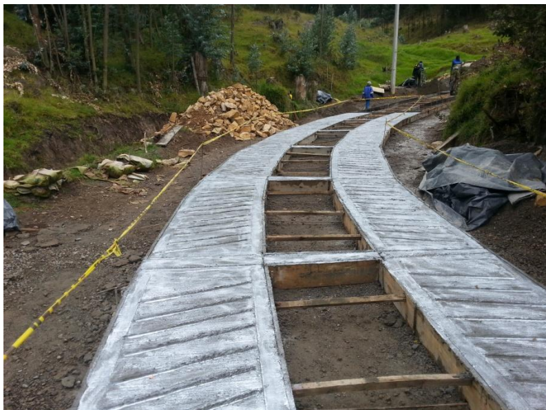
Figura 14 Aplicación anti-sol para curado de concreto
