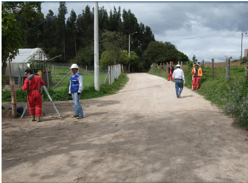
Figura 6 Trabajos de topografía en la vía
