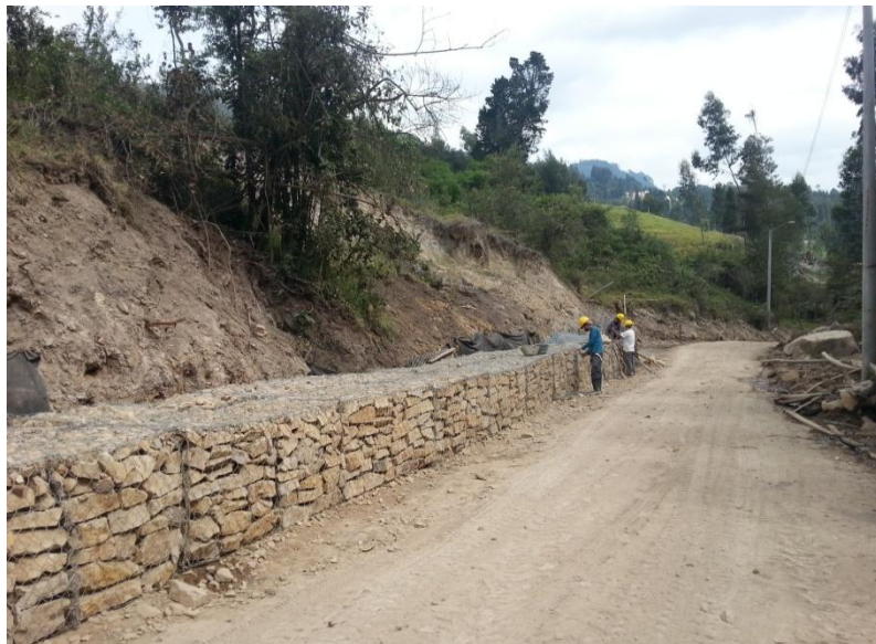
Figura 20 Construcción de gaviones como medida de mitigación en zonas de taludes inestables
