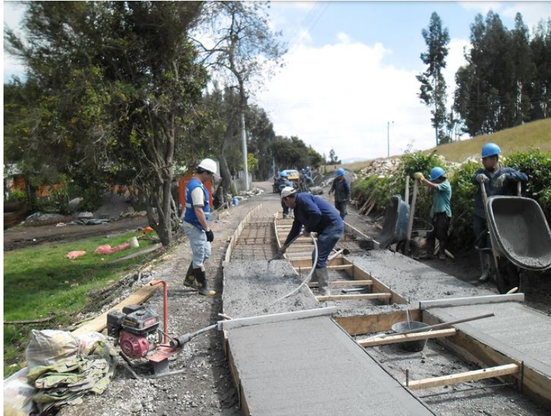
Figura 13 fundida la huella en concreto reforzado
