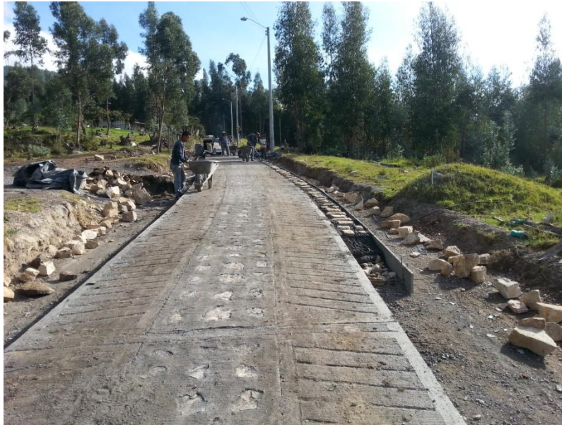
Figura 17 Fundida de sobre-anchos para completar la sección vial
