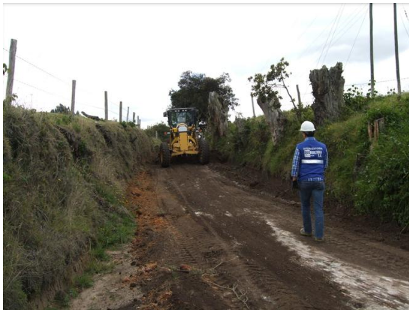
Figura 10 Limpieza y conformación de la vía con material de afirmado
