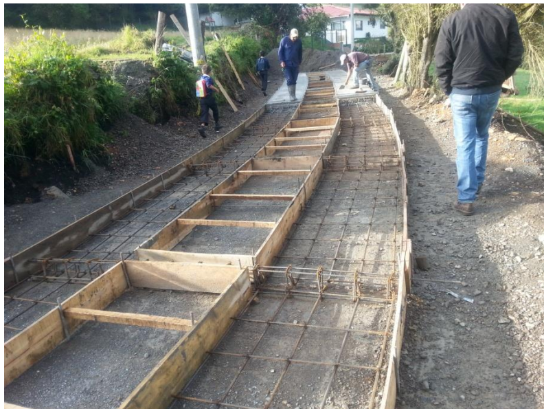
Figura 12 armado de la formaleta en madera y del reforzamiento con hierro corrugado
