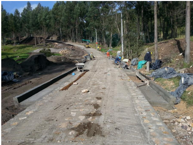
Figura 18 Fundida de las cunetas laterales – método I
