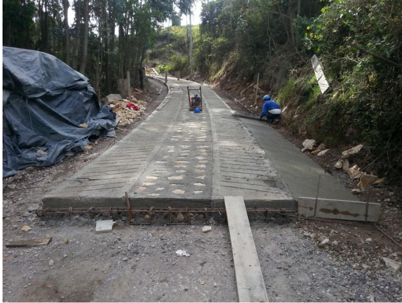
Figura 19 Fundida de las cunetas laterales – método II
