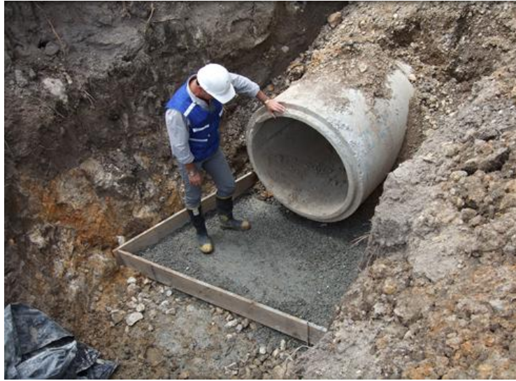
Figura 7 Tubería en concreto reforzado para cruces para manejo de aguas lluvias
