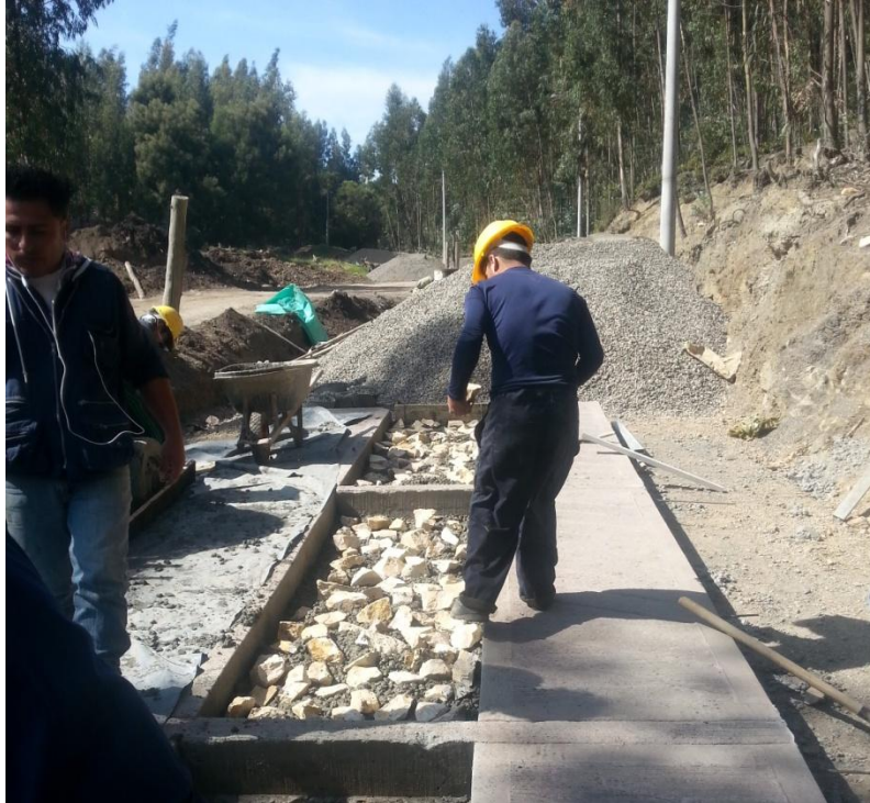
Figura 15 Fundida de placa de concreto ciclópeo
