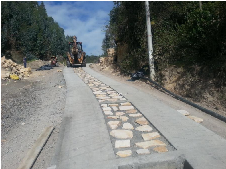
Figura 16 Fundida de placa de concreto ciclópeo
