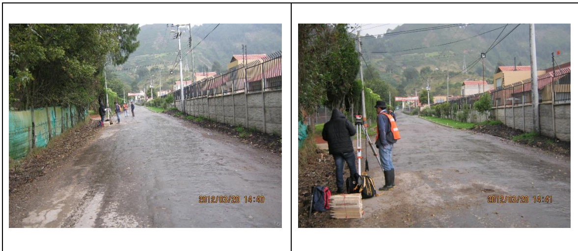
Imagen: 2. Localización y replanteo. Se realiza y/o verifica el levantamiento topográfico de cada uno de los frentes de obra con localización de redes y pozos encontrados.
