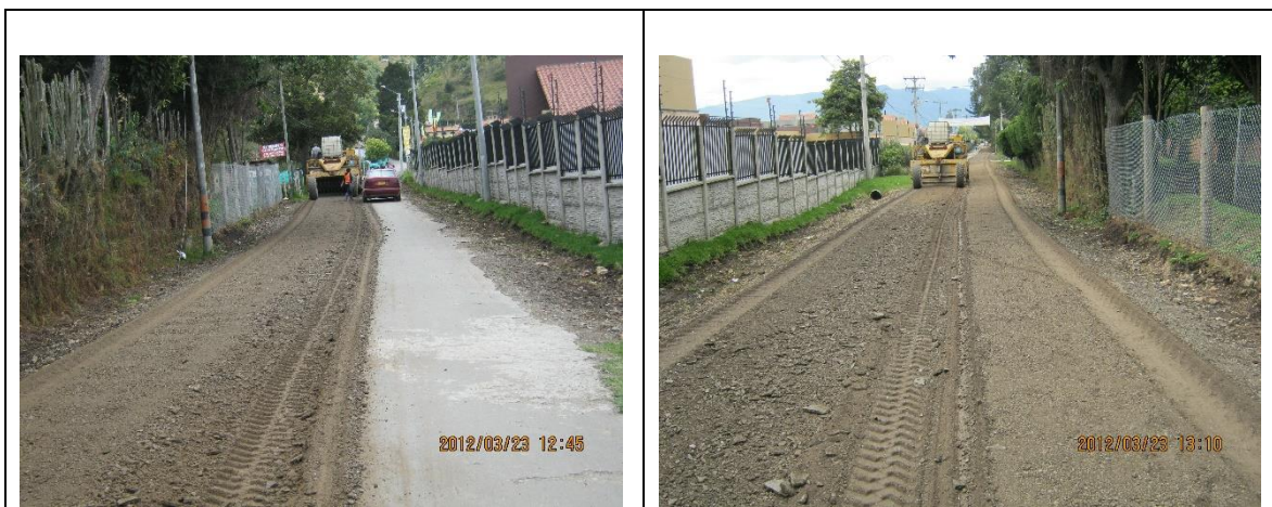
Imagen: 5. En algunos frentes se hace necesario la realización de rocería de algunos sectores, para poder ampliar la sección de la vía. Se realiza la escarificación, y/o reciclado de asfalto de las vías según corresponda, de acuerdo al recorrido de los tramos a intervenir. Fuente: consorcio intervias 2012, Contrato No 388 2011.
