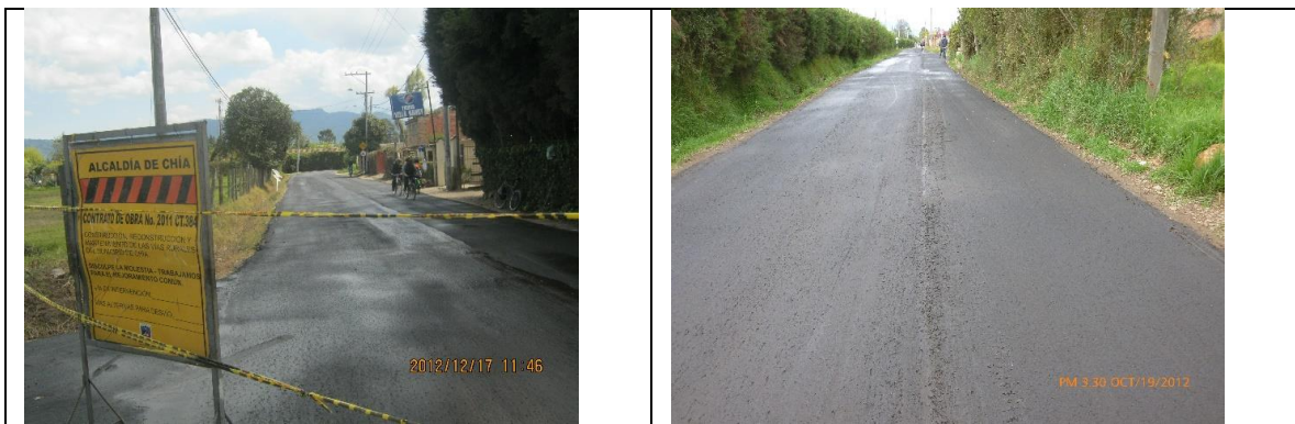
Imagen: 11. Proceso de extendido e instalación del micropavimento, (slurry seal).
