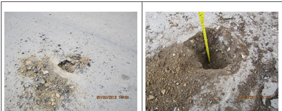
Imagen: 3. Apiques para reconocimiento de estructura de la vía. Además se realiza una revisión de la documentación técnica existente, planos de redes, topografía, diseños de estructuras suministrados.
