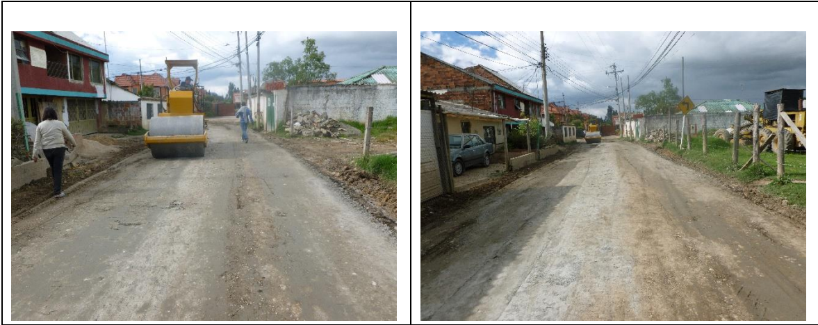
Imagen: 8. Se realiza la compactación de la capa granular estabilizada Fuente: consorcio intervias 2012, Contrato No 388 2011.
