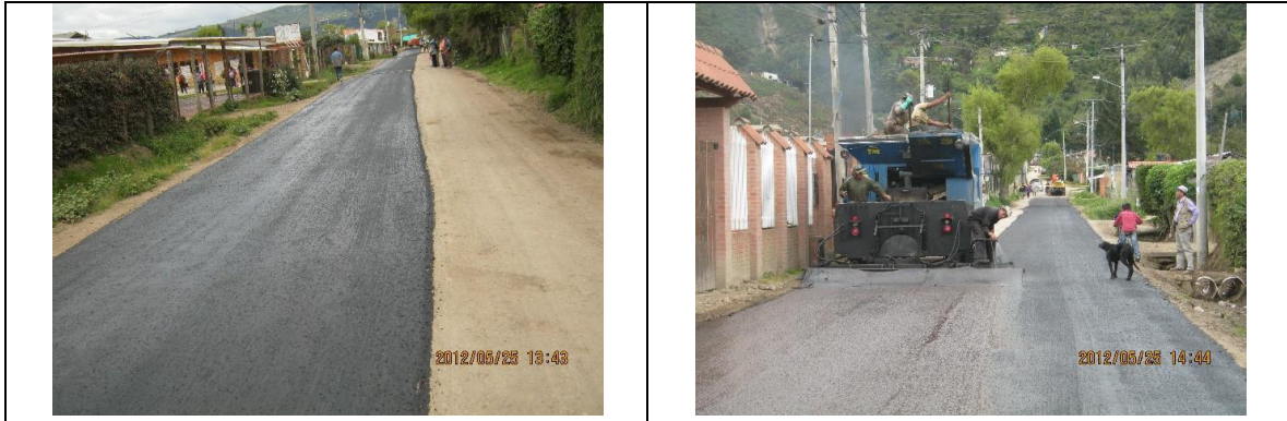
Imagen: 10. En ocasiones de acuerdo a las condiciones de la vía, y la intervención realizada es necesario aplicar dos capas del micropavimento para garantizar la estabilidad de la vía.
