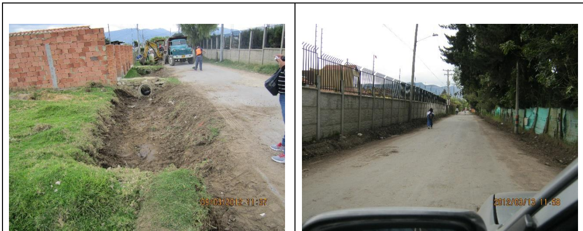
Imagen: 4. Se realiza la limpieza de los vallados, y la conformación de cunetas donde sea necesario, esto con el fin de poder ampliar la sección de la vía. Fuente: consorcio intervias 2012, Contrato No 388 2011.
