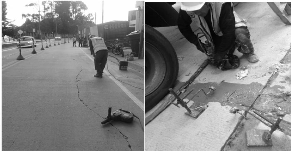
*Figura 8.a) Proceso de perforación b) Inyección de polímero. Fuente: Alari Clean Technologies [10]*
