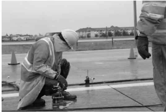
*Figura 3. Deformímetro para controlar la altura de nivelación. Fuente: Liang Yu. [6]*
