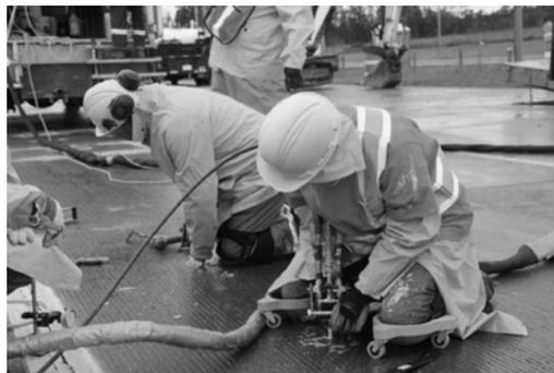
*Figura 2. Método de inyección múltiple para distribuir la fuerza de levante. Fuente: Liang Yu. [6]*
