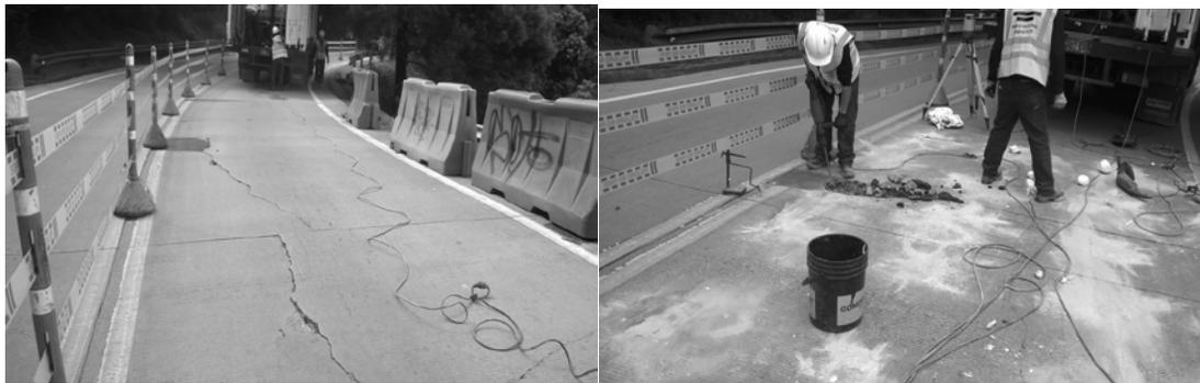
*Figura 9. a) Reparación de fisuras. b) Cajeo. Fuente: Alari Clean Technologies [10]*
