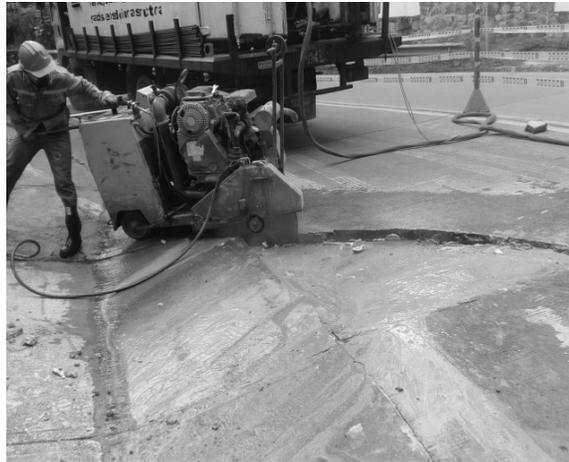
Figura 6. Corte de barras de transferencia existentes. Fuente propia
