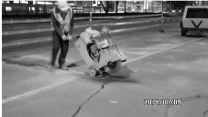
Figura 11. Rotura de barras de transferencia. Fuente: Alari Clean Technologies [10]
