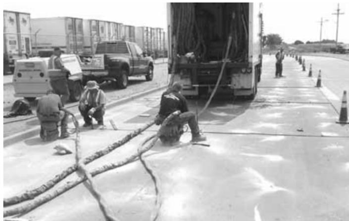
*Figura 1. Trabajo de rehabilitación de pavimento de concreto en Fort Morgan Colorado en el 2007. Fuente: International Grooving & Grinding Association [8].*
