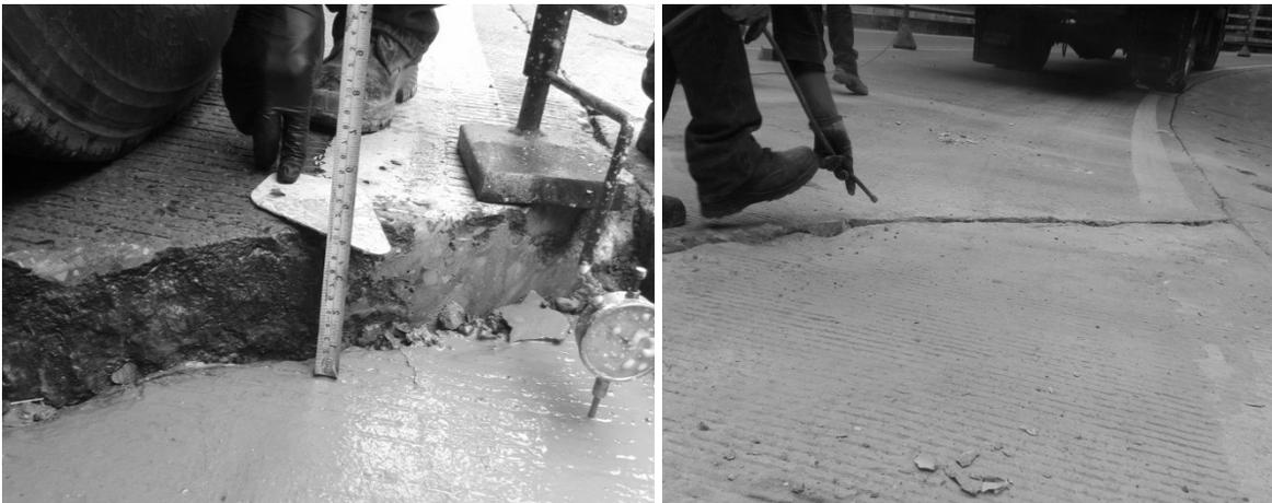
Figura 7. a) Registro antes de la inyección en el primer sector ejecutado. b) Registro después de la inyección. Fuente: Alari Clean Technologies [10]
