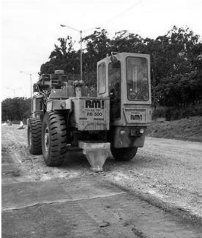
Figura 3. Equipo rompedor resonante. Fuente: Hidrodem.
