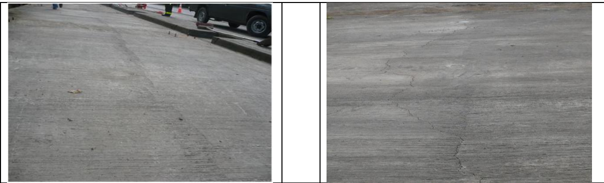
Figuras No. 26 y 27 Fallas presentadas en vigas soporte de plataformas
