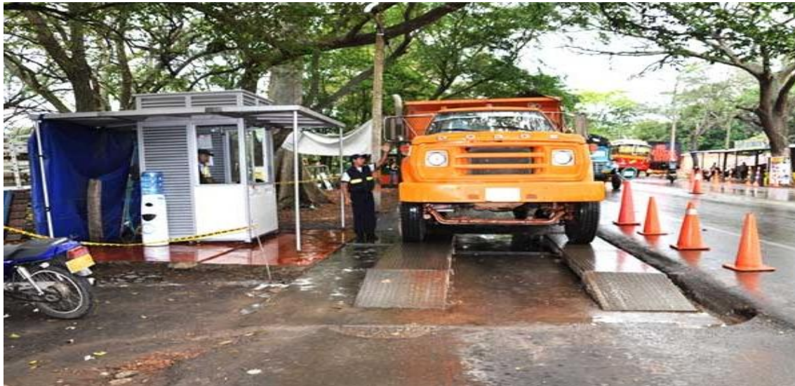
Figura No. 11 Estación de pesaje Estático
