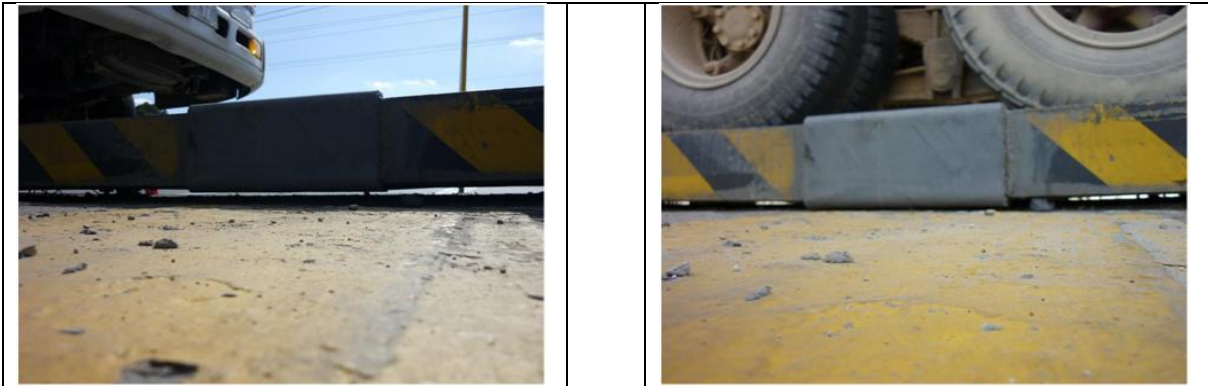
Figuras No 16 y 17. Refuerzo en viga y sello de fisuras
