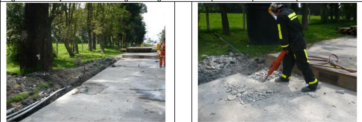
Figura No. 30 Demolición apoyos de las vigas de la báscula
