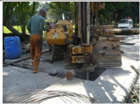
Figura No.39 Perforación para pilotes
