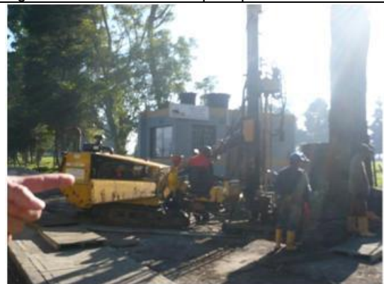
Figura No. 41 Perforación para pilotes
