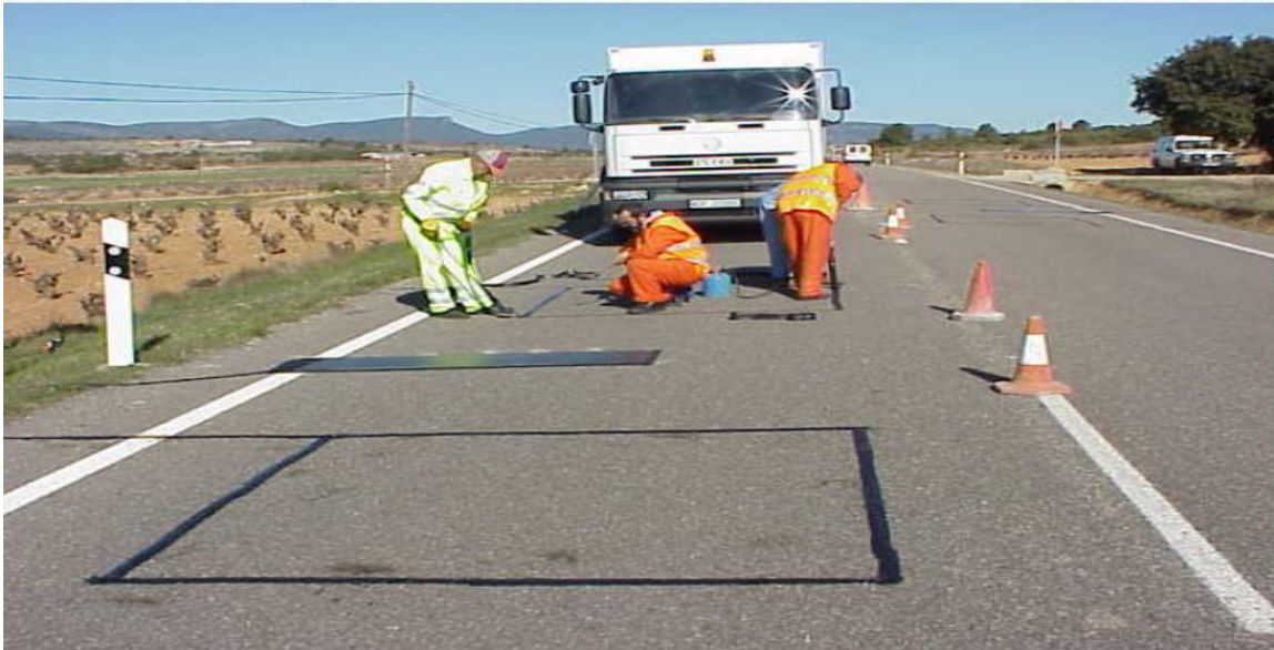
Figura No. 9 Instalación Estación de Pesaje Dinámico dentro del pavimento
