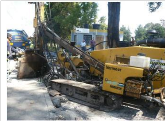
Figura No. 38 Perforación para pilotes
