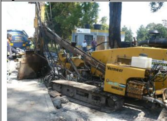
Figura No. 40 Perforación para pilotes
