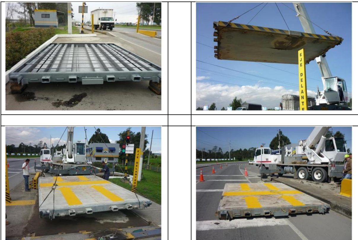
Figuras No 18, 19, 20 y 21 Fundición placa de concreto y posterior montaje
