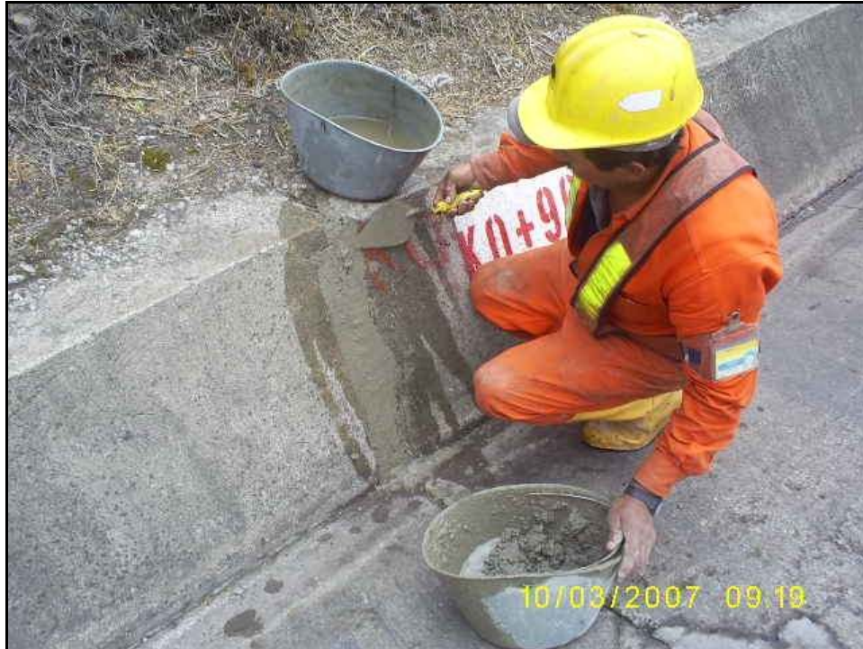
Figura 22. Mantenimiento según auscultación cunetas longitudinales. (Fuente archivo personal de los autores).
