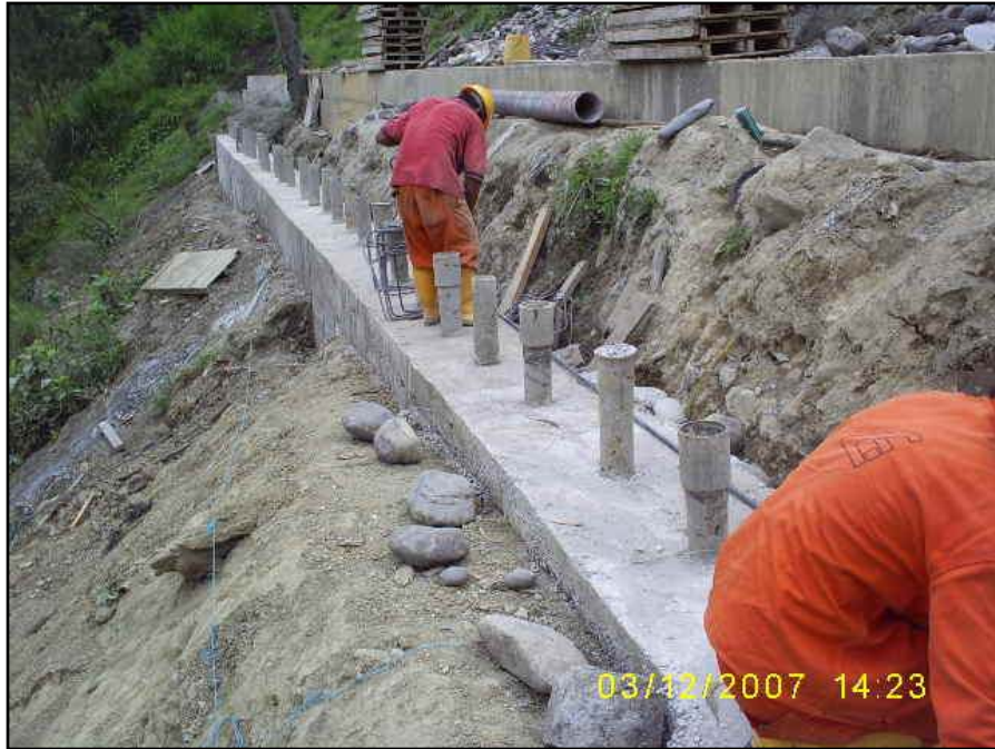
Figura 35. Obras complementarias, estabilización de laderas con la construcción de muros de contención. Nótese que el muro esta cimentado con pilotes de concreto. (Fuente archivo personal de los autores).
