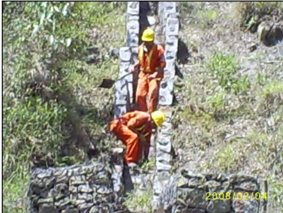
Figura 20. Mantenimiento según auscultación de canales, bajantes y zanjas de coronación. Los operarios están reparando fisuras para prevenir filtraciones. (Fuente archivo personal de los autores).
