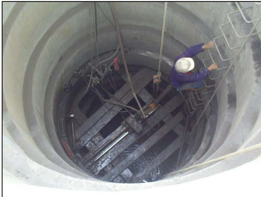
Figura 38. Obras complementarias, construcción de pozos de abatimiento para manejo de aguas sub-superficiales. Nótese en el fondo la máquina perforadora construyendo los drenes horizontales. (Fuente archivo personal de los autores).
