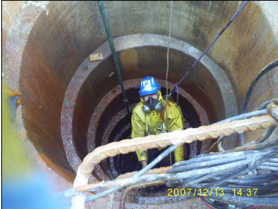
Figura 10. Mantenimiento rutinario. Mantenimiento pozos de abatimiento. Nótese las medidas de seguridad del operador. (Fuente archivo personal de los autores).
