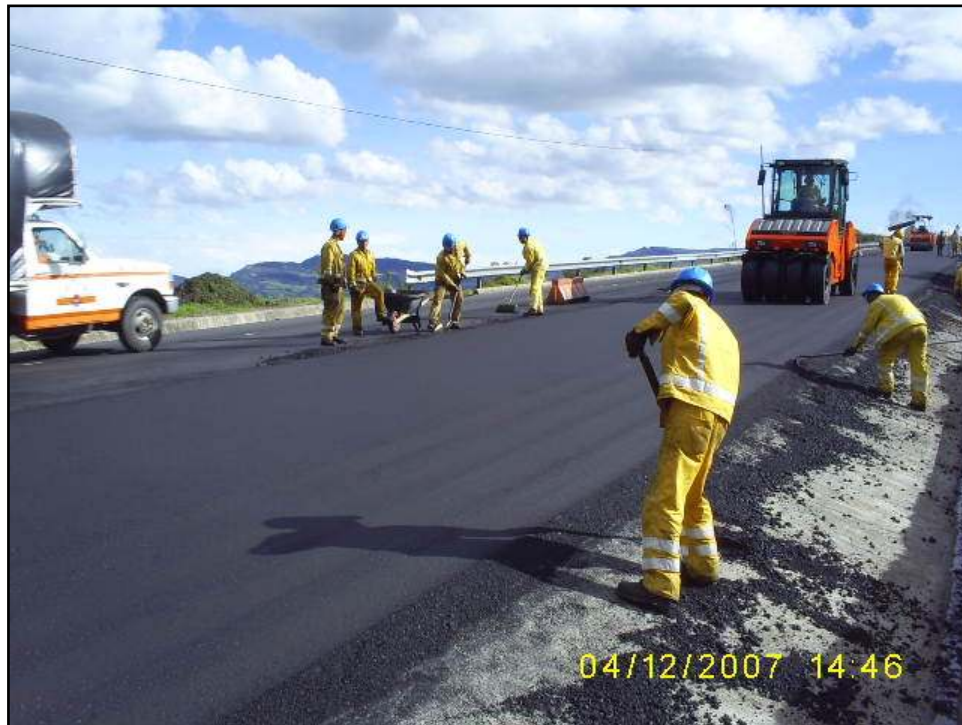
Figura 34. Obras complementarias, refuerzo de la carpeta asfáltica. Dependiendo de la generación de las concesiones estas obras puede ser rutinarias o complementarias. (Fuente archivo personal de los autores).
