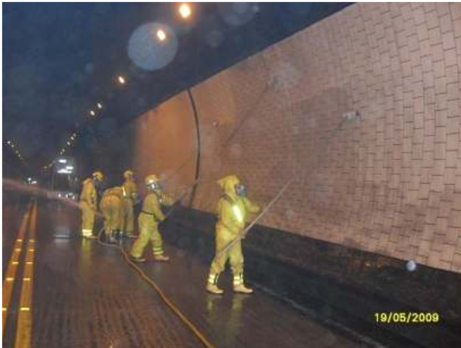
Figura 5. Mantenimiento rutinario. Lavado bóveda de un túnel (Fuente archivo personal de los autores).
