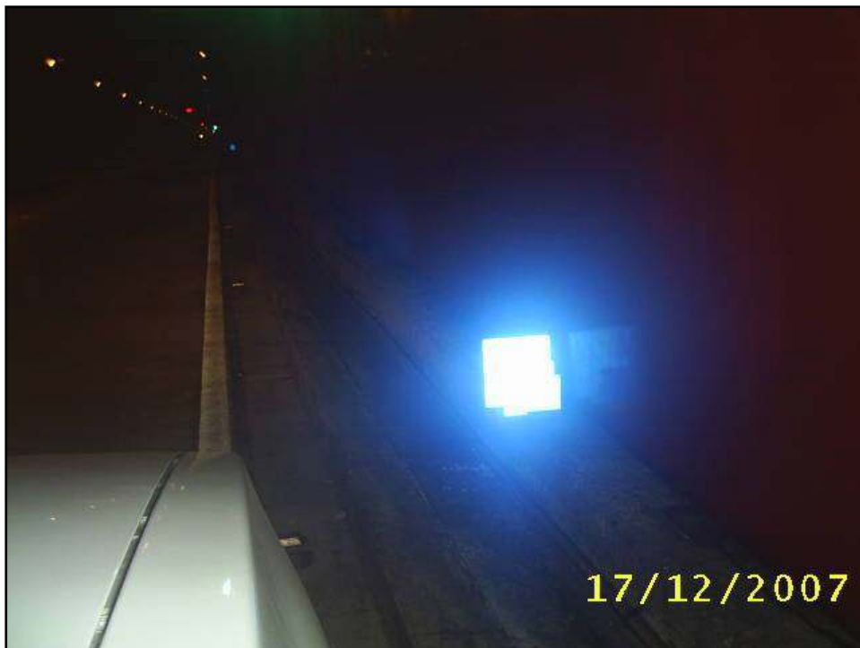
Figura 2. Mantenimiento rutinario. Señales informativas de distancia entre vehículos después de haber sido lavadas. Nótese la alta retroreflectividad del elemento (Fuente archivo personal de los autores).
