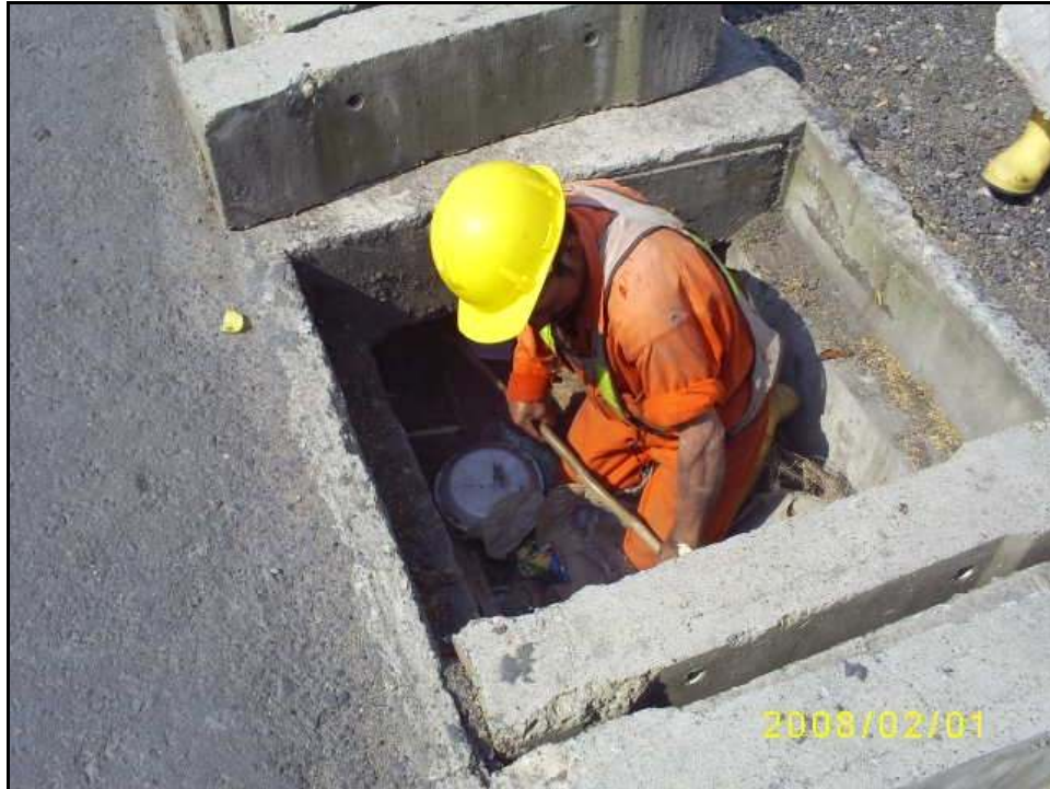
Figura 27. Mantenimiento según auscultación alcantarillas y box. (Fuente archivo personal de los autores).
