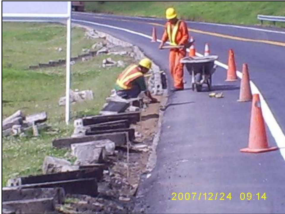
Figura 21. Mantenimiento según auscultación de bordillos, en este caso se esta haciendo realce, alineación y emboquillado de juntas. (Fuente archivo personal de los autores).
