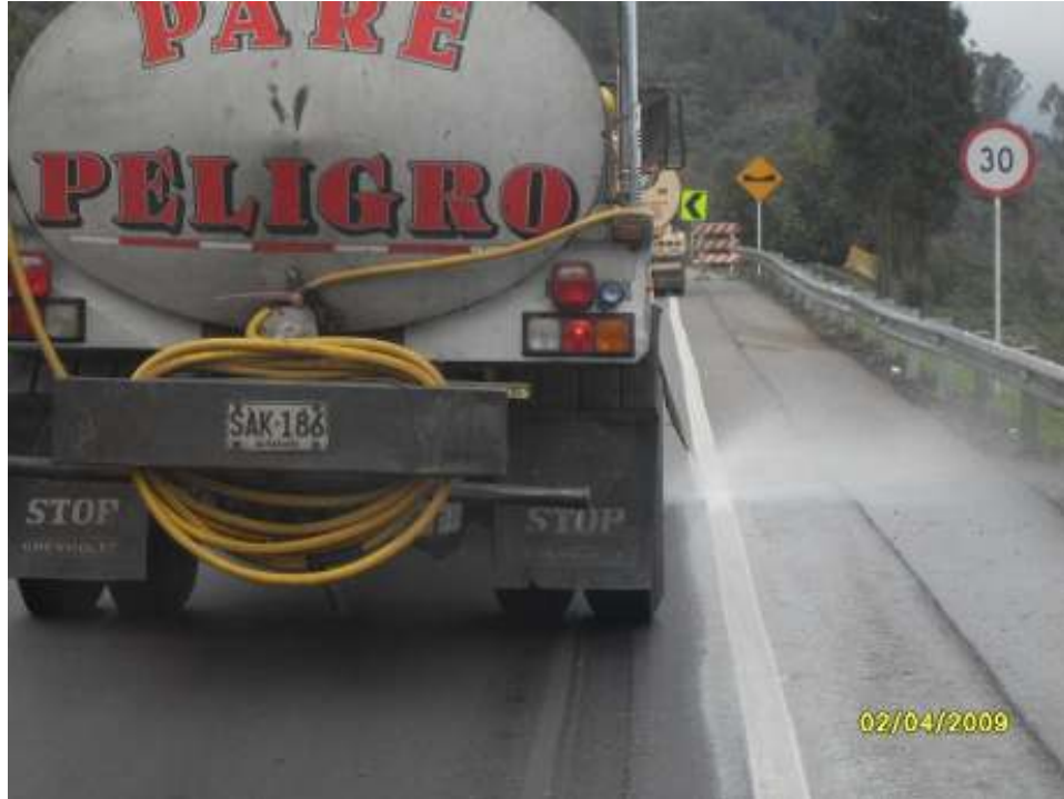
Figura 17. Lavado demarcación horizontal. Nótese que se hace solo con chorro de agua a presión para no desprender la microesfera (Fuente archivo personal de los autores).
