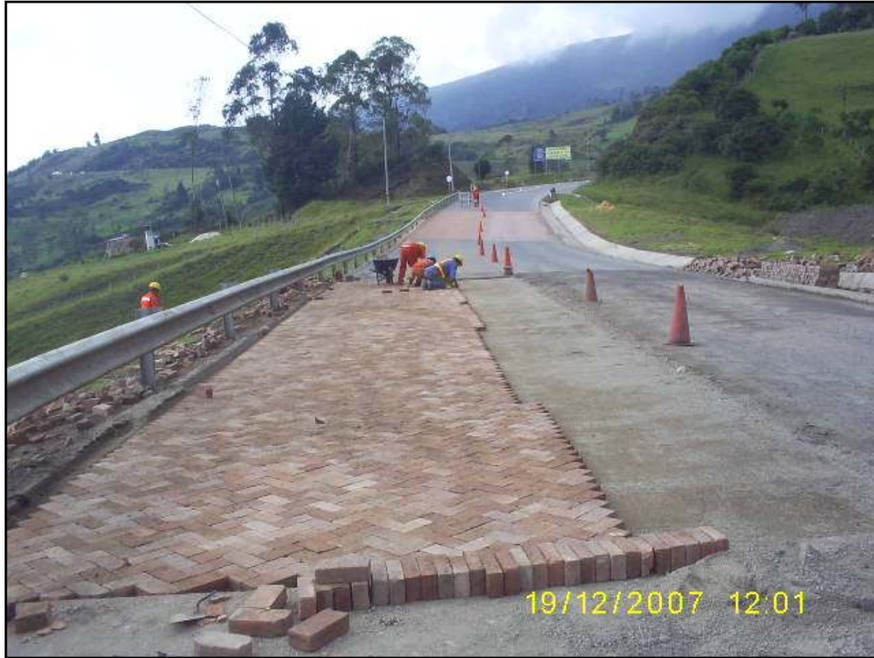
Figura 30. Mantenimiento según auscultación de pavimentos. Sector inestable en una carretera, se utiliza pavimento articulado para hacer las reparaciones periódicamente con facilidad y a bajo costo. (Fuente archivo personal de los autores).
