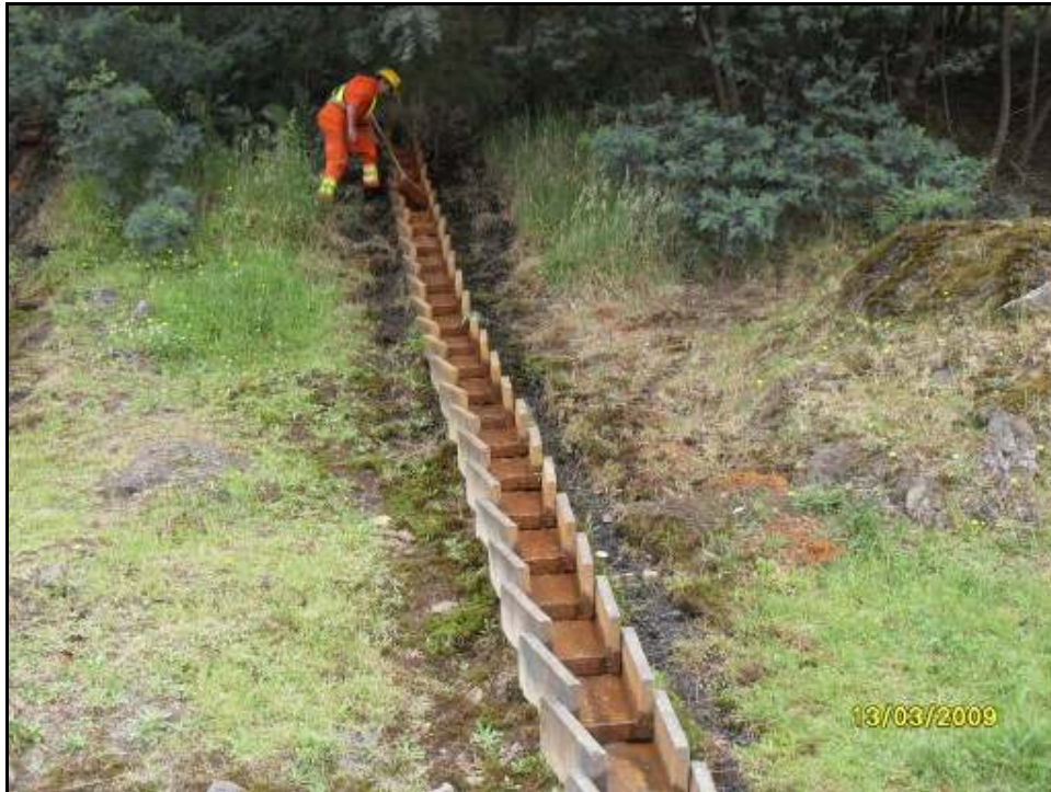
Figura 12. Mantenimiento rutinario. Limpieza de zanjas de coronación, torrenteras y bajantes. (Fuente archivo personal de los autores).
