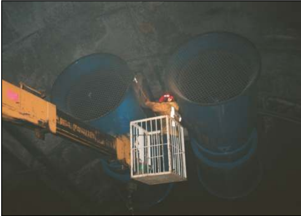
Figura 6. Mantenimiento rutinario. Mantenimiento sistemas de ventilación de un túnel (Fuente archivo personal de los autores).
