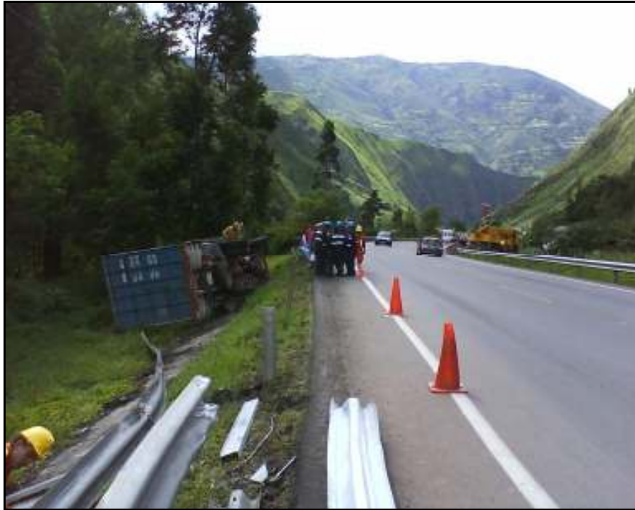
Figura 33. Atenciones inmediatas. Accidente vehicular, nótese el estado de la defensa metálica, que se debe intervenir en menos de 24 horas. (Fuente archivo personal de los autores).
