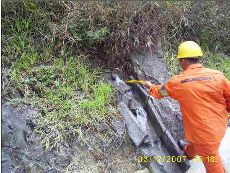
Figura 13. Mantenimiento rutinario. Lavado drenes horizontales. (Fuente archivo personal de los autores).
