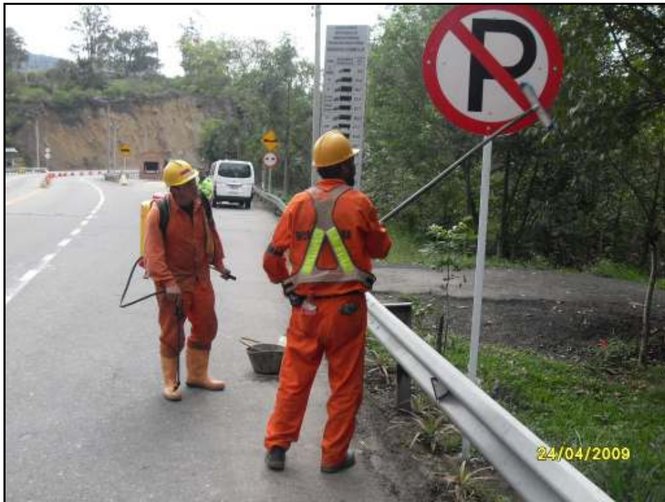
Figura 15. Mantenimiento rutinario. Lavado señales verticales (Fuente archivo personal de los autores).
