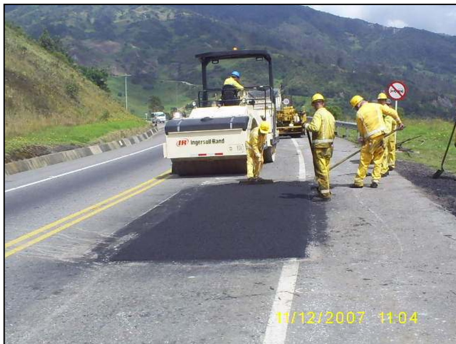
Figura 31. Atenciones inmediatas. Trabajos de bacheo en la vía. (Fuente archivo personal de los autores).
