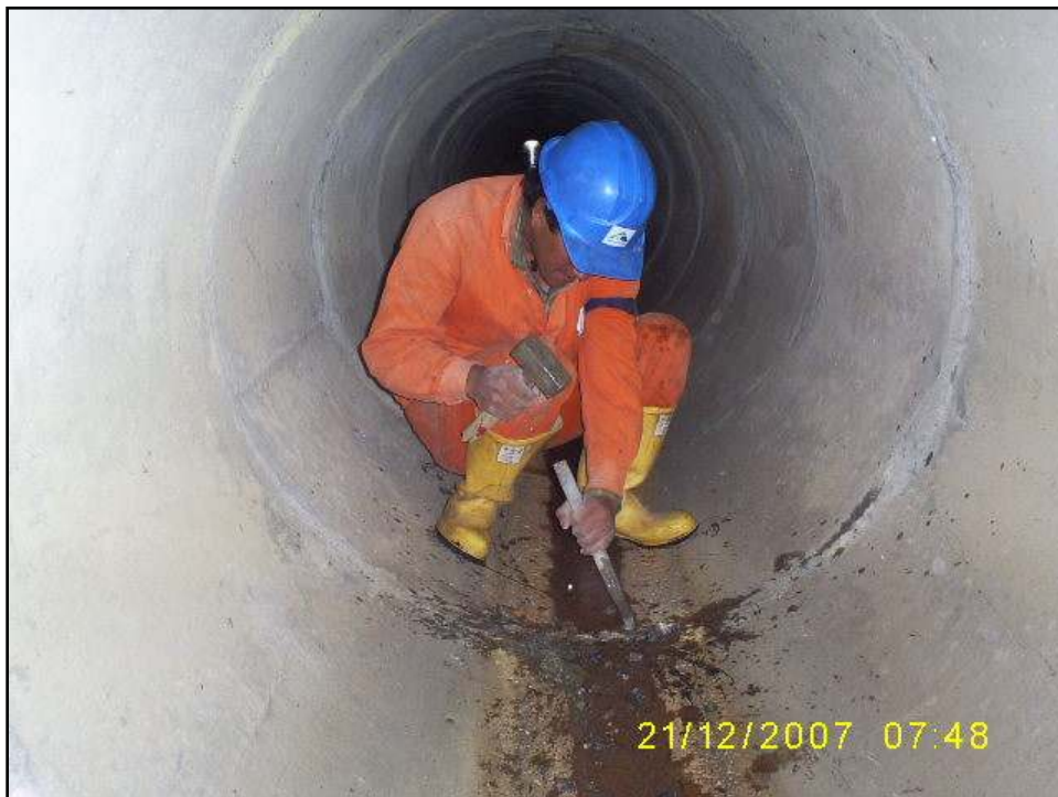
Figura 11. Mantenimiento rutinario. Sello de anillos de tuberías de alcantarillas (Fuente archivo personal de los autores).
