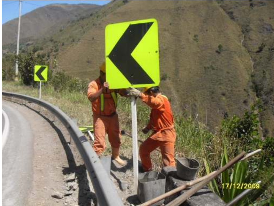
Figura 23. Mantenimiento según auscultación señales verticales. (Fuente archivo personal de los autores).
