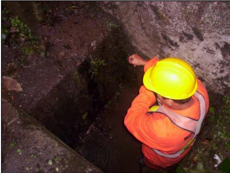
Figura 9. Mantenimiento rutinario. Limpieza cajas de alcantarilla. (Fuente archivo personal de los autores).
