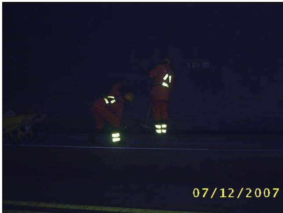
Figura 1. Mantenimiento rutinario. Limpieza de sumideros dentro de un túnel (Fuente archivo personal de los autores).
