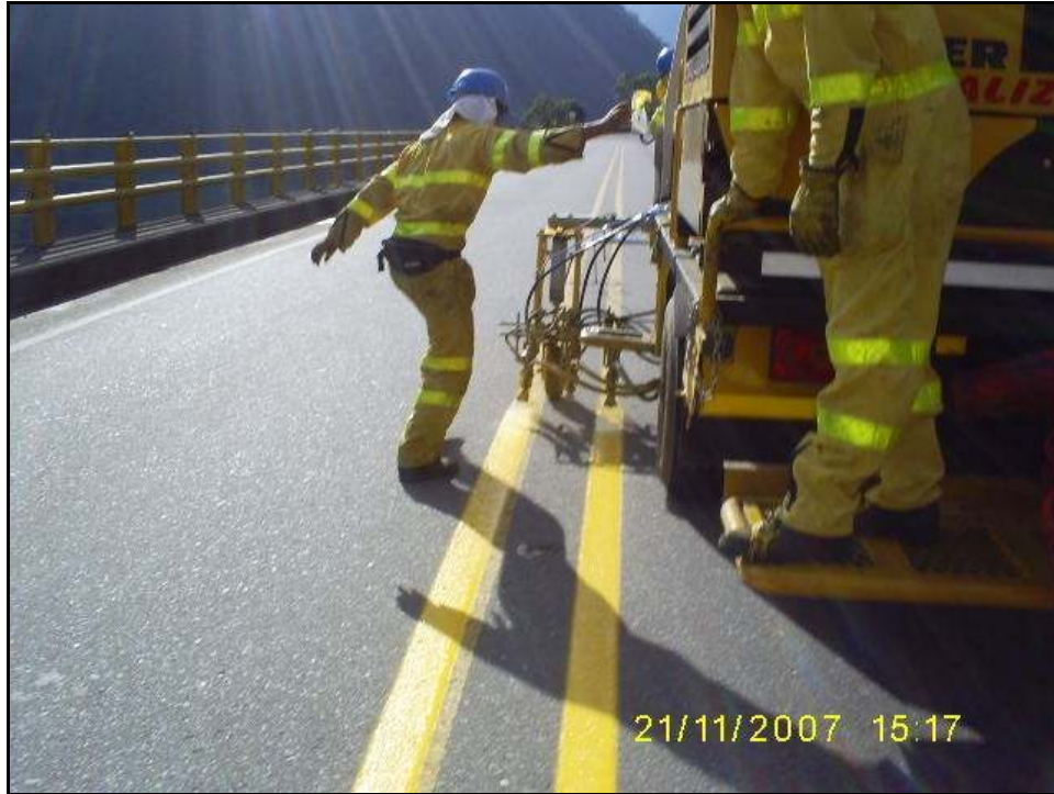
Figura 24. Mantenimiento según auscultación señales horizontales. (Fuente archivo personal de los autores).
