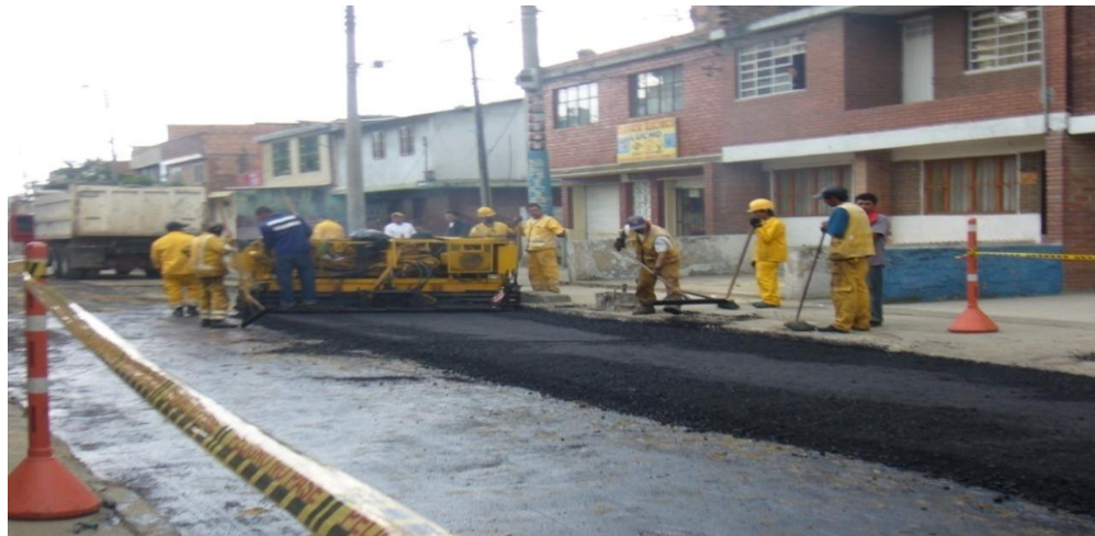
Extensión y compactación base asfáltica MDC-1 y base de rodadura MDC-3
