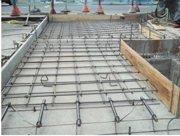
Fotografía 27. Acero de refuerzo
