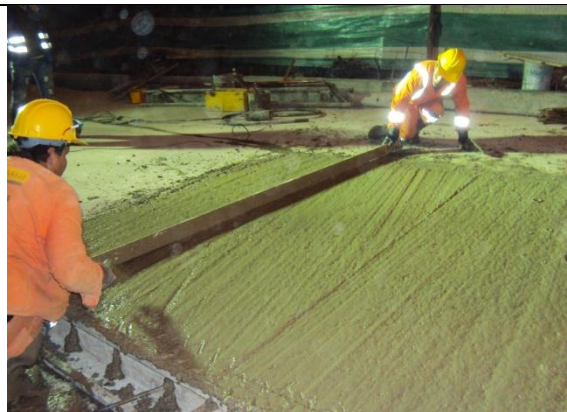
Fotografía 25. No regla vibratoria de concreto
