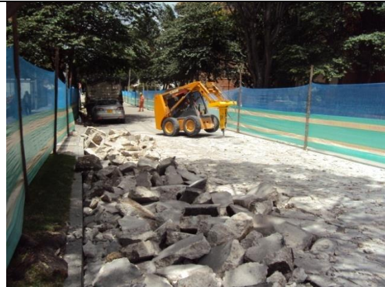
Fotografía 8. Demolición de concreto con martillo hidráulico.
