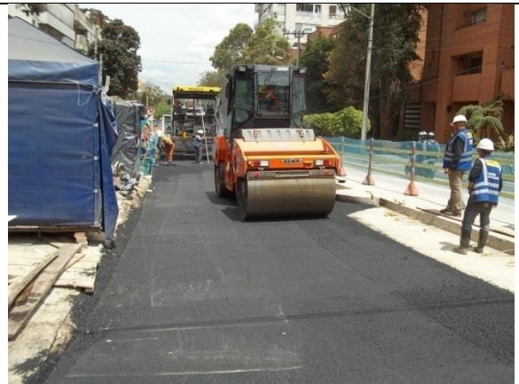
Fotografía 26. Compactación de asfalto
