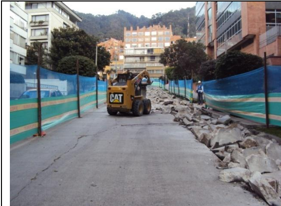
Fotografía 7. Demolición de concreto en cada una de las etapas del proyecto.
