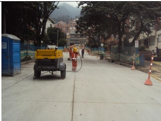
Fotografía 31. Compressor para limpiar los cortes del concreto
