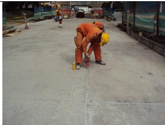
Fotografía 32. Producto para sellar las juntas de las placas
