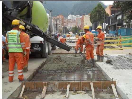
Fotografía 19. Colocación de formaleta de madera
