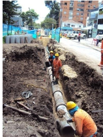
Fotografía 16. Instalación de tubería y rellenos
