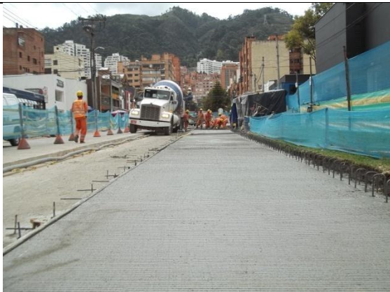
Fotografía 20. Colocación de carga en las losa del los lados
