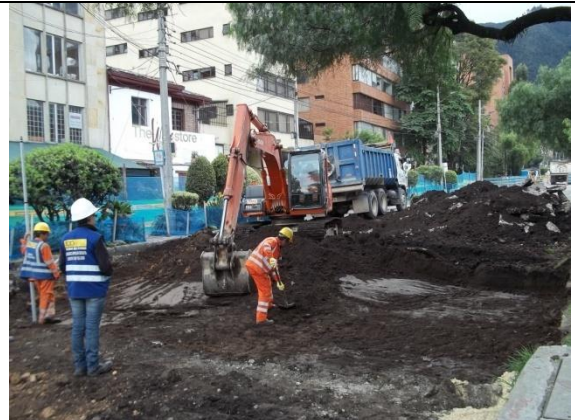
Fotografía 10. Se niveló y se procedió a compactarlo
