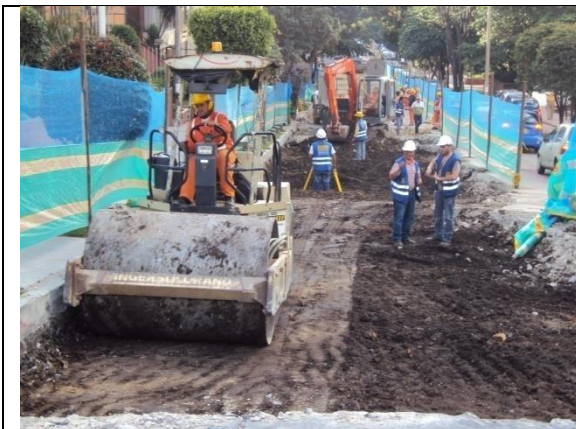
Fotografía 11. Compactación de la subrasante
