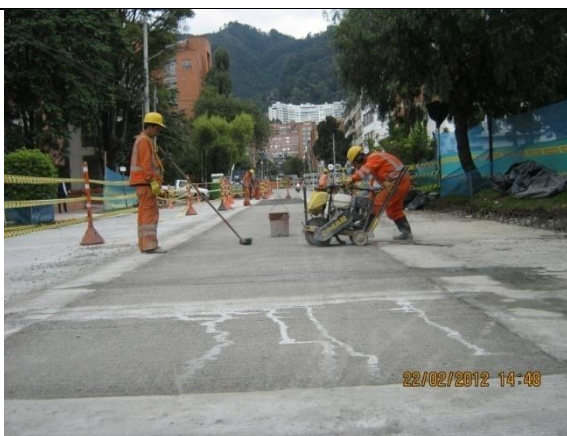
Fotografía 33. Corte de juntas de placas de concreto
