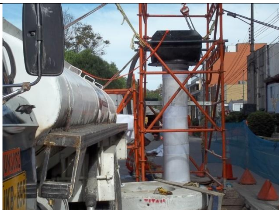
Fotografía 42 .Instalación de calor para el curado de la manga
