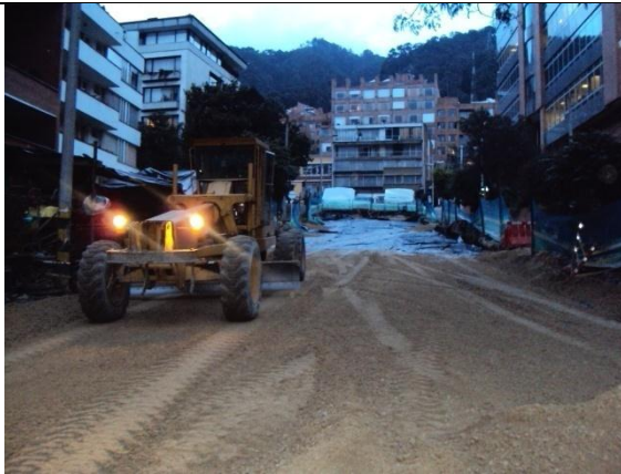
Fotografía 19. Nivelación de sub base tipo B
