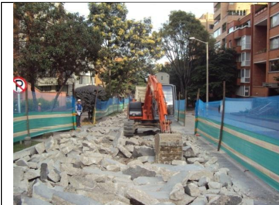
Fotografía 9. Excavación mecánica
