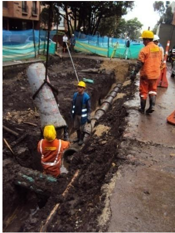
Fotografía 15. Excavación e instalación de tubería en la dos primeras etapas de la obra
