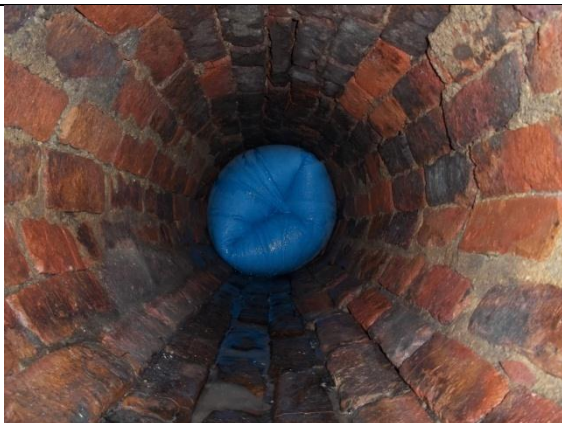
Fotografía 39. Instalación de la manga en el colector
