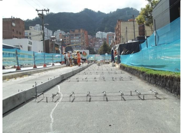
Fotografía 28. Formaleta y acero de separación de placas
