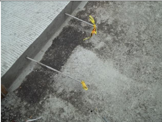
Fotografía 18. Diferentes longitudes de los aceros longitudinales
