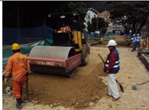
Fotografía 20. Compactación de B-400.
