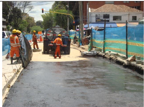
Fotografía 22. Procedimiento al imprimir
