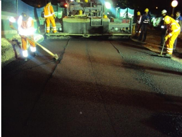
Fotografía 23. Extensión de asfalto
