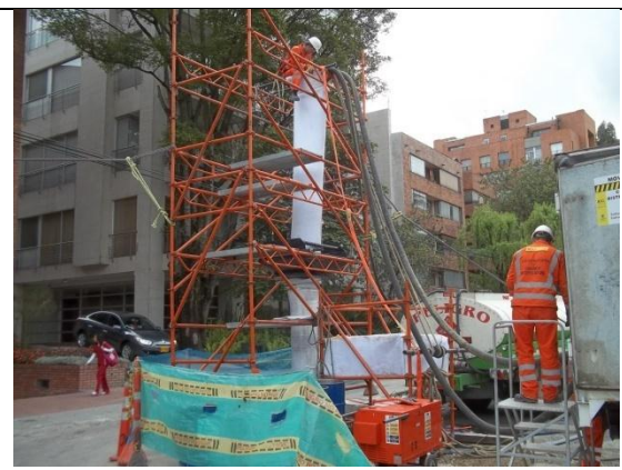
Fotografía 44.Instalación de la manga en el colector
