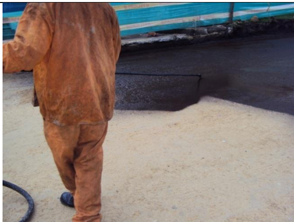
Fotografía 21. Imprimación con emulsión lenta CRL
