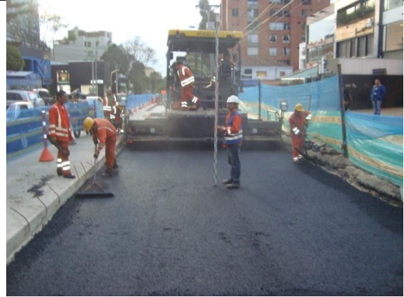
Fotografía 24. Instalación de asfalto y nivelación
