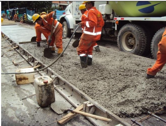
Fotografía 29. Colocación del concreto
