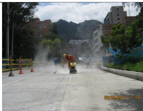
Fotografía 34. Corte de concreto
