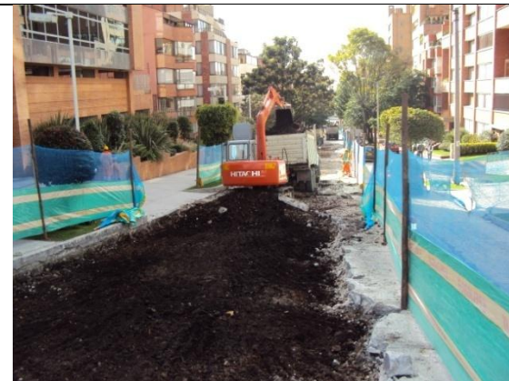
Fotografía 9. En las tres primeras etapas se excavó por media calzada.
