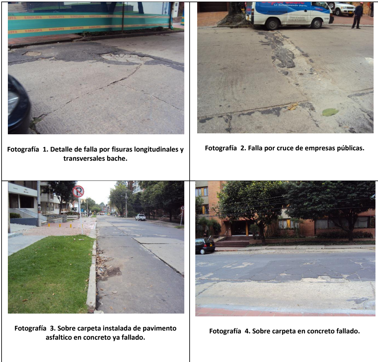
Figura 2. Imágenes de recopilación de obra obtenidas antes de iniciar la obra
