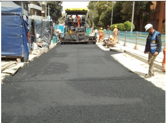
Fotografía 25. Toma de temperatura en la extensión de asfalto
