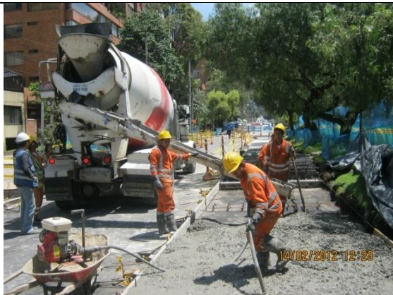
Fotografía 21. Utilización de solo vibrador de concreto
