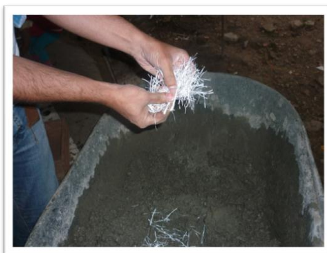
Figura 3. Aplicación de fibras sintéticas en el concreto
