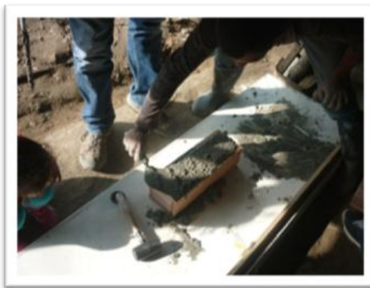
Figura 1. Vaciado de concreto en los especímenes diseñados para las viguetas
