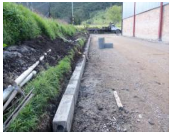
Instalación de elementos para confinamiento
