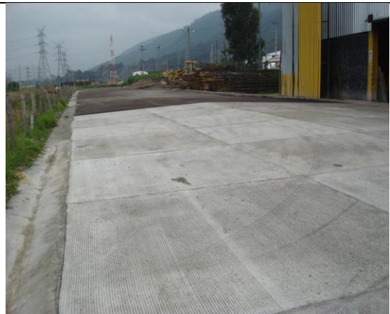
Vista asfalto reciclado en frio y zonas en pavimento rígido, obra terminada
