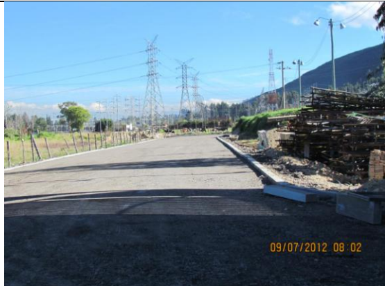
Vista asfalto reciclado a nivel de rasante
