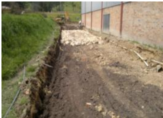
Excavación para arreglo de acceso a las oficinas de la bodega, así como el primer tramo de rajón instalado.
