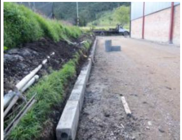
Instalación de elementos para confinamiento
