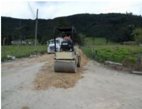
Instalación de Sub-base tipo B-200
