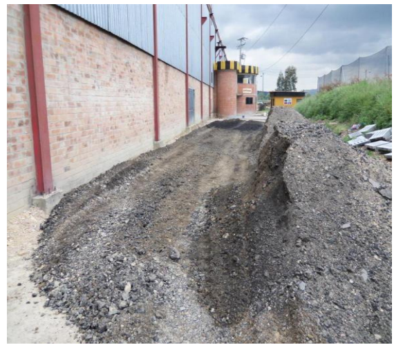
Céreo de capas para proceder a compactar posteriormente
