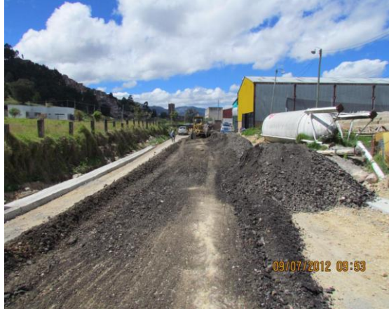
Acordonamiento de material de fresado
