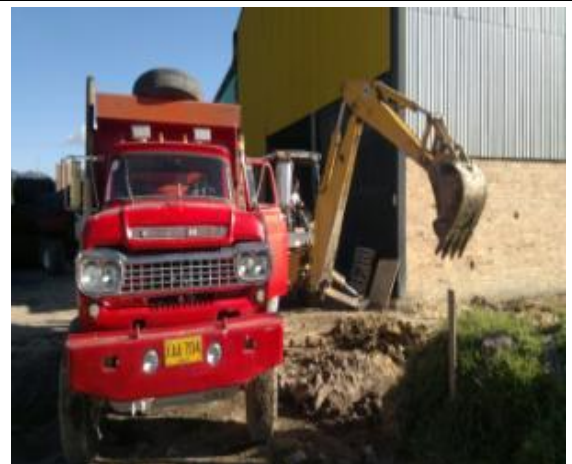
Retiro de escombros y material sobrante
