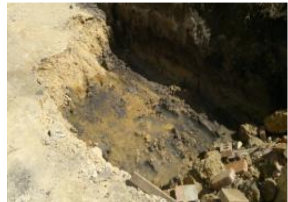
Excavación para reparar fallo evidenciado luego de someter a carga el tramo. Se presenta nivel freático (agua que permanece de manera constante).
