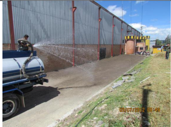
Base granular, capa terminada
