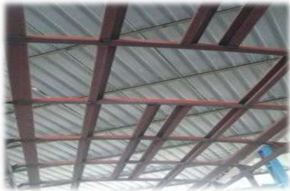
Figura 8. Estructura de techo – unidad de transporte
