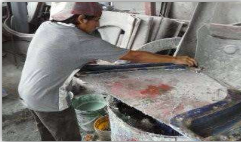
Figura 16. Aplicación del desmoldante
