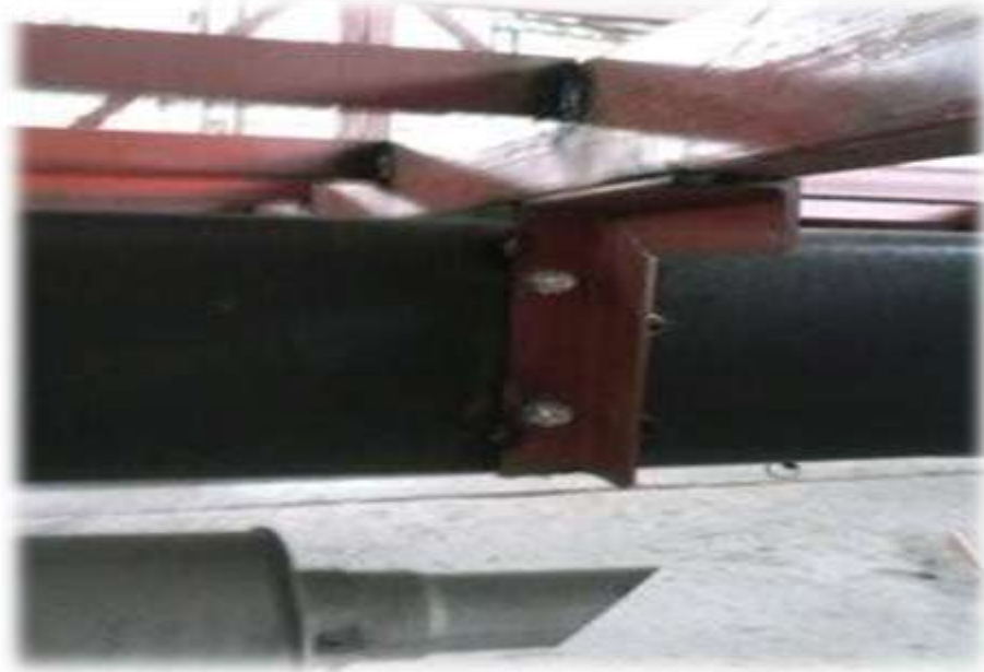
Figura 5. Anclaje en la estructura
