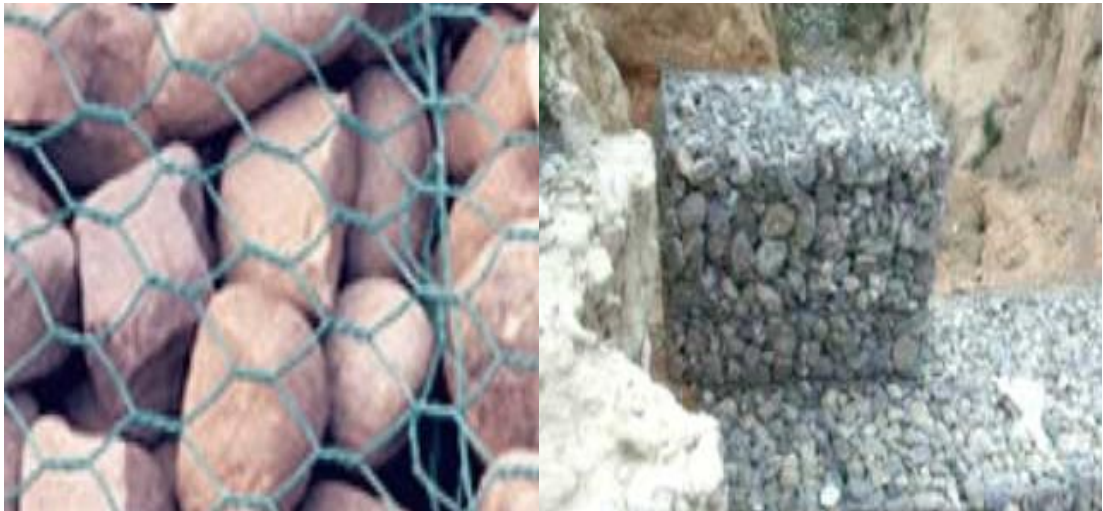
Piedra Bola en gaviones
