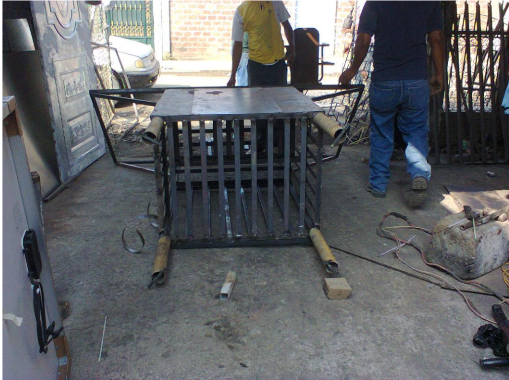
Armando la base de soporte del panel solar
