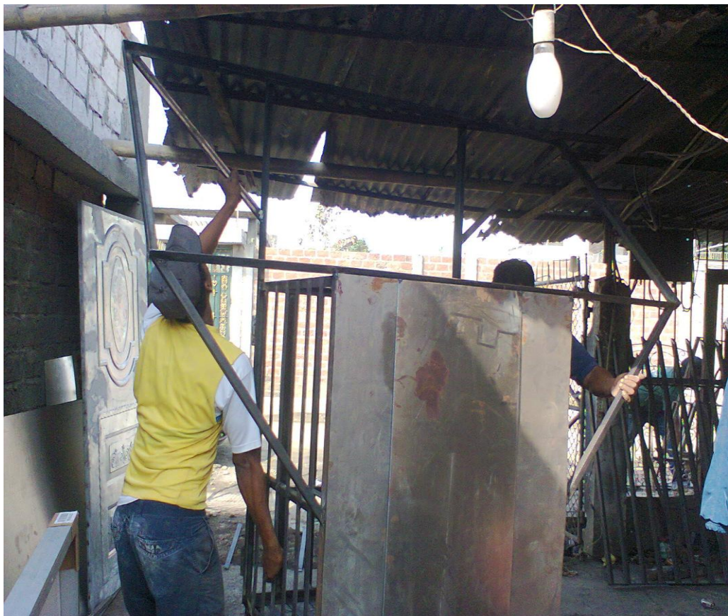
Preparación de la estructura para el montaje del panel solar
