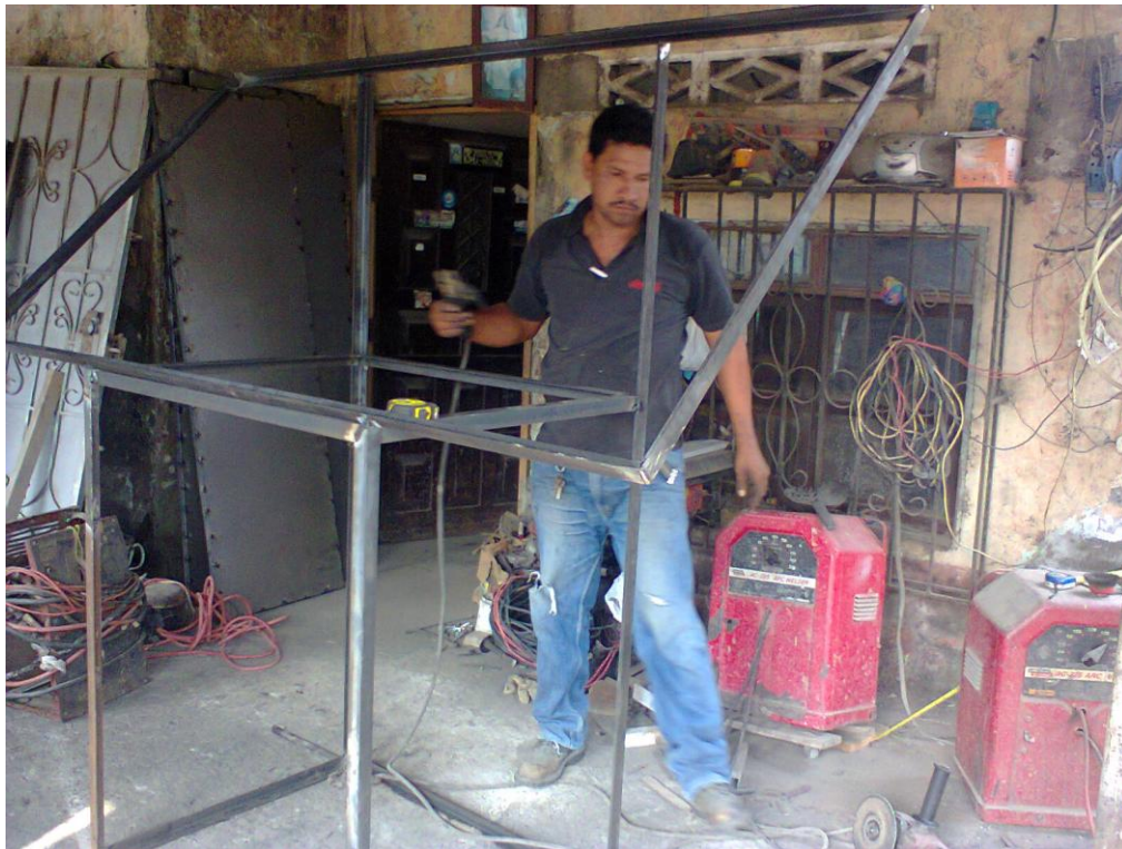
Medición y corte de partes para base del panel solar
