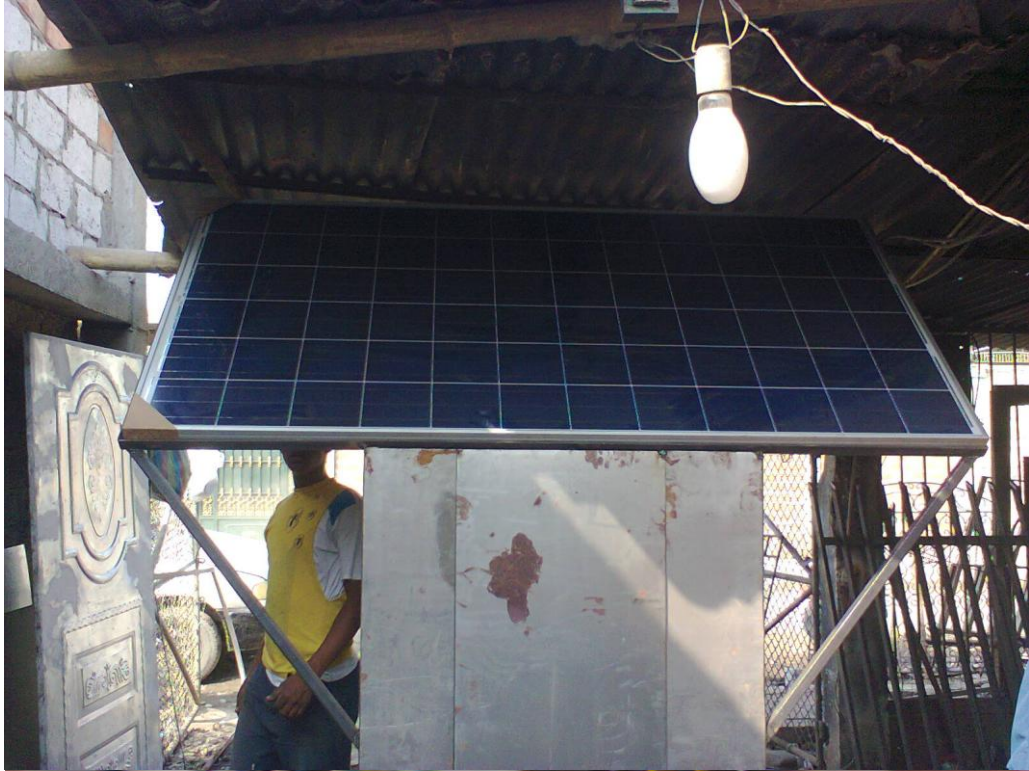
Montaje del panel solar
