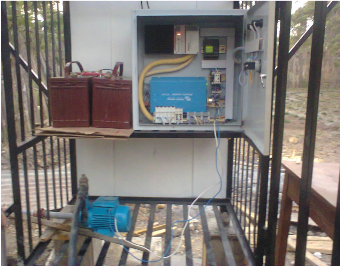
Verificación de la instalación de componentes del sistema automatizado
