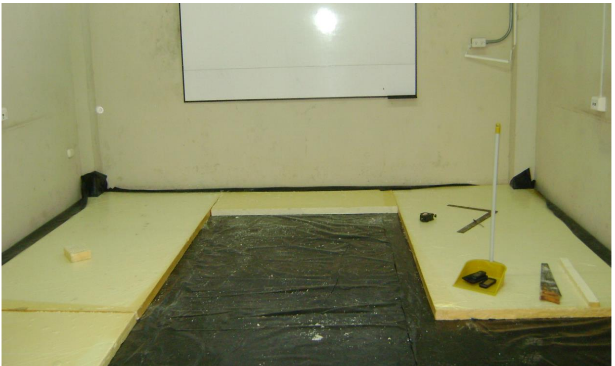
Figura 2. Barrera de vapor instalada en el piso de cámara frigorífica en la UNEMI.
