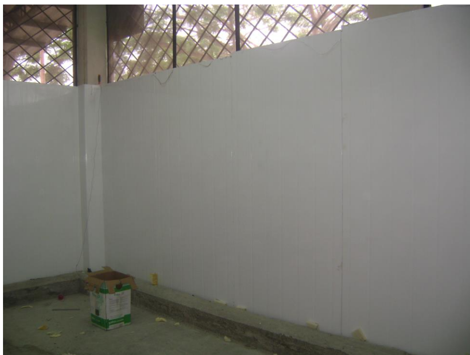
Figura 15. Instalación de las paredes de poliuretano dentro del aula donde se construye la cámara frigorífica UNEMI.
