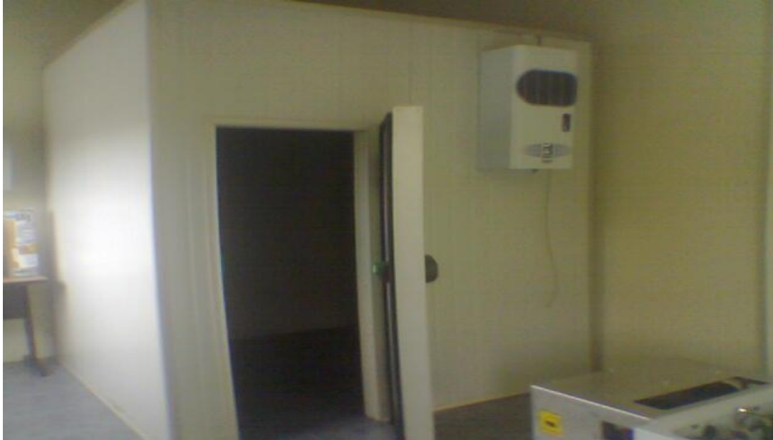
Figura 4. Sistema de refrigeración auto contenido o tipo mochila (Universidad Católica Santiago de Guayaquil)
