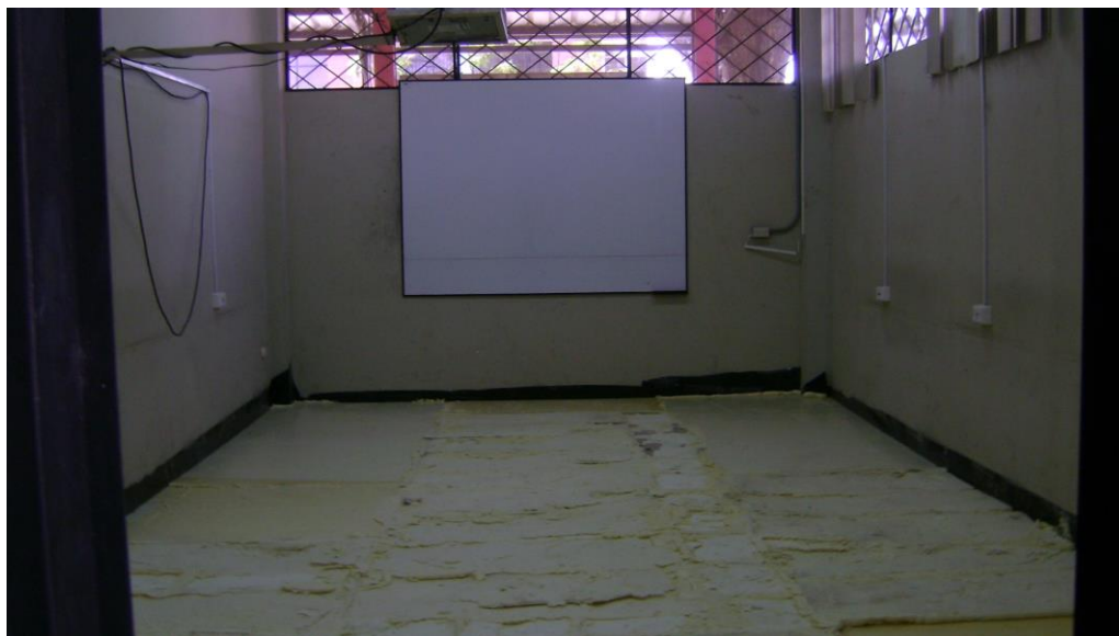
Figura 14. Instalación de material aislante poliuretano para el piso de cámara frigorífica UNEMI.
