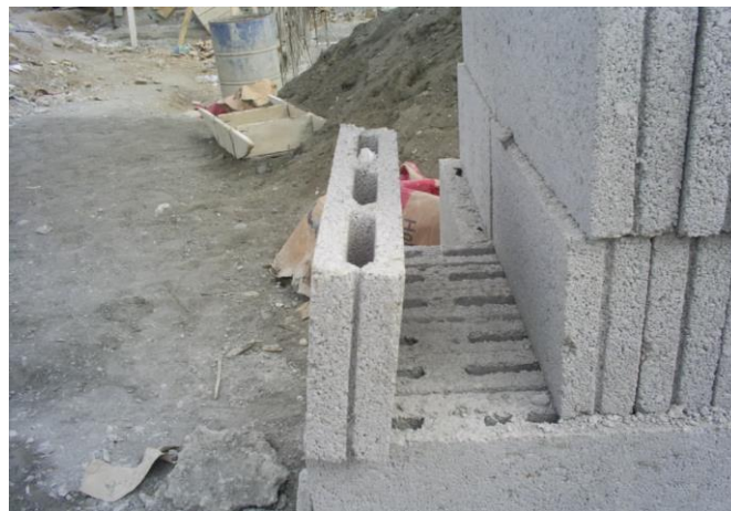
Figura 18. Bloque de construcción de paredes de cámara frigorífica (Ing. Manuel Flores)
