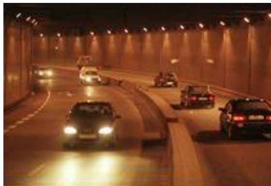
Figura 3. Túnel urbano de Beiramar en Vigo.
