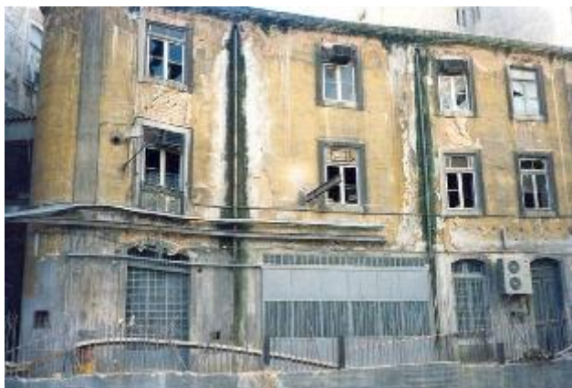
Figura 3.30 - Deformação imposta pela movimentação de terras [4].
