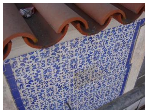
b) Telhado com revestimento a telha cerâmica de canudo [86].
