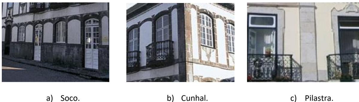
Figura 3.27 - Elementos caracterizadores em parede de fachada [119].
