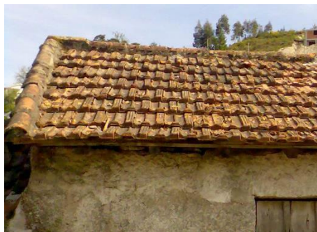
b) Telhado em telha de Marselha.
