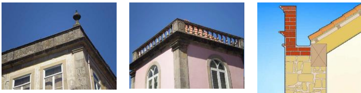
a) Platibanda [2].
