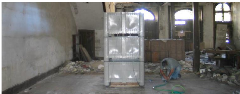
Figura 3.56 - Ensaio de carga estático sobre pavimento de madeira [44].
