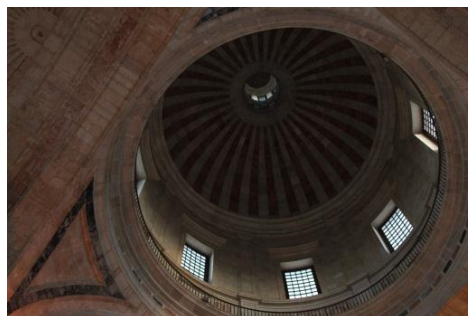
b) Vista interior de cobertura curva.
