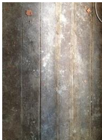
b) Desgaste do revestimento de madeira.
