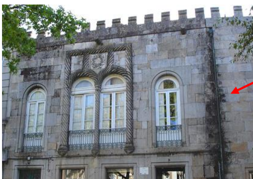
Figura 3.41 - Cobertura biológica em fachada [55].
