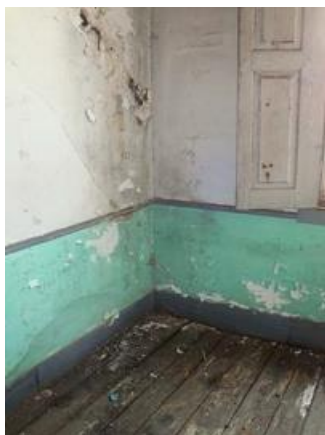
a) Degradação soalho junto a parede humedecida [2].
