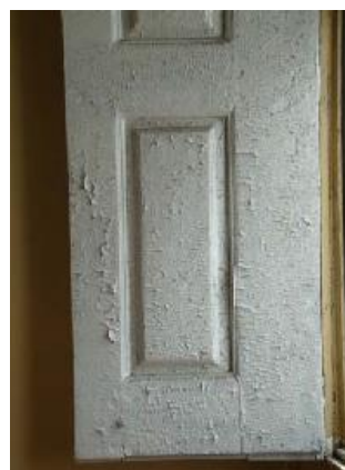
b) Portada interior com pintura degradada devido a exposição solar [2].
