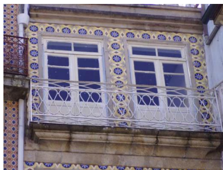
b) Revestimento a azulejo [2].
