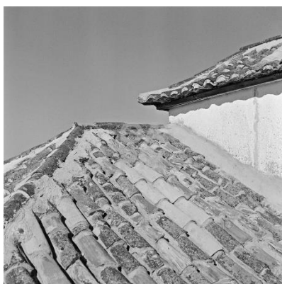
a) Telhado mouriscado [113].
