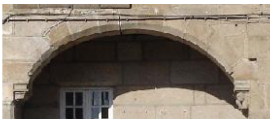
a) Arco em blocos de pedra talhada [55].
