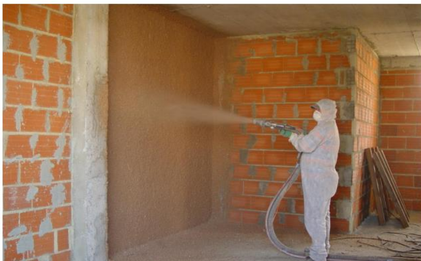
Figura 2.18 – Celulose sendo projetada em parede.
