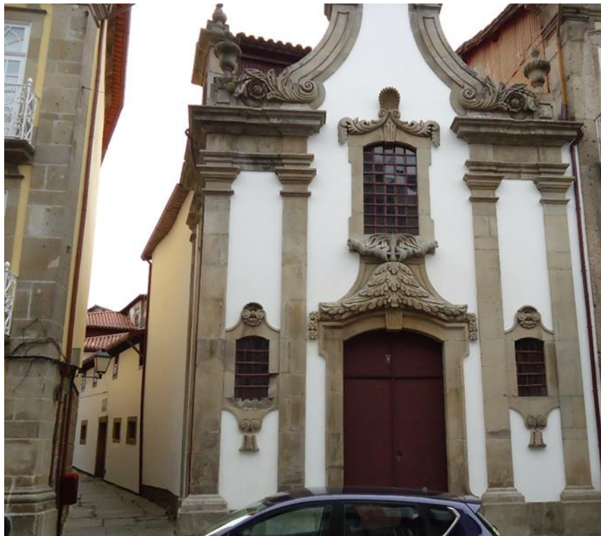
Figura 26 – Fachada principal da Capela de S. Crispim (Guimarães).
