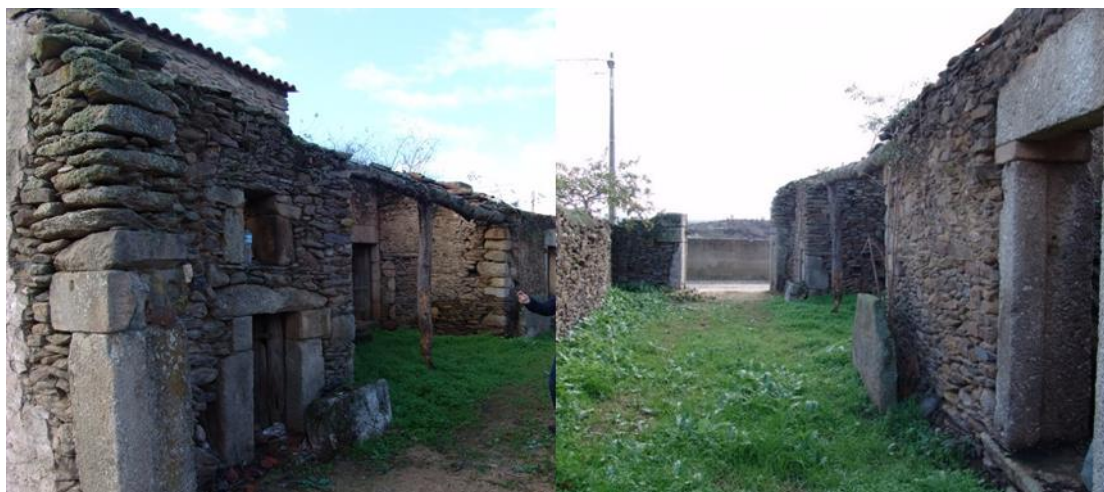
Figura 39 – Pátio anexo à Albergaria de Escarigo (cedido por serviços camarários de Figueira de Castelo Rodrigo).
