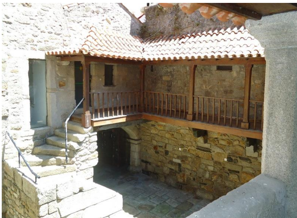
Figura 56 – Pátio interno do Hospital Velho e escada de acesso ao varandim de madeira.
