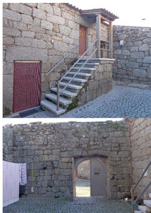
Figura 32 – Interior do pátio da Albergaria de Linhares.
