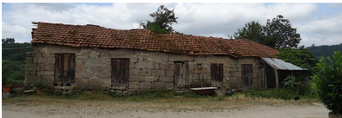
Figura 45 – Edifício que esteve anexo à Albergaria de Canaveses.
