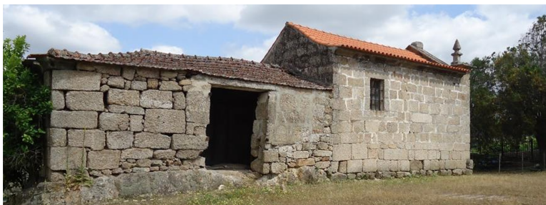
Figura 44 – Fachada Sudeste da Albergaria de Canaveses, com entrada para a “cozinha”, e sua capela.
