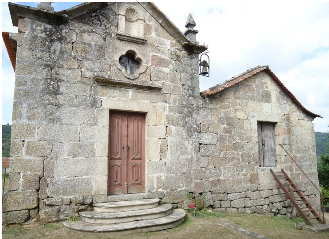
Figura 42 – Entrada da Capela do Espírito Santo e Albergaria de Canaveses anexa.
