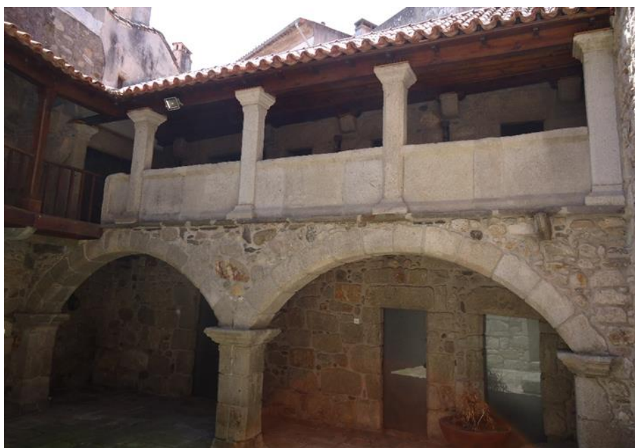
Figura 57 – Balcão de granito no lado SO do pátio do Hospital Velho.
