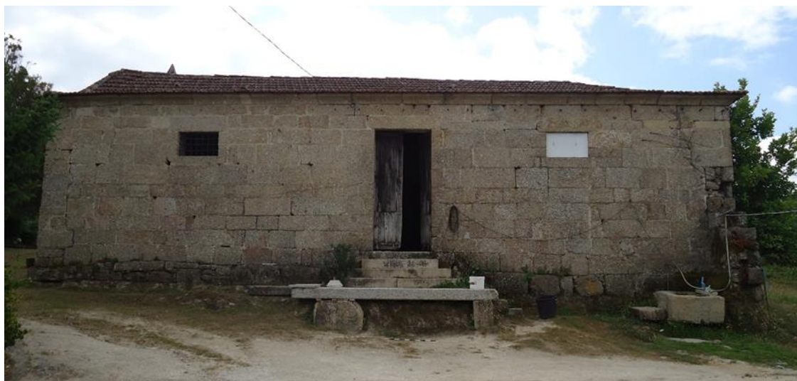
Figura 43 – Fachada Noroeste da Albergaria de Canaveses.
