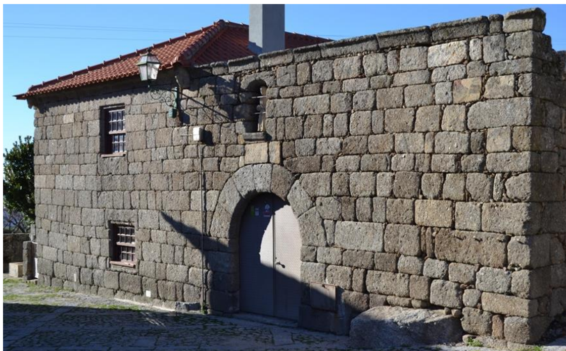
Figura 33 – Fachada da Albergaria de Linhares.
