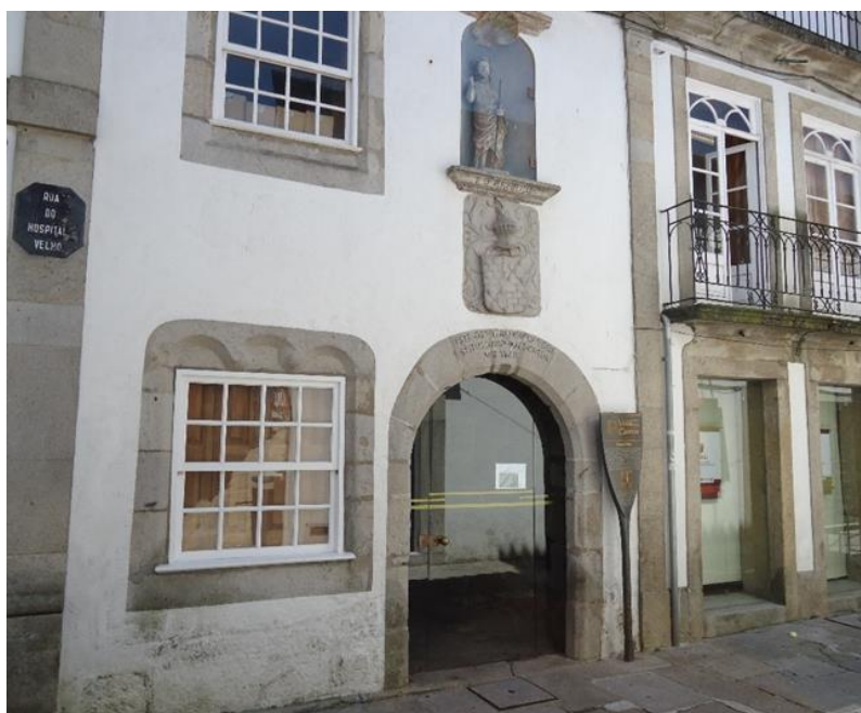
Figura 55 – Fachada do Hospital Velho de Viana do Castelo.
