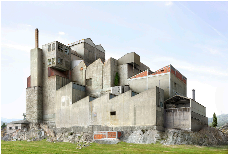
UNIDADE E VARIEDADE, A CASA-MÃE DO MONTE DA DEFESA VELHA
