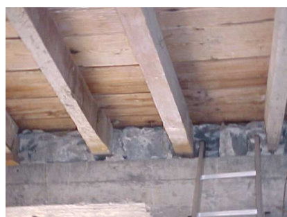
Fig. 10 - Pormenor dos Pavimentos
