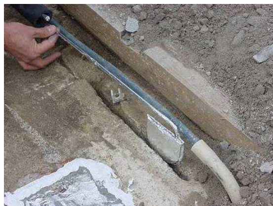
Fig 16c- Células de pressão total: C3, modelo 3500 (meia-lua) em fase de instalação.
