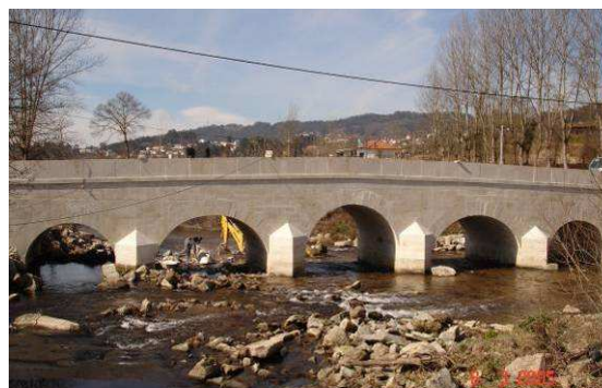
Fig 3- Aspecto final geral da nova ponte (montante)
