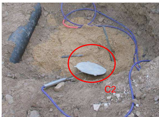
Fig 16b- Células de pressão total: C2, modelo 3500 (circular) em fase de instalação.
