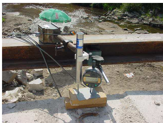
Fig 4b- Descimbre de um arco. Comparador digital e LVDT no coroamento do arco.
