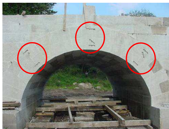
Fig 8b- Instrumentação de juntas. Posições dos transdutores de deslocamento num arco.
