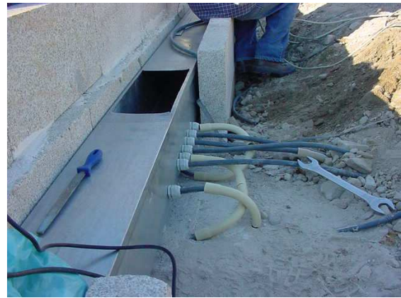
Fig 18- Aspecto da calha técnica
