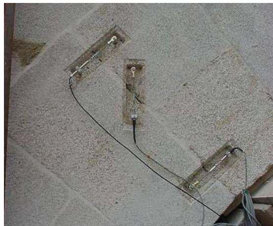
Fig 8a- Instrumentação de juntas. Configuração em Z dos transdutores de deslocamento.
