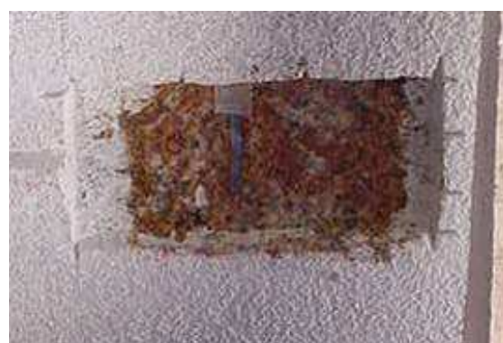
Fig 13a- Colocação de extensómetros. Regularização de base e extensómetro colado em cavidade previamente aberta.
