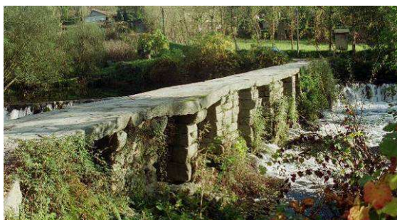
Fig 1- Vista geral da antiga passagem existente
