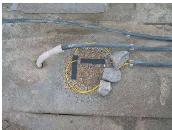
Fig 14- Extensómetros de base óptica. Instalação.
