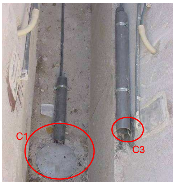
Fig 16a- Células de pressão total: C1, modelo 3510 (circular) e C3, modelo 3500 (meia-lua), já instaladas.
