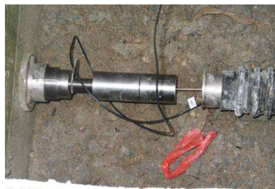
Fig 11- Sensores longos transversais. Zona de amarração no muro-tímpano.
