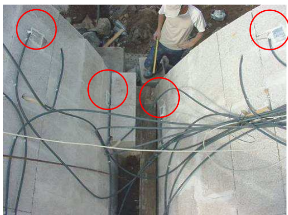
Fig 13c- Colocação de extensómetros. Vista geral em fase de recobrimento com pedra do tímpano.
