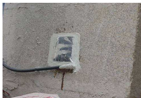
Fig 13b- Colocação de extensómetros. Protecção final.
