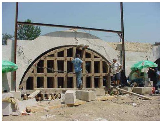
Fig 4a- Descimbre de um arco. Pórtico de referência para comparadores e LVDT's.
