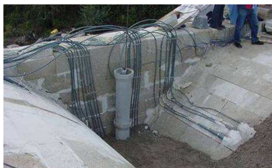
Fig 7b- Colunas de apoio aos sensores de pressão (vista geral na fase de construção).
