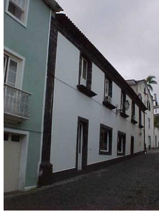
Figura 23: Quarteirão - Inclinação da Travessa da Misericórdia.
