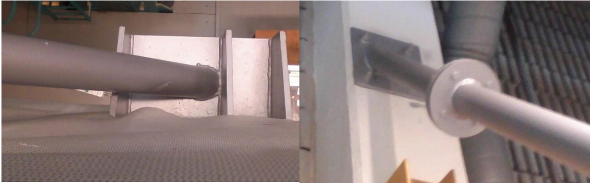
Fig. 66 – Pormenor da ligação dos perfis de reforço CHS 88x5.
