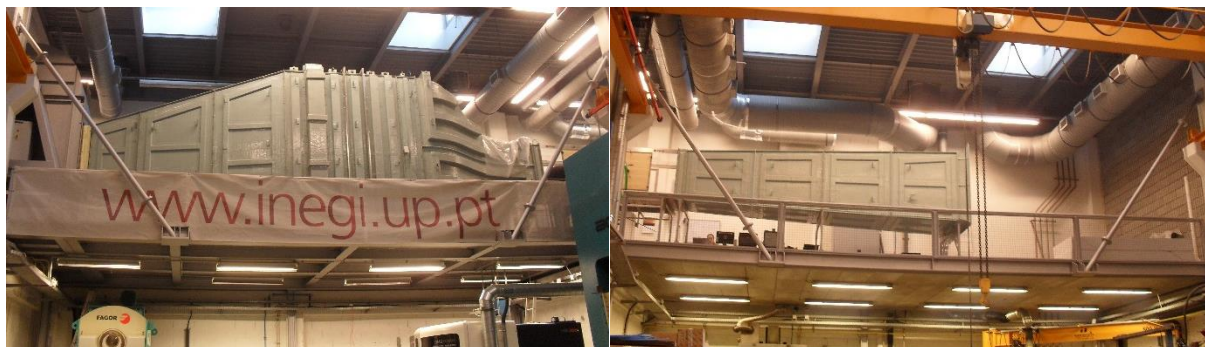
Fig. 61 – Imagens da estrutura de suporte depois do reforço.
