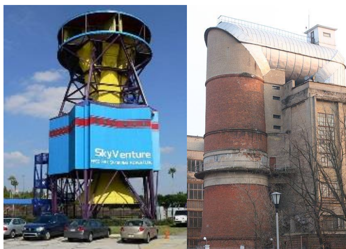
Fig. 11 - Túneis de vento verticais para skydiving e para o estudo de piruetas em aviões.
