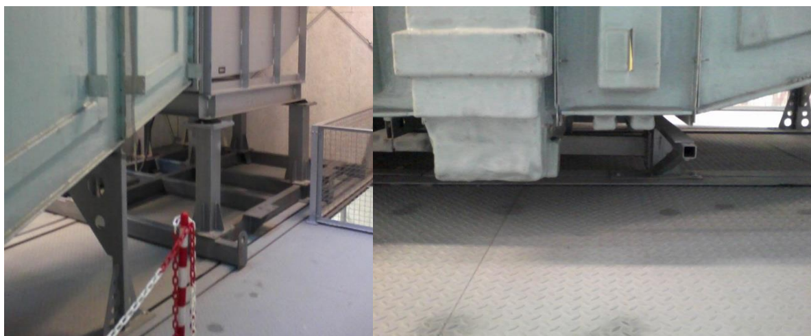
Fig. 57 – Pormenor de ligação do túnel à estrutura.
