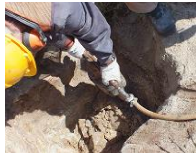
Figura 3.6 - Abertura de Cova em Rocha Branda
