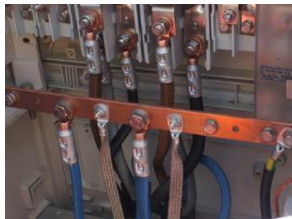
Figura 3.18 - Exemplo de Trança de Cobre Flexível de 16mm 2
