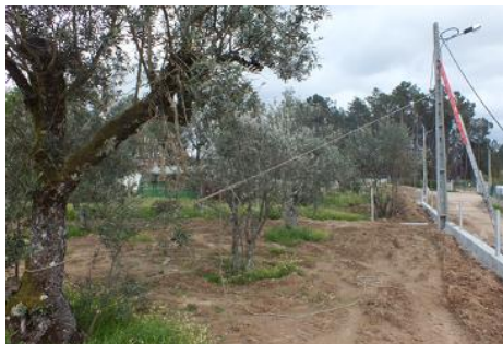
Figura 3.13 - Montagem de Espias (Corda)
