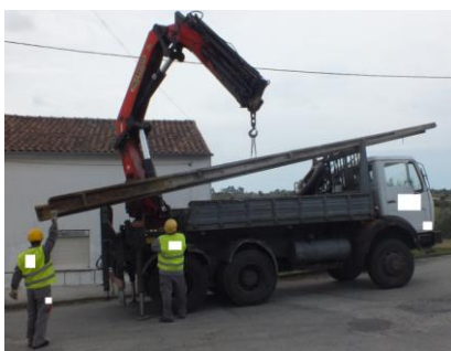
Figura 3.4 - Exemplo de Transporte de Poste Reutilizável.
