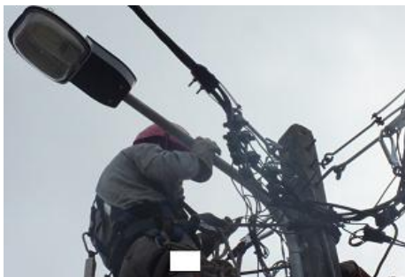
Figura 3.19 - Exemplo de Colocação de Braço IP
