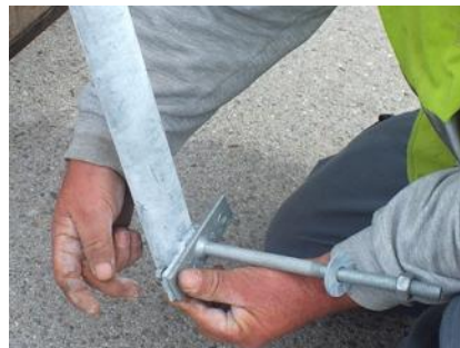
Figura 3.20 - Exemplo de Colocação de Espigão
