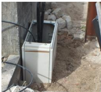
Figura 3.17 - Exemplo de Colocação da Base do Armário
