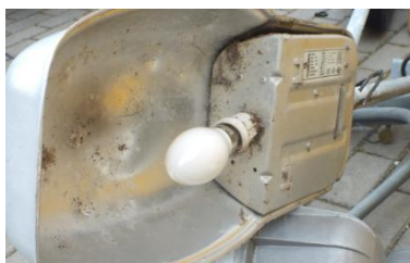
Figura 3.21 - Desmontagem de um Foco IP
