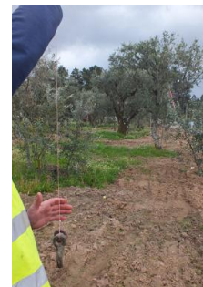
Figura 3.14 - Aprumação de Poste
