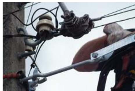
Figura 3.10 - Rabo de Porco + Alongador + Pinça de Amarração de 50mm 2
