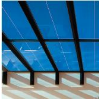
Figura 3.15 - Zonamento em painel – nesta imagem podem ver-se os cabos dividindo em duas secções o mesmo painel de forma a poderem ser controladas em separado [13]
