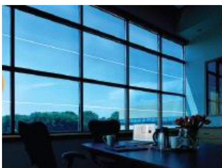
Figura 3.18 - Variação da cor da luz transmitida para o exterior quando o vidro encontra-se no seu último estado [13]
