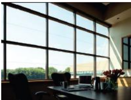
Figura 3.17 - Cor da luz transmitida para o interior quando o vidro está totalmente transparente [13]
