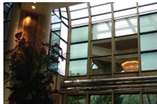
Figura 3.16 - Vidro totalmente escurecido e no seu estado intermédio de coloração [55]
