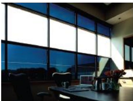
Figura 3.19 - Cor da luz transmitida para o interior quando 1/3 do vidro está transparente [13]
