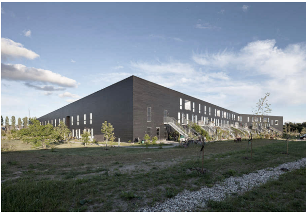
[25] Edifício Lange Eng, edificação e fachada externa.
