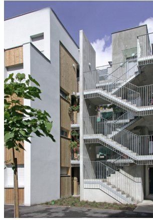
[88] Edifício La Passerelle vista trás.
