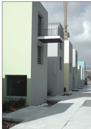
[79] Percurso pedonal exterior.
