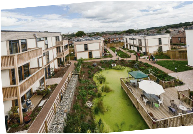
[38] Projeto Lilac, edificação e espaços exteriores.
