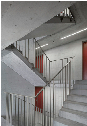
[119] Acesso em caixa de escadas.
