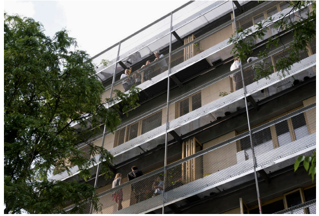
[57] Edifício R50 – varandas contínuas.
