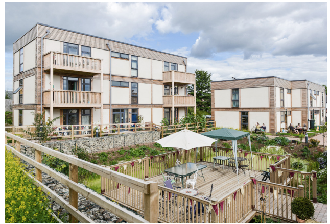
[39] Projeto Lilac, edificação e espaços exteriores.
