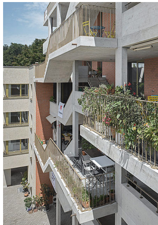
[120] Galeria exterior comum.
