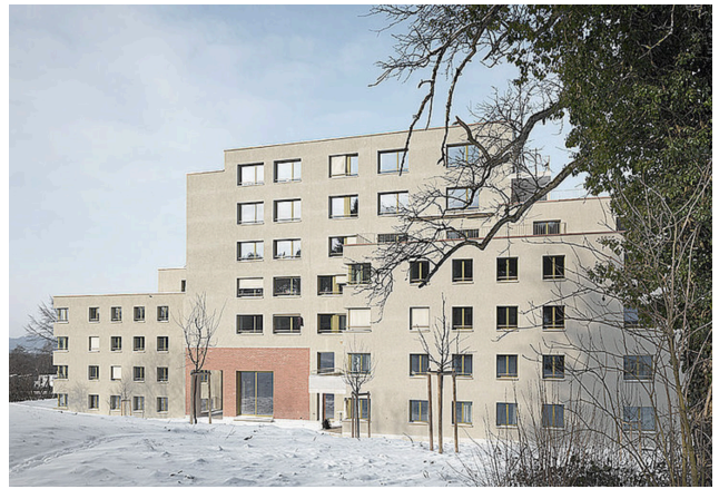
[118] Edifício Wohnüberbauung Kraftwerk 2 – fachada de trás.
