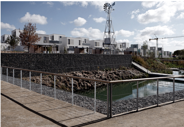
[76] Vista dos edifícios a partir da rua.
