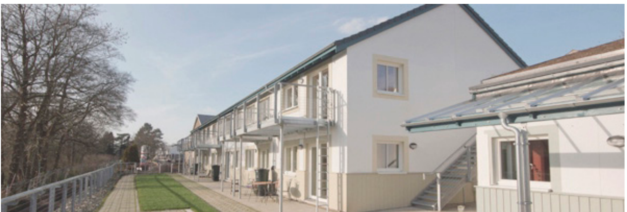
[24] Edifício de unidades privadas.
