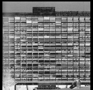
Unidade de habitação, Le Corbusier, 1952.
