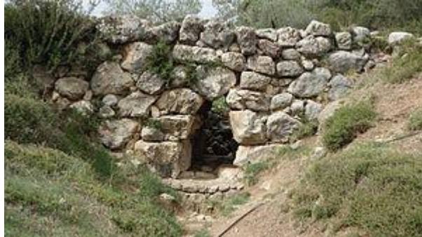
Fig. 2.3 – Ponte Arkadiko (wikipédia.org)
