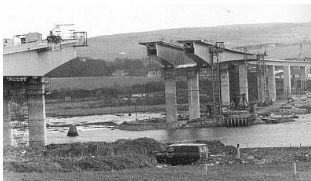
Fig. 2.15 – Ponte Foyle em construção ( www.wesleyjohnston.com )
