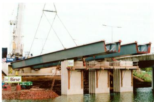
Fig. 2.13 – Ponte mista com caixão metálico em secção aberta ( www.steelconstruction.info )
