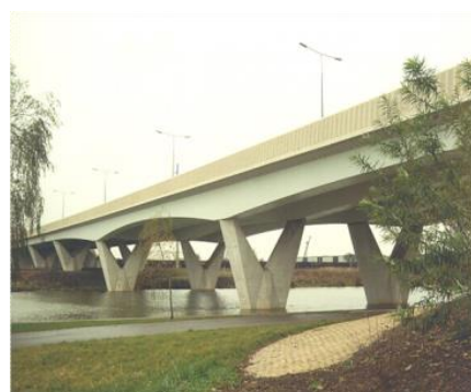
Fig. 2.14 – Ponte metálica com caixão de inércia variável ( www.steelconstruction.info )
