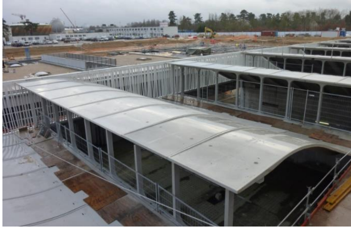
Figura 2.17 Cobertura em UHPFRC dos tanques da central de tratamento de águas residuais de Seine Aval no rio Sena, a jusante de Paris, França [66].
