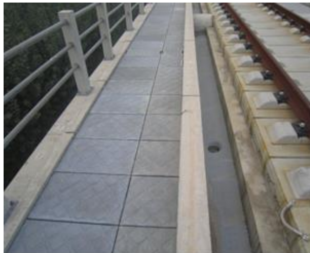
Figura 2.14 Pavimento constituído por elementos de UHPFRC ao longo de uma linha de caminho de ferro de alta velocidade na China [62].
