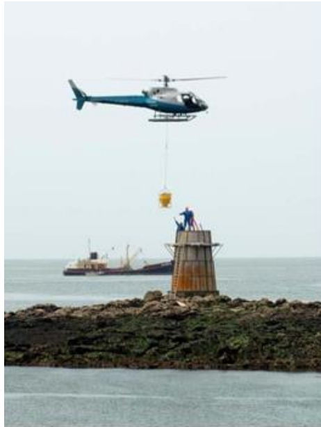
Figura 2.15 Reabilitação com o recurso a UHPFRC da torre de sinalização “Le Cabon” na baía do porto de Lorient em Brittany, França [64].
