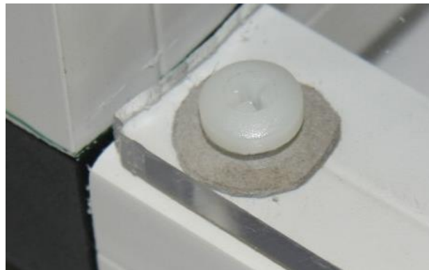
Figura 4.10 Pormenor da parte inferior da placa de acrílico onde é visível a cabeça de um dos parafusos de nylon que a estão a fixar e a respetiva anilha de cartão.
