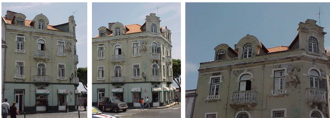
Figura 1 – Vistas do prédio, salientando-se as mansardas salientes
