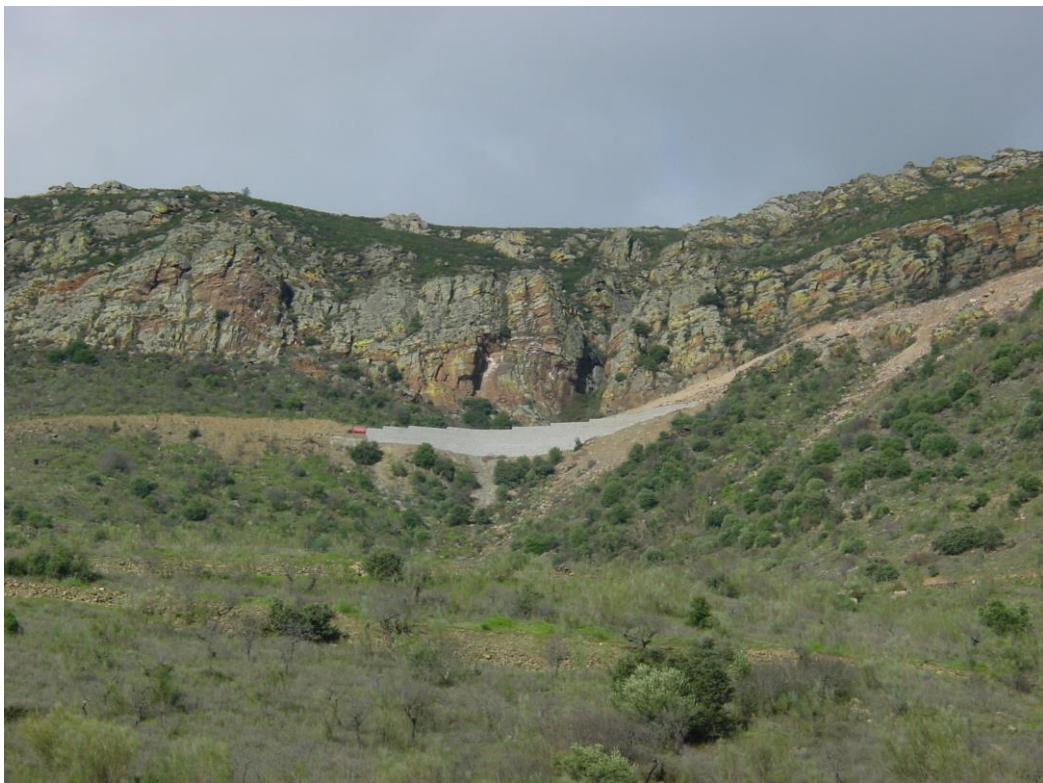
Foto nº 6 – Vista lateral da estrada no local onde foi construído aterro sobre as cabeceiras de uma pequena linha de água e o respectivo muro de contenção de terras.
