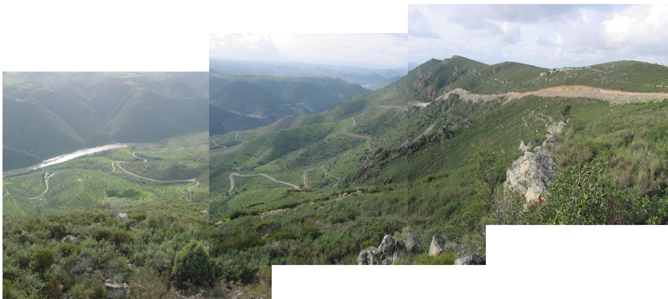
Foto nº 3 – Foto montagem com vista geral do traçado da estrada em causa.
