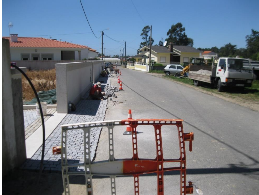
Figura 4.2 – Execução de pavimentação em calçada de uma berma.
