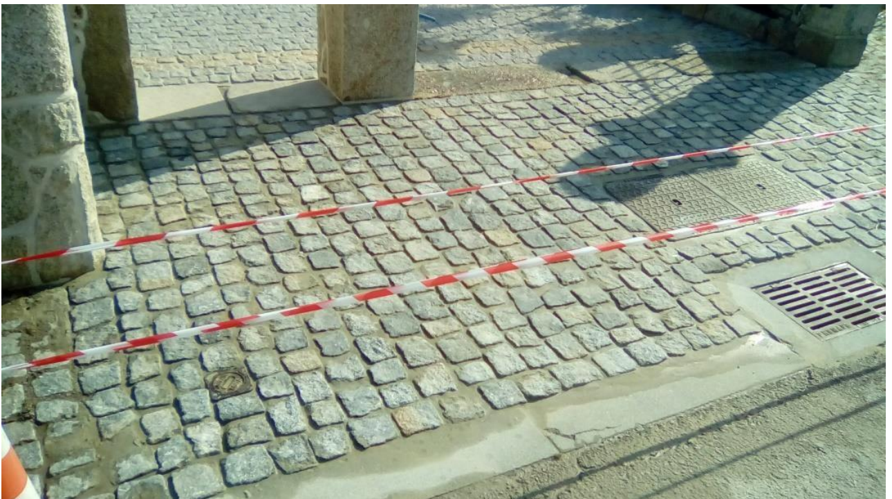
Figura 4.4 – Pavimentação em cubos recuperados de uma antiga estrada com refechamento a argamassa.
