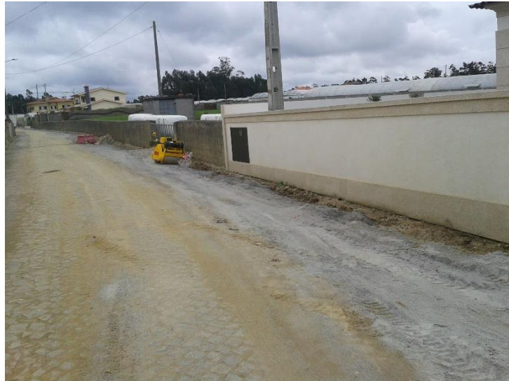
Figura 6.2 – Caminho rural sendo sujeito a abertura de vala para conduta de águas pluviais.
