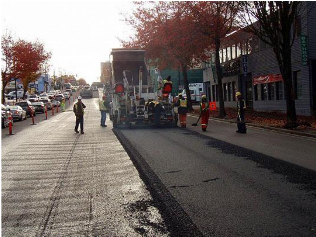
Figura 3.1 – Realização de espalhamento da camada de desgaste.
