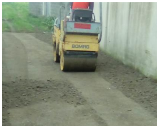
Figura 2.27 - Exemplo de um cilindro vibratório (marca: bomag).
