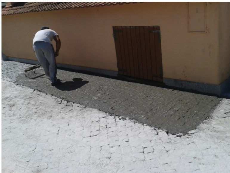
Figura 2.7 – Operário fazendo o espalhamento da argamassa.
