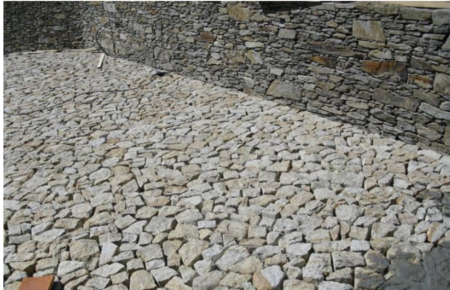
Figura 2.20 - Assentamento tipo malhete.
