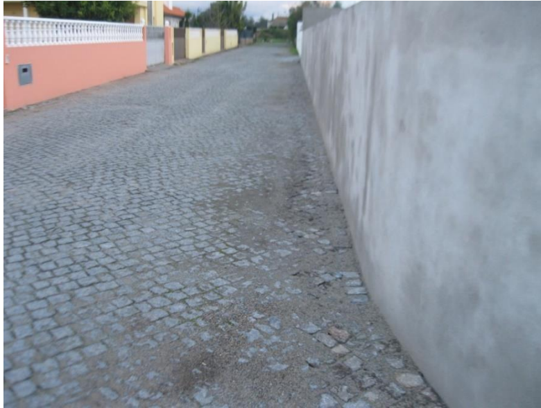
Figura 2.14 – Pequeno arruamento com assentamento em espinha.
