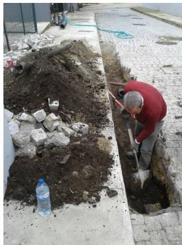
Figura 4.5 – Execução de uma abertura de vala em calçada.
