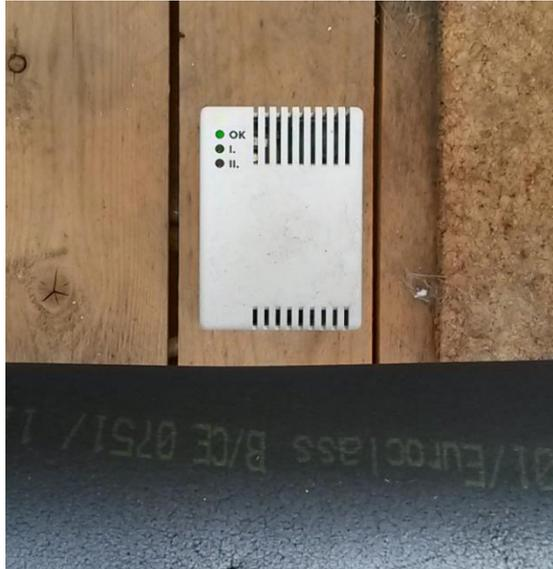
Figura 3.12 – Detetor de fugas de R600a (isobutano) colocado no chão da casa das máquinas.
