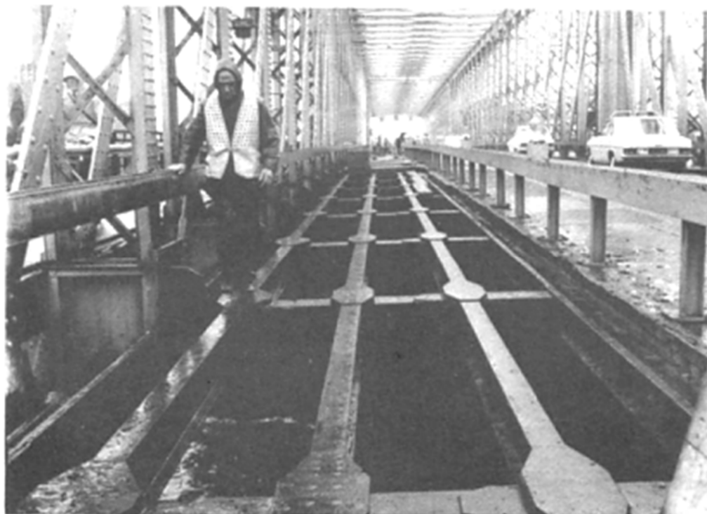
Figura 2.7. - Ponte rebitada em Roterdão onde foram aplicados parafusos de injeção (Nikolovski, 2009).
