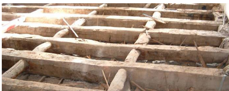
Figura 4. Vigamento e tarugos de um pavimento, Edifício São Domingos, séc. XIX (1856), Porto.
