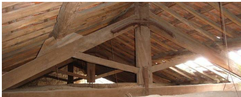
Figura 5. Asna simples de cobertura de madeira do Edifício António Carneiro, séc. XX (1916), Porto.
