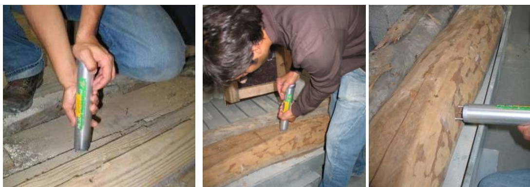
Figura 11. Utilização do Pilodyn para avaliação do estado de conservação de elementos estruturais de um pavimento de madeira, Edifício António Carneiro, séc. XX (1916), Porto.
