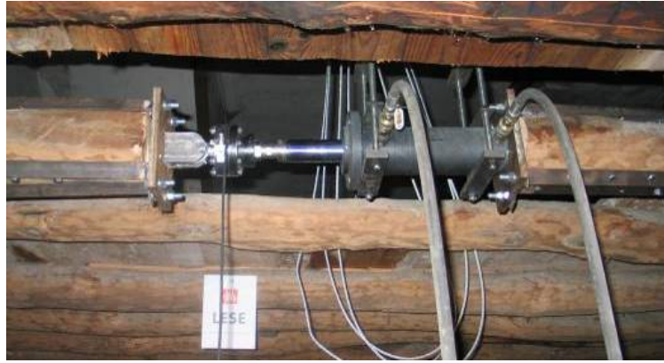
Figura 16. Ensaio com actuador hidráulico em viga de madeira, Edifício António Carneiro, séc. XX (1916), Porto.
