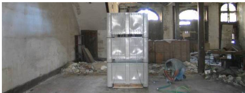
Figura 13. Ensaio de carga em pavimento, Edifício António Carneiro, séc. XX (1916), Porto.
