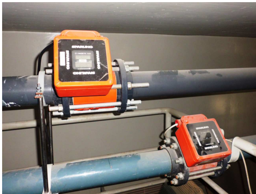
Figura 4.8 – Caudalímetros para medição de valores instantâneos
