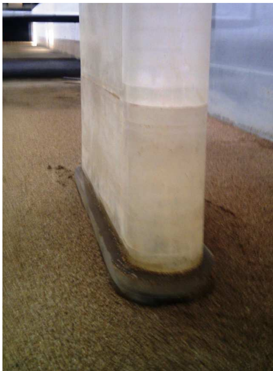
Figura 4.10 – Aspeto final da regularização da areia
