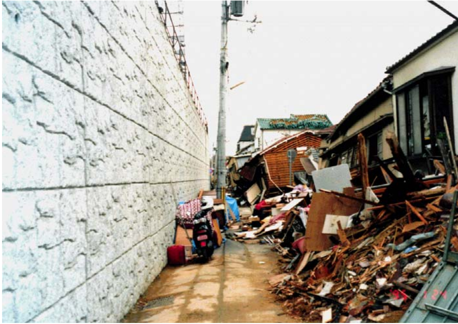
Figura 2 – Aspecto do muro reforçado com geogrelhas localizado em Tanata e estruturas adjacentes após a ocorrência do sismo de Kobe, 1995 ([4]).
