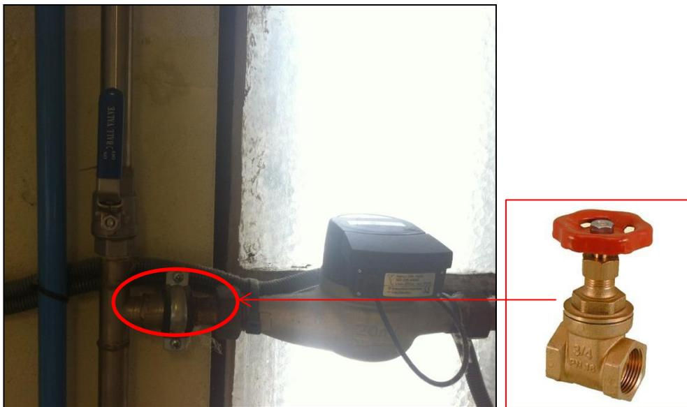
**Figura 25:** Válvula de cunha a ser aplicada, para a fixação do caudal da água injetada.
