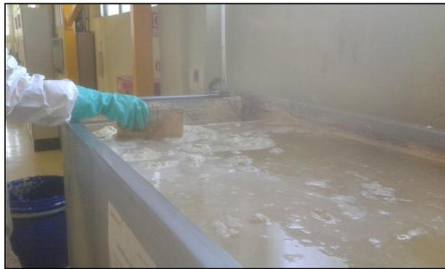
**Figura 27:** Iniciação da limpeza efetuada ao separador óleo/água
