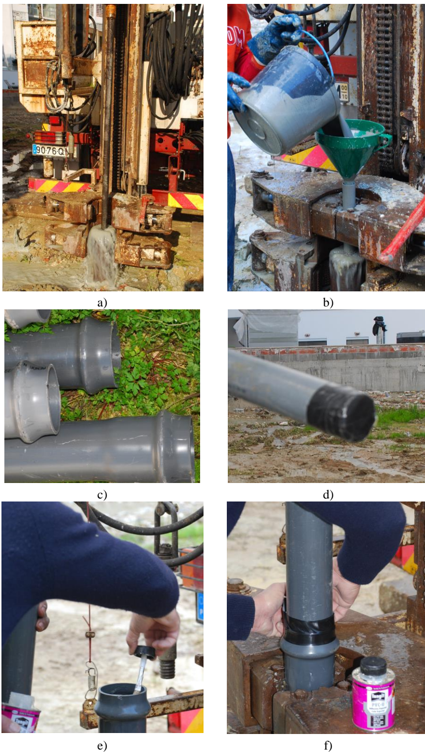
Figura 8.12 – Montagem dos tubos de PVC para ensaios sísmicos no campo experimental: a) aspeto geral da furação; b) colocação da calda de cimento; c) tubos com ligações UNI; d) base do tubo obturada; e) colocação de cola nas uniões entre trechos; f) proteção das uniões com fita adesiva de alta resistência
