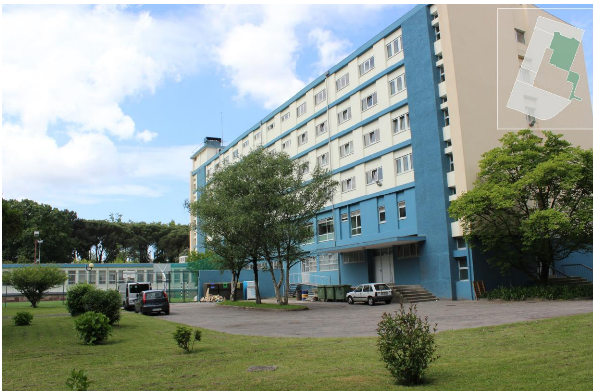
Figura 9 – Zona C da área de intervenção.
