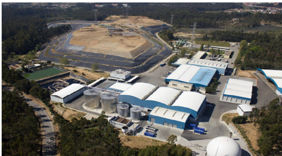
Figura 10 - Instalações da Suldouro em Sermonde, Vila Nova de Gaia
